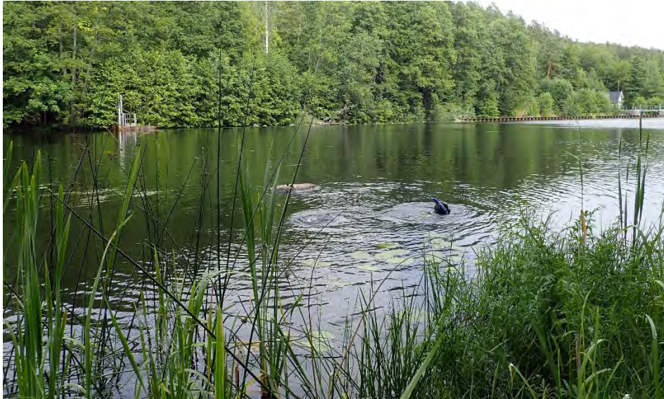
Figur 12. Lokal 11 i kraftverksdamm vid Hemsjö.
