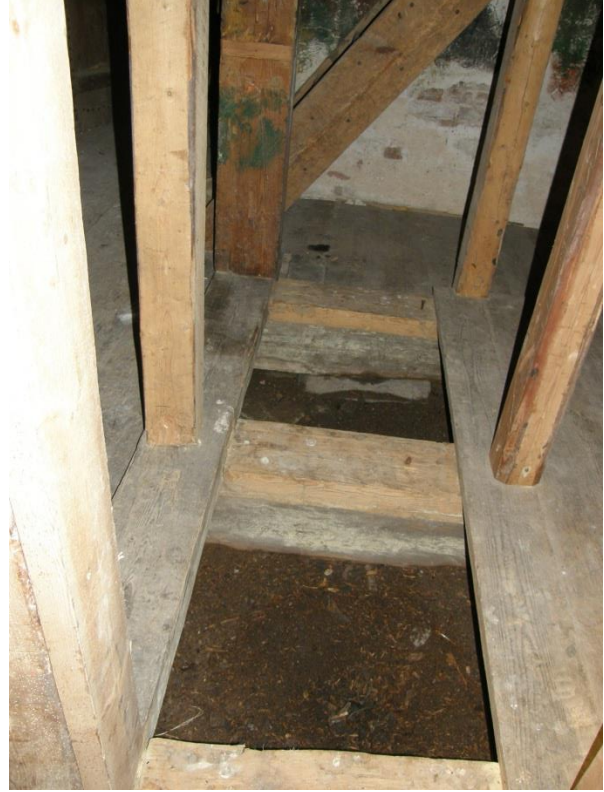
Fig. 16. Saknade golvbrädor på plan 1.
