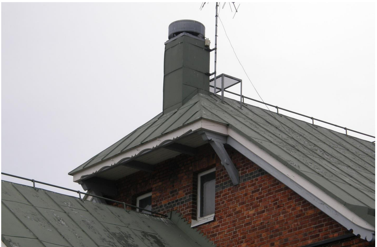
Fig. 10. Vy mot södra vindens gavel, med inklädd skorsten.
