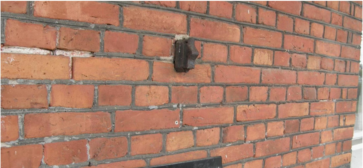
Fig. 20. Bortfallen fog, östra fasaden.
