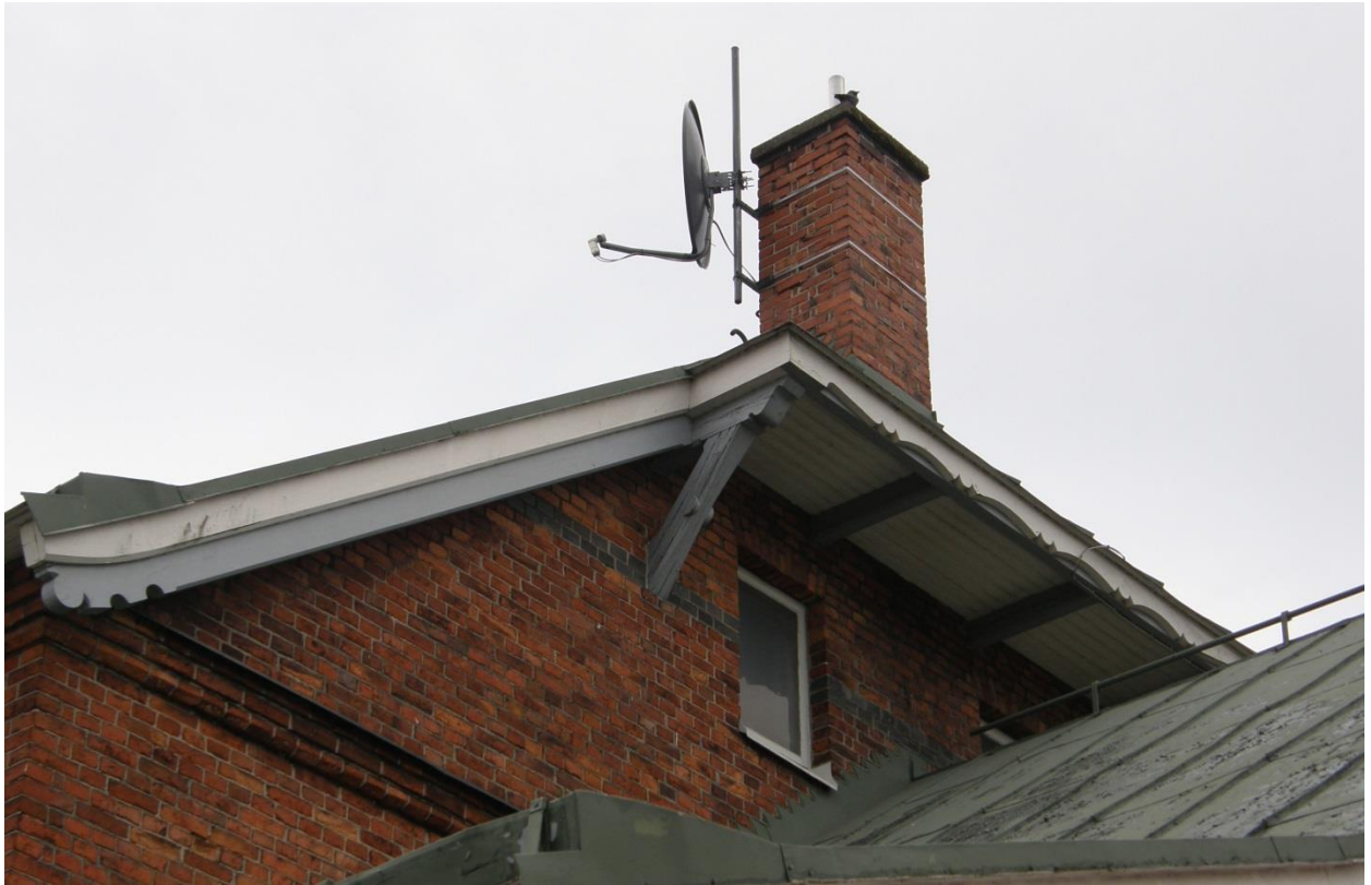
Fig. 9. Vy mot norra vindens gavel, med teglad skorsten.
