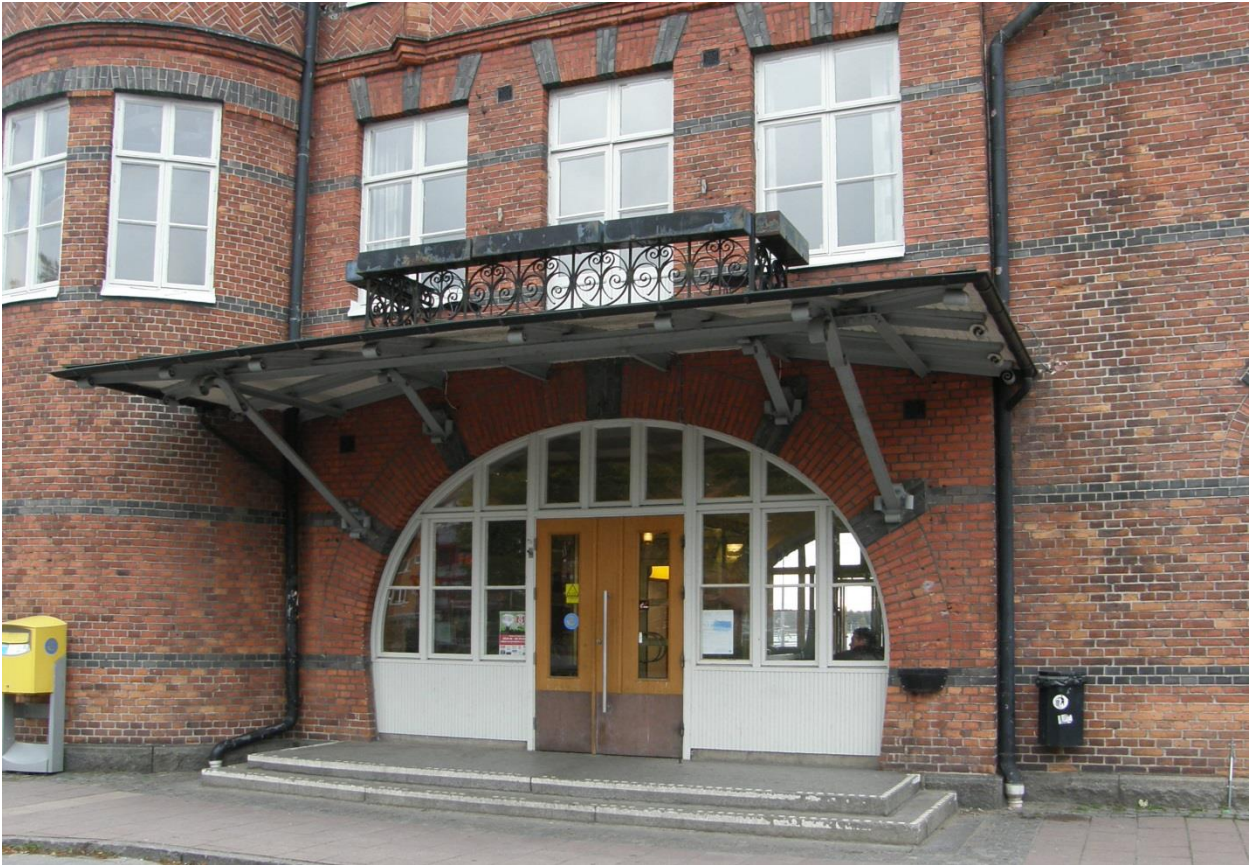
Fig. 7. Det västra skärmtaket, med balkong.
