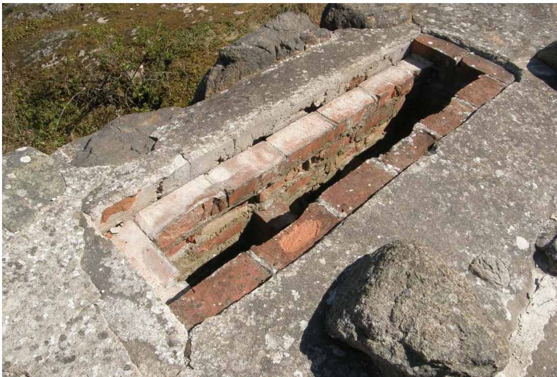
Fig. 19. Lossbrutna tegelstenar vid latrintrumma.
