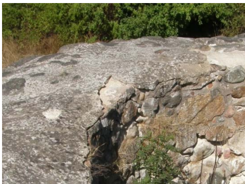
Fig. 4. Sprucken murkrönstäckning.
