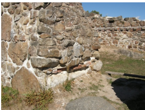
Fig. 10. Västra långsidans portomfattning.
