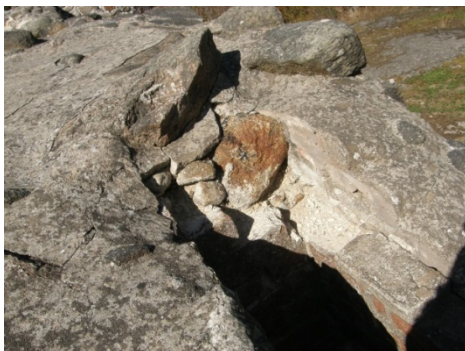
Fig. 6. Skada vid latrintrumma.
