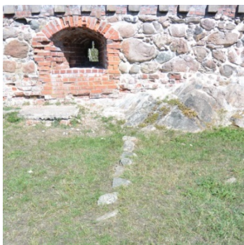
Fig. 17 (t.v.). Raden av stenar är en stenfot till en tidigare korsvirkesvägg. Fig. 18 (t.h.). Anlagd grillplats i söder.
