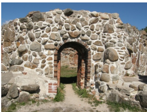
Fig. 12. Södra tornets port.
