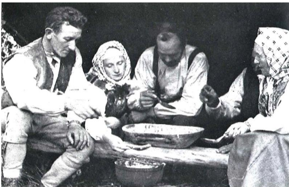
Kvällsvard i slobboden. Var och en doppar sin brödbit i flottpannan. Foto: Nordiska museet.
