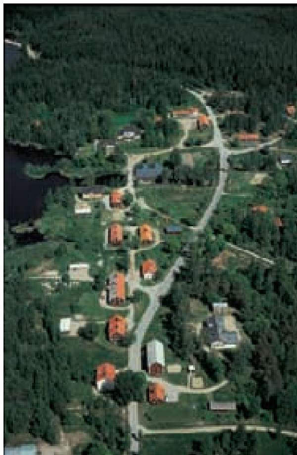
Väg 741, "Strömbackavägen". Här passerar den gamla vägen genom Strömbacka bruk, i en strikt uppbyggd struktur. Den nya vägen går i en båge utanför bruket utan sammanhang med det gamla mönstret.
