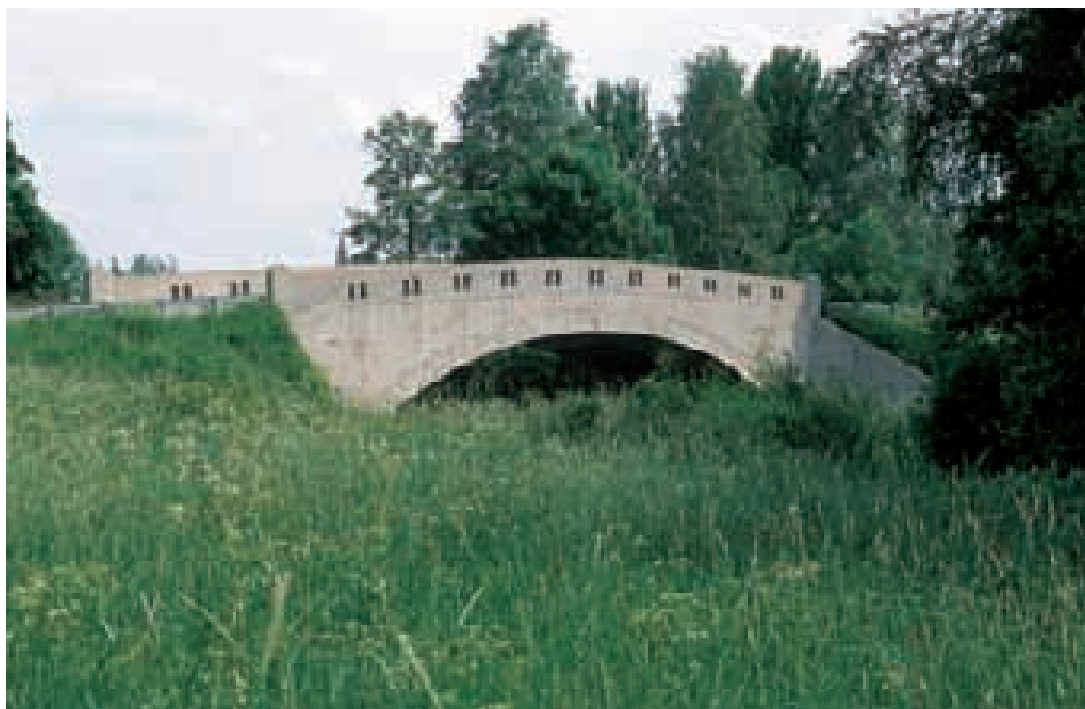
Väg 579. Betongbro över Testeboån från 1916. Foto: Michael Ahne, Läns museet Gävleborg
