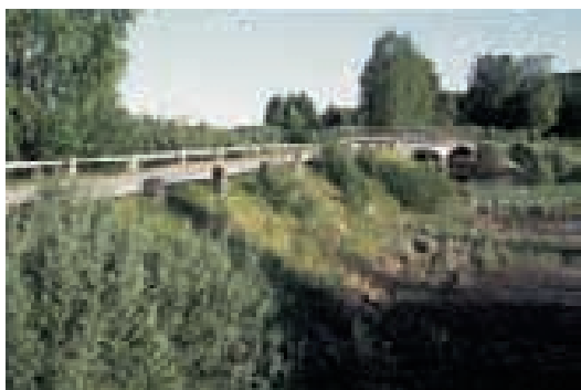
Väg 500. Bron från 1950-talet smälter väl in i vägmiljön.
