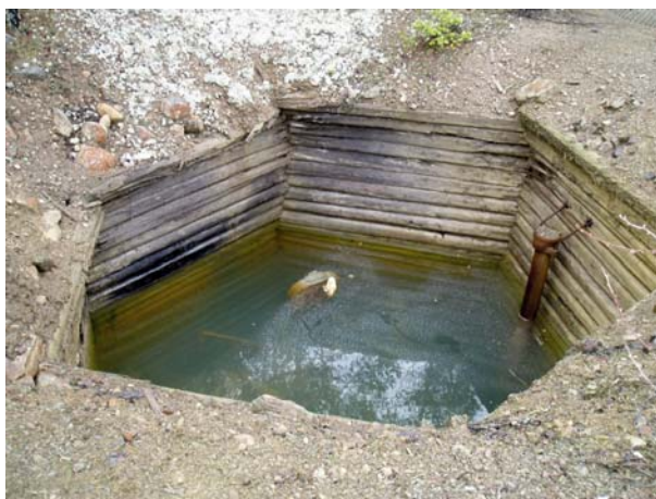
Figur 1. Ett av järn- och zinkmalmsgruvan Sågmurs timrade schakt (Foto: Helene Boström, Länsstyrelsens bildarkiv).
