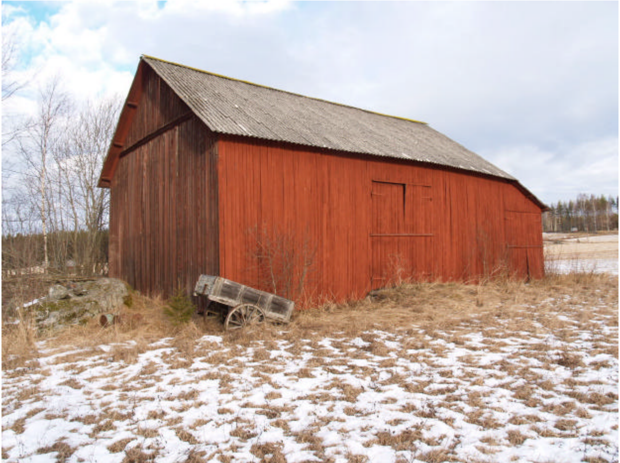
Besiktigad lada i Ockelbo.
