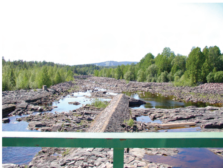
Figur 1. Torrfåra vid Dönje kraftverk i Ljusnan
