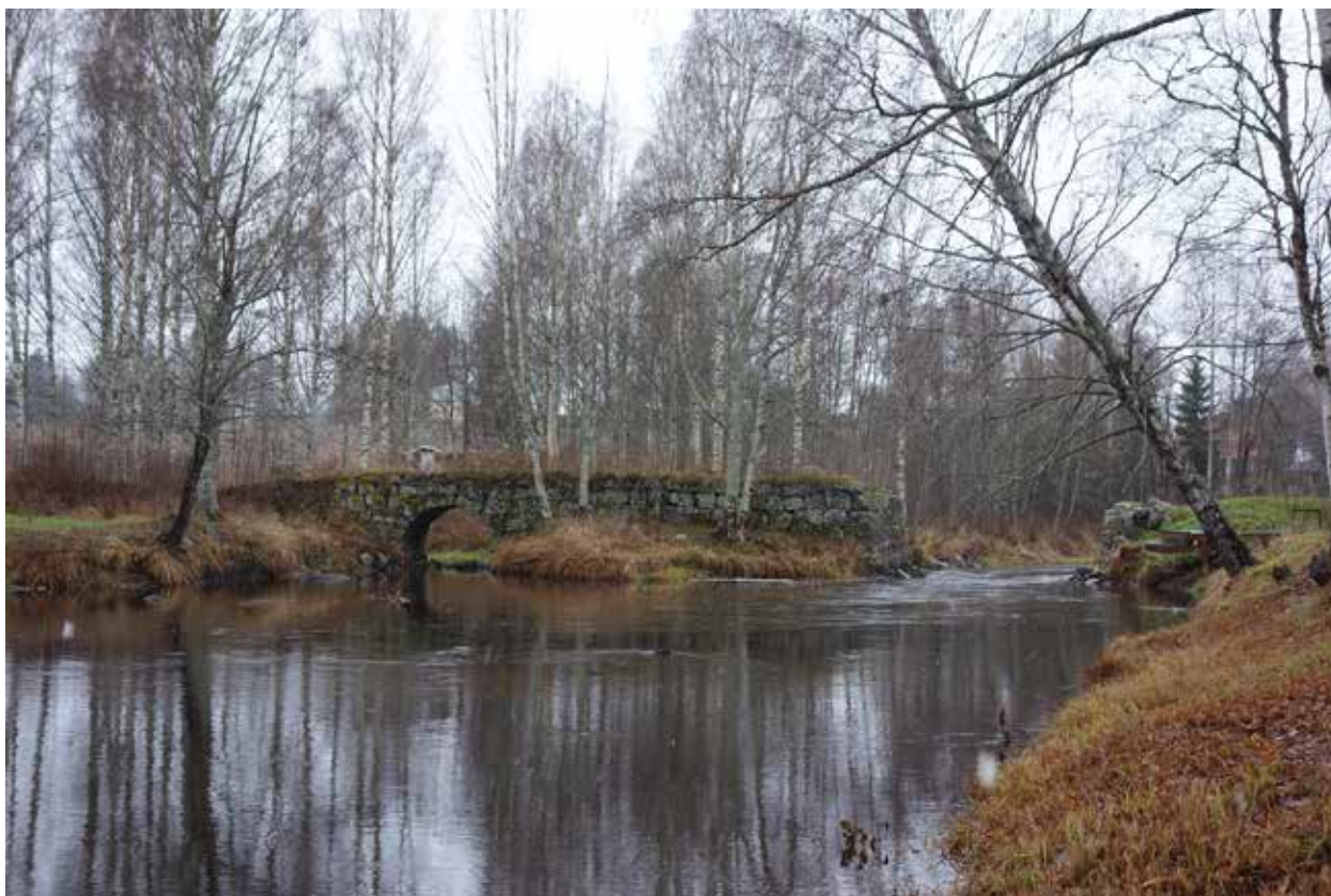
Fig. 153. Stenbron (Bollnäs 2:1) har ett bevarat spann. I mellanrummet har det troligen varit en träbro.
