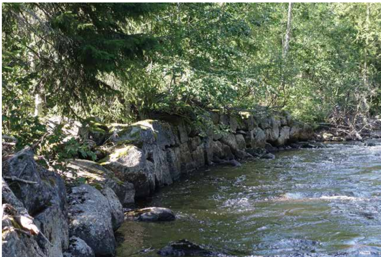
Fig. 65. Strandskoning av fint huggna och vällagda stenar (48) som följer en kurva i ån.
