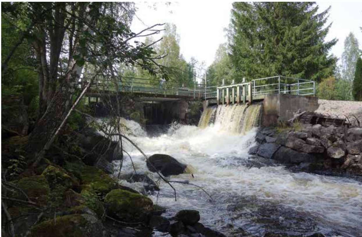
Fig. 111. Nedre Bergforsdammen (144H). Den första dammen kan ha byggts i samband med att Bergfors bruk etablerades i slutet av 1850-talet. Dammen renoverades eller byggdes om troligen 1957.
