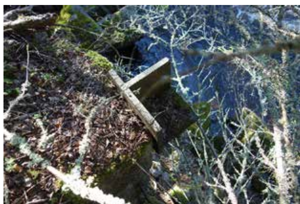
Fig. 17. Järnbalk fastsatt i sten i dammvallen (objekt 2).
