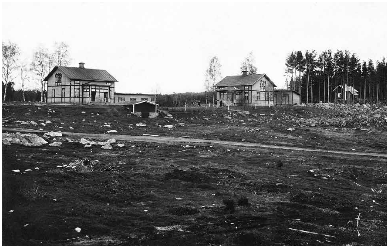
Fig. 107. Arbetarbostäder vid Åsbackadammen och löskarlsbaracken till höger (röda stugan, vår inventering 108H). Foto från 1916.
