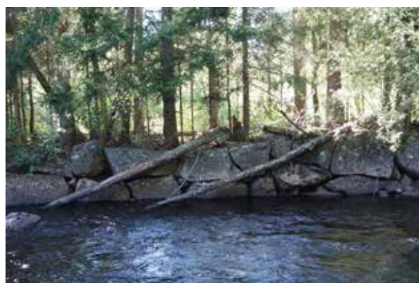
Fig. 67. Strandskoning av huggna stenar (50).
