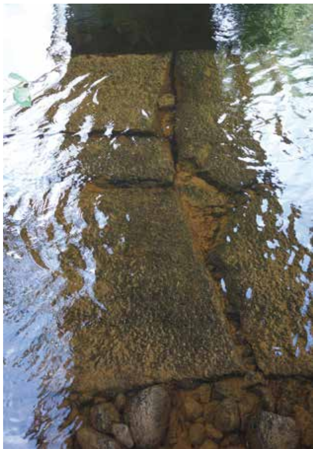
Fig. 165. Fundament av huggen sten ligger på botten av ån under järnvägsbron (77).
