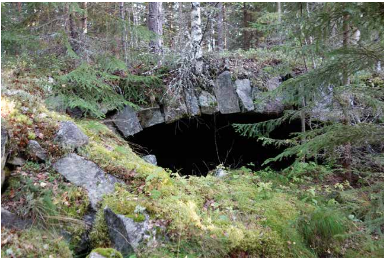
Fig. 82. En av två valvade stenkällare vid Lillmarksholms bruk (Bollnäs 172:1).
