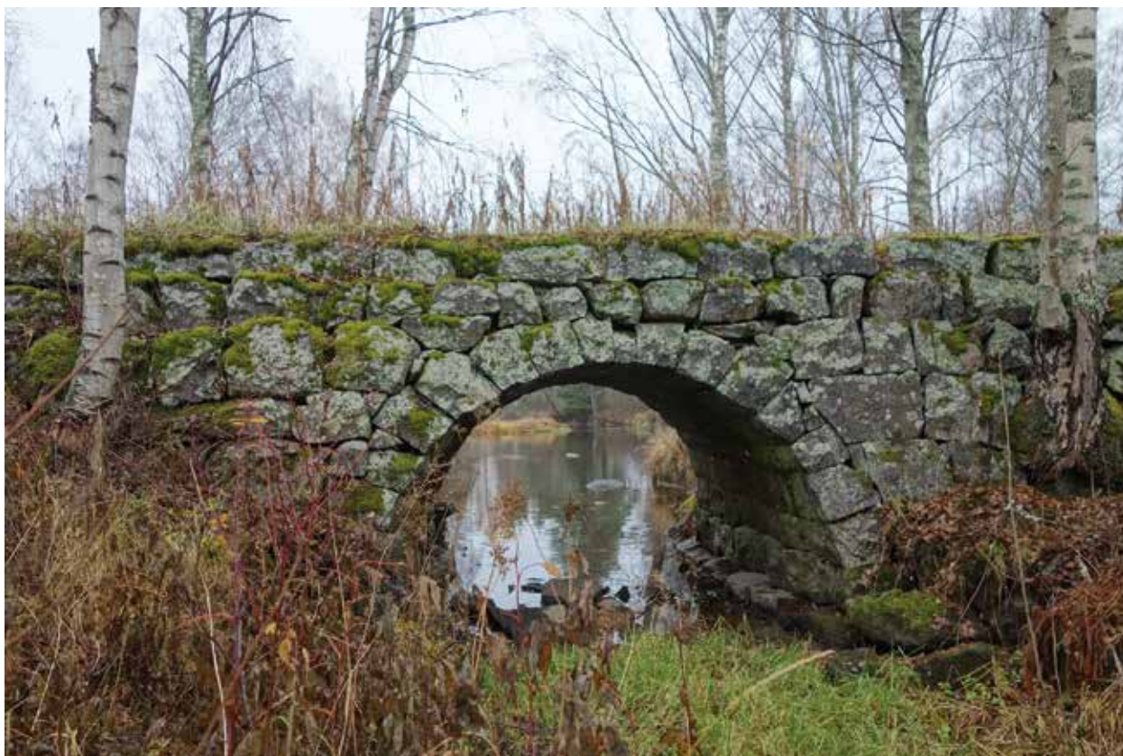
Fig. 154. Ett bevarat fint stenspann, stenvalv, i bron (Bollnäs 2:1).
