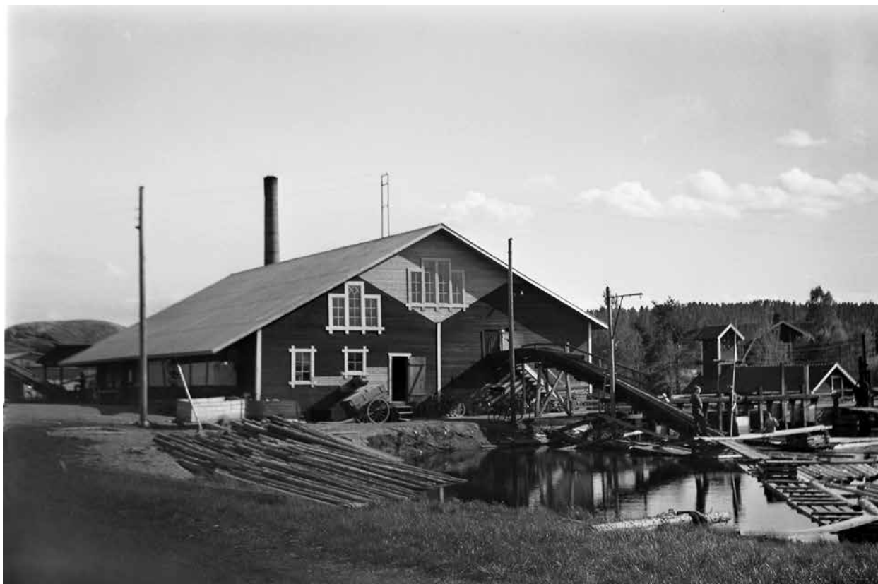
Fig. 136. Holmo såg med ihopbyggda såghus. Kraftstationen med kur på taket till höger.
