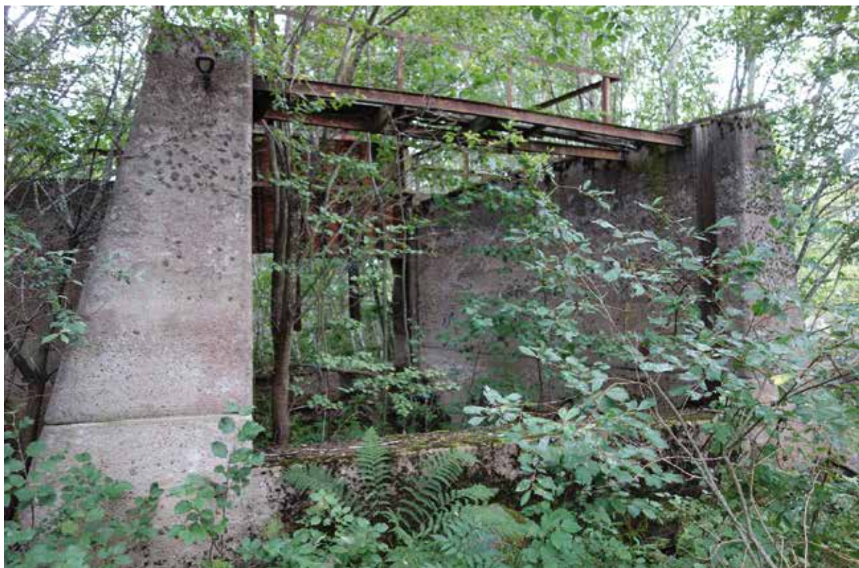
Fig. 128. Kvarvarande damm vid Holmo (126H), med trasiga dammluckor efter vårfloden 1985, och shyöväxt.
