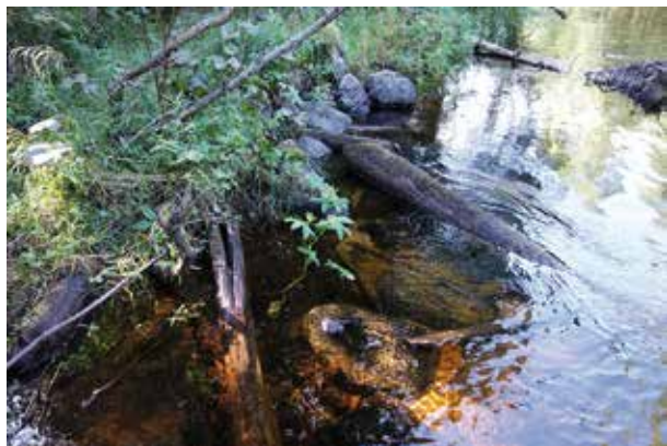
Fig. 52. Strandskoning (17), av stockar i strandkanten.
