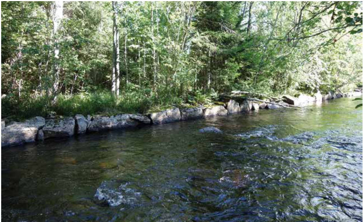
Fig. 59. Strandskoning (33) med en del huggna stenar. Kan vara tillkommen 1957 i samband med upprustning av flottleden.
