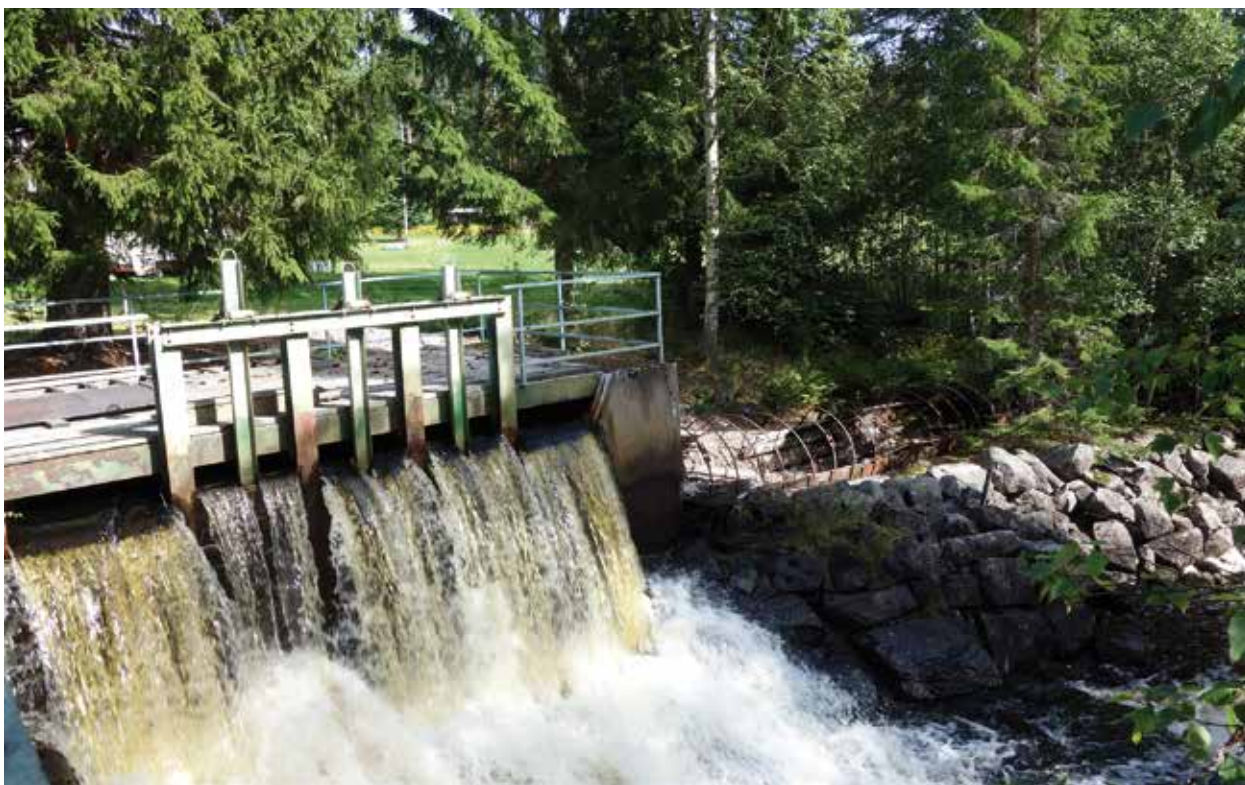
Fig. 112. Östra delen av dammen vid Nedre Bergfors (144H). Bakom dammen syns den delvis raserade trätuben, tillloppstuben till kraftstationen.
