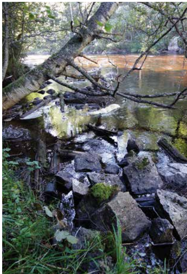
Fig. 53 (till höger). Stenkista (29). Kistan har haft minst fem timrade fack fyllda med huggen sten. Idag är kistan delvis raserad och stockarna ligger lösa.
