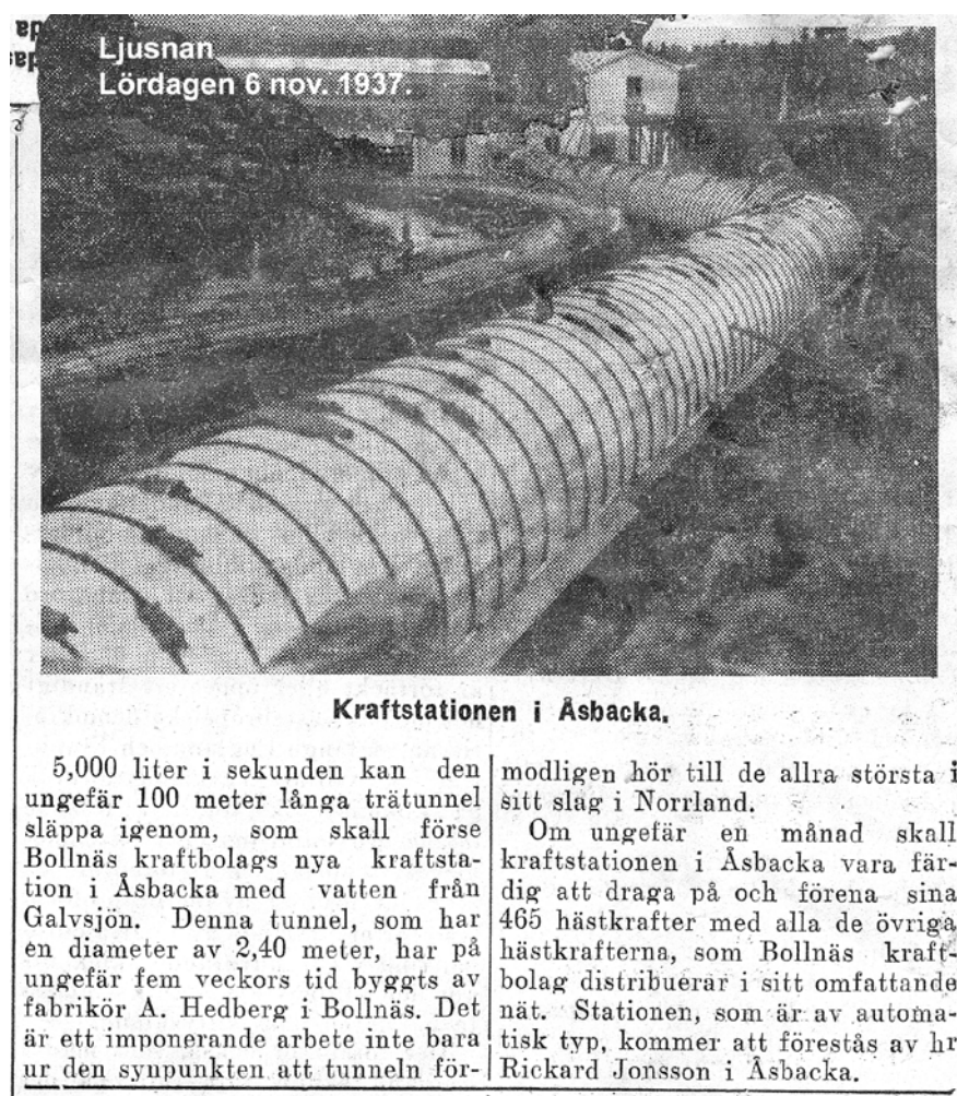
Fig. 97. Tidningsartikeln i Ljusnan 6 november 1937 berättar om den nya kraftstationen i Åsbacka. Invid den nya trätuben syns en flottsranne parallellt.
