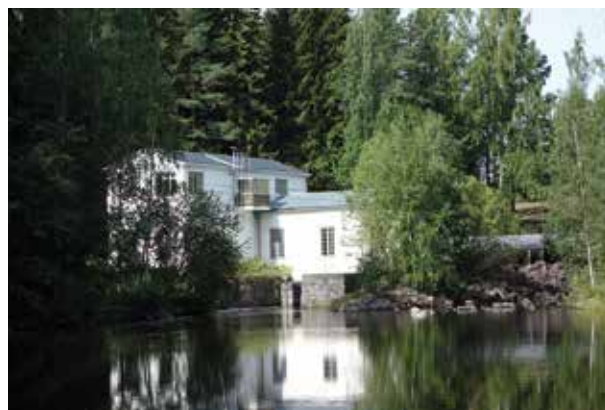
Fig. 94. Kraftstationen vid Övre Bergforsdammen.
