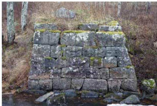
Fig. 152. Stenbrons södra brofäste (Bollnäs 2:1).
