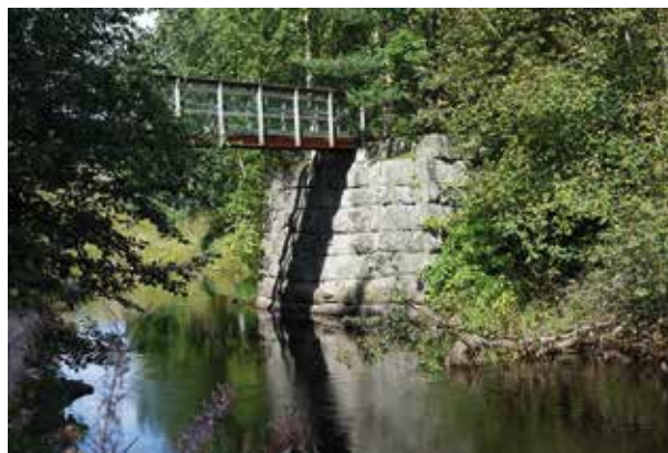
Fig. 166. Norra brofästet till gamla landsvägsbron, av huggen kallmurad sten (Bollnäs 235:1).
