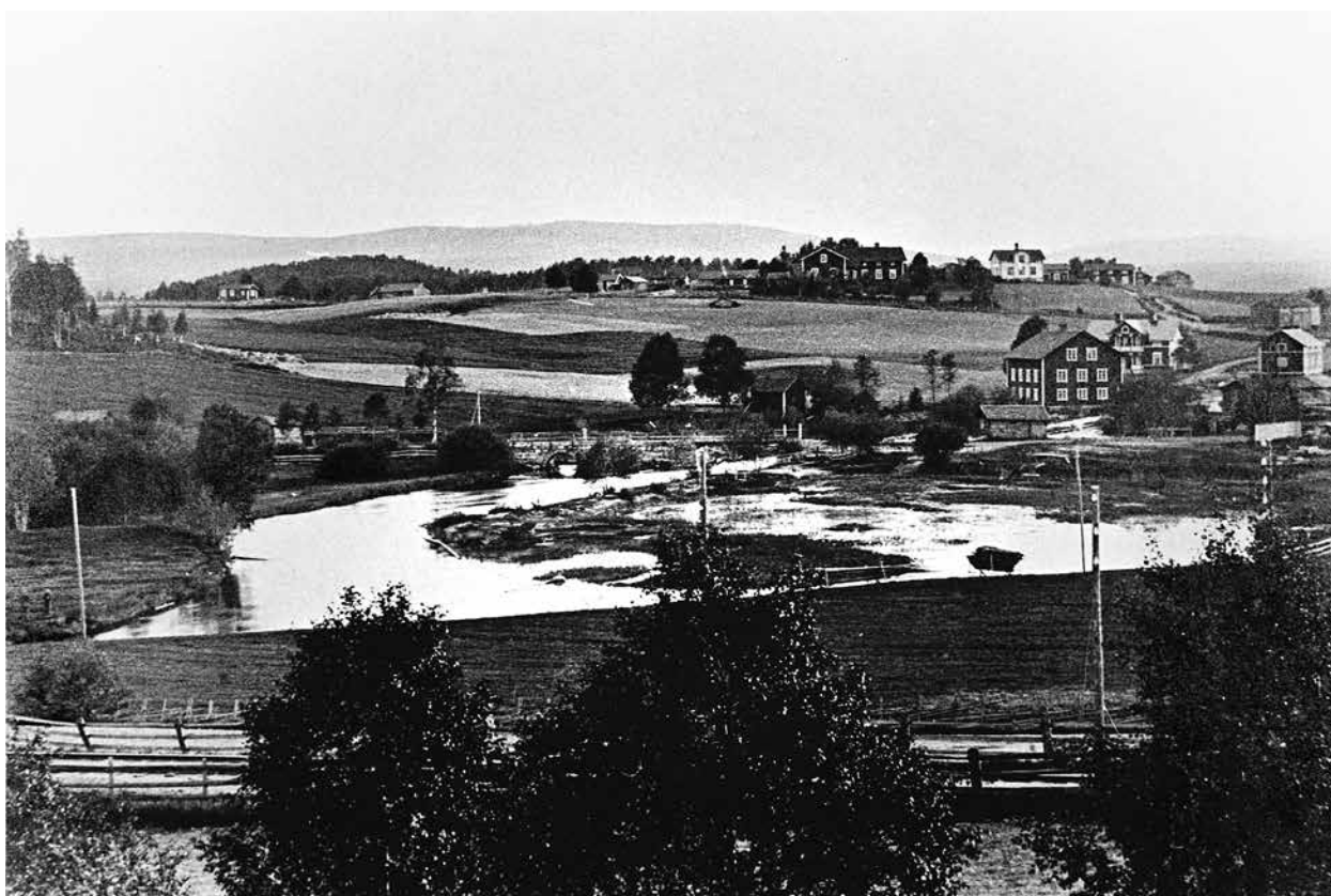
Fig. 158. Röste gamla kvarn till höger med gaveln hitåt, rödfärgad 2,5 våningar hög byggnad. Bakom kvarnen syns Kvarngården. På bilden även bron med stenvalvet (Bollnäs 2:1). Foto före 1926.
