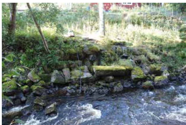
Fig. 15. Damm (1) på åns södra sida, delvis nedrasad i ån. Huggna stenar, kallmurad och med förankringsjärn.
