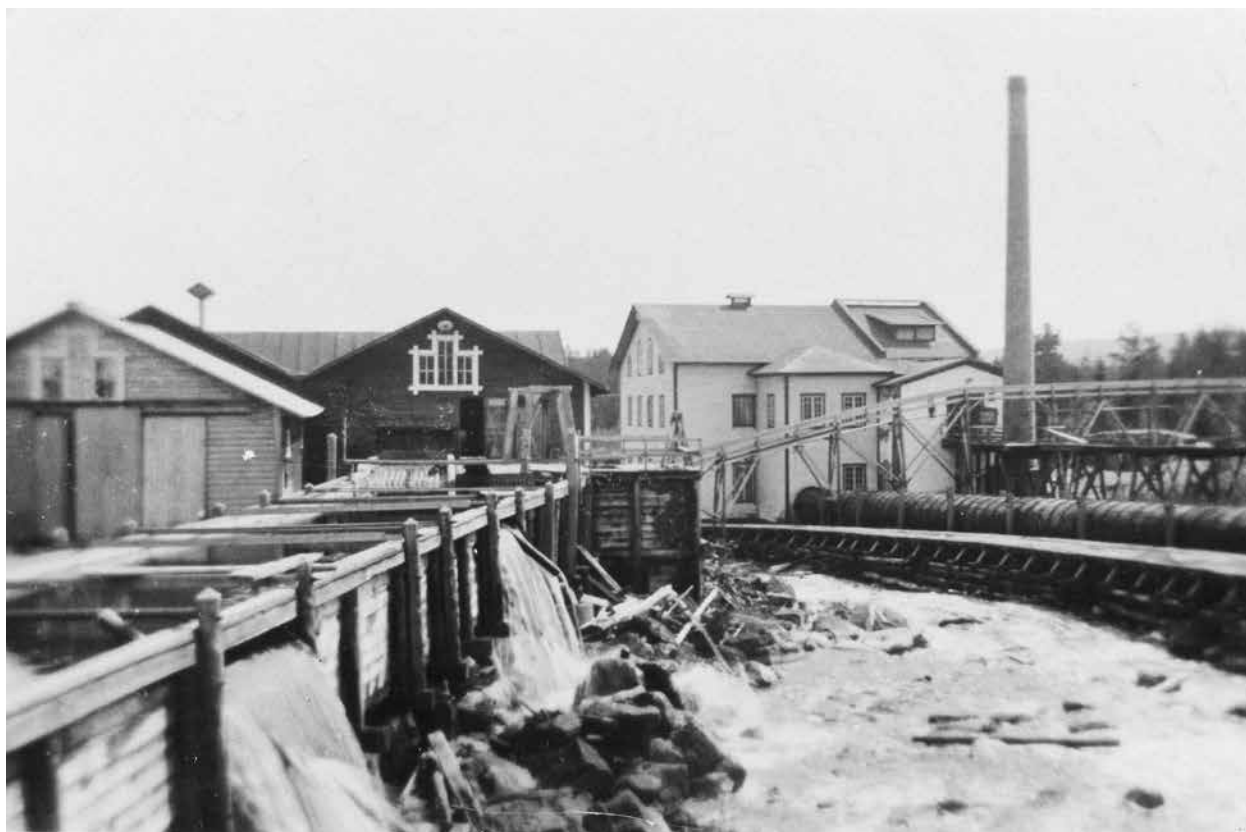
Fig. 104. Åsbacka såg till vänster i bild. Vattenränna in till sågen. Träsliperiet är den stora vita byggnaden med skorsten och med en vattentub som leder in i den. Flottningsränna parallellt med tuben. Fotograferat från dammbron 1936.
