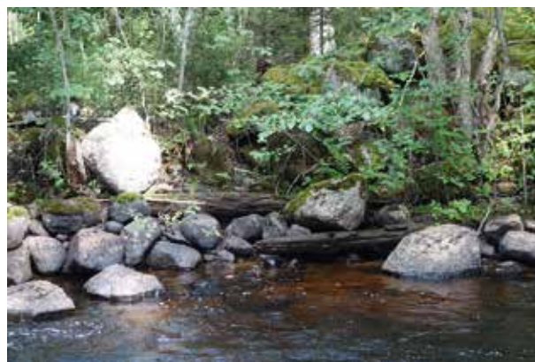
Fig. 66. Strandskoning av huggna stenar (46), samt stockar.
