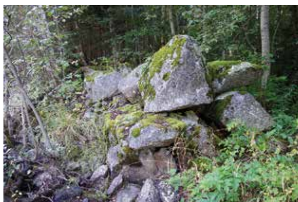
Fig. 36. En 20 meter lång stenkista till flottningen (26).
