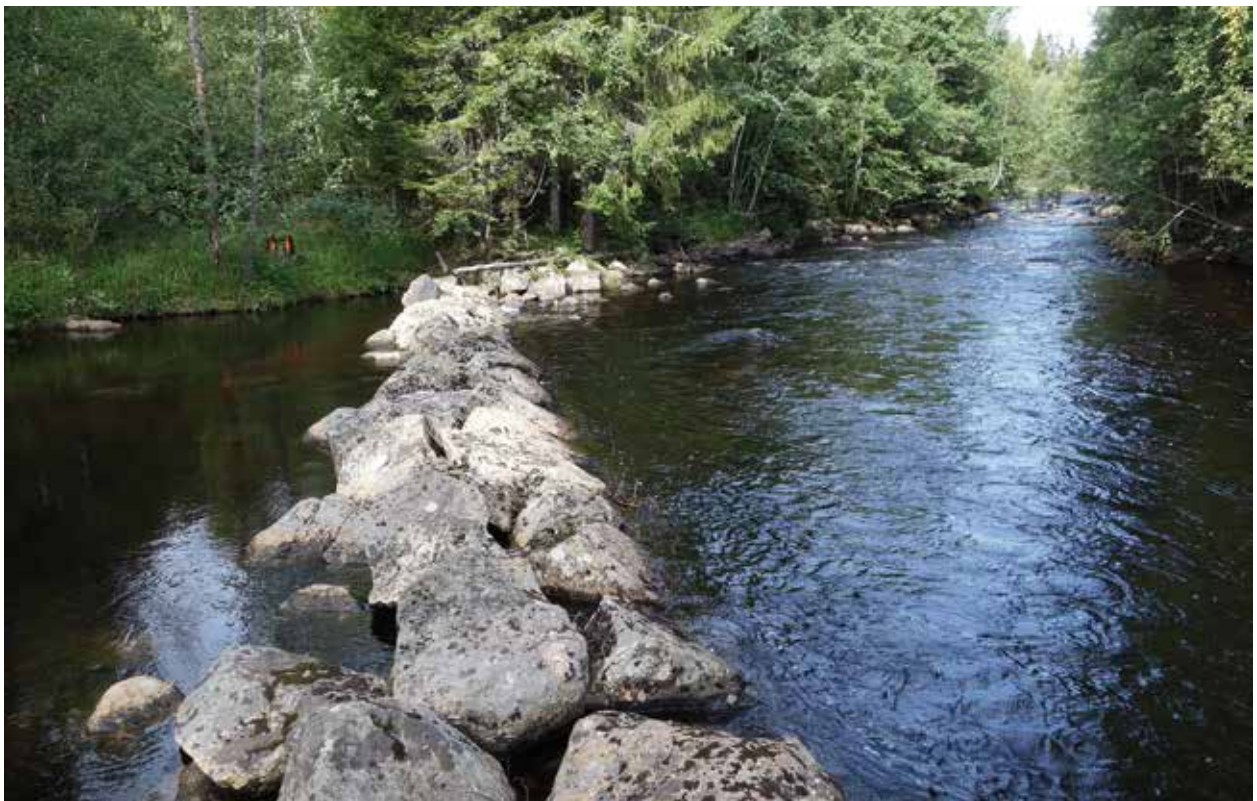
Fig. 78. Styrkista (63), 25 + 10 meter lång, med sluttande sida ut i forsen och rak sida mot land. Har haft timrade fack.
