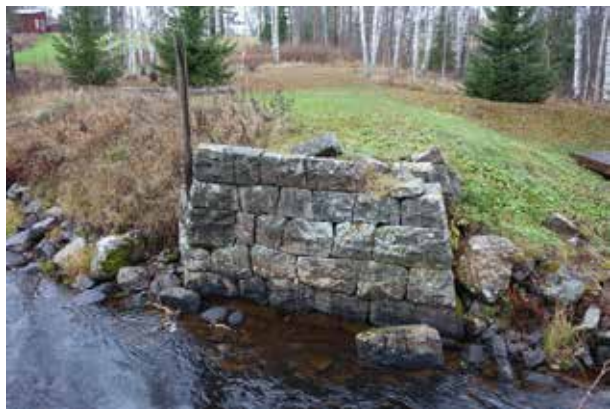
Fig. 151. Stenbrons norra brofäste (Bollnäs 2:1).
