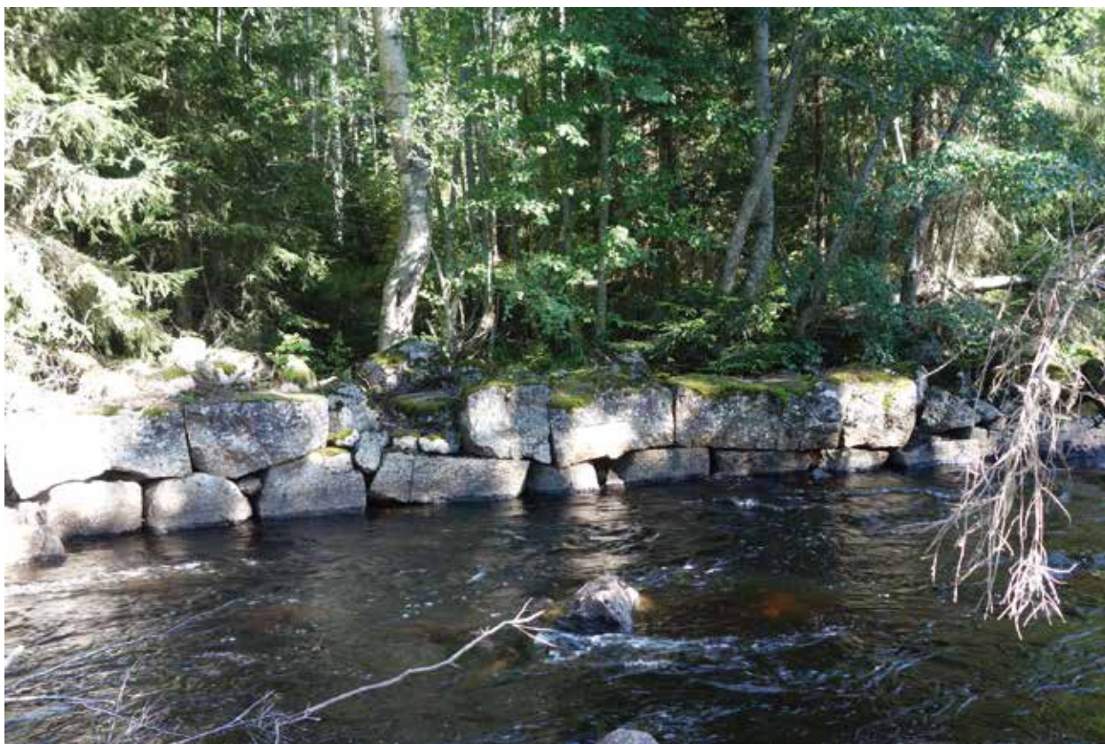
Fig. 68. Strandskoning av fint huggen och vällagda stenar (49) som följer en kurva i ån.
