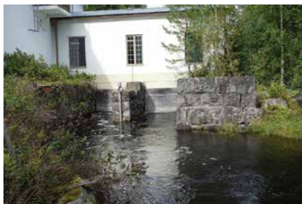
Fig. 95. Stensatt kanal (68) i utloppet från kraftstationen.
