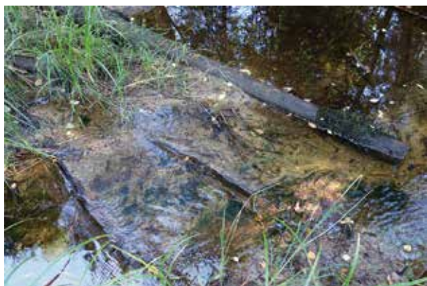
Fig. 56. Flottningsränna (31) med tvärgående stockar.
