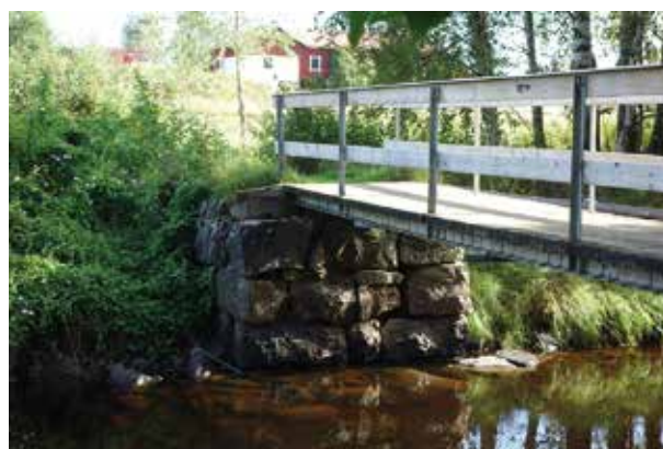
Fig. 140. Brofäste av huggen sten (75) på åns norra sida.
