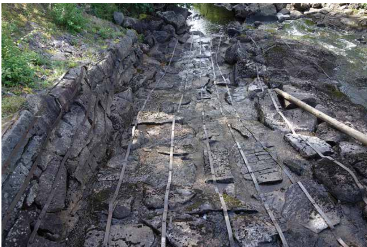
Fig. 86. Stensatt skirbord i ett av utskoven vid dammen Övre Bergfors. Bordet är kompletterat med järnband i botten och på stankenterna, en konstruktionstyp vi inte sett någon annanstans.
