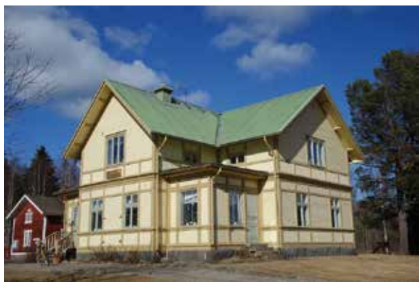
Fig. 38. Eventuellt var delar av detta hus tidigare herrgården vid Nyfors. Byggnaden ska ha flyttats från Nyfors för att bli komministerbostad i Arbrå, men är nu kyrkans ungdomshus.
