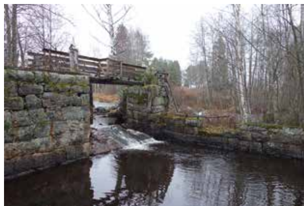
Fig. 147. Kvarndammen i Röste (130H) samt en del av den stensatta kanalen vid dammens utskov.
