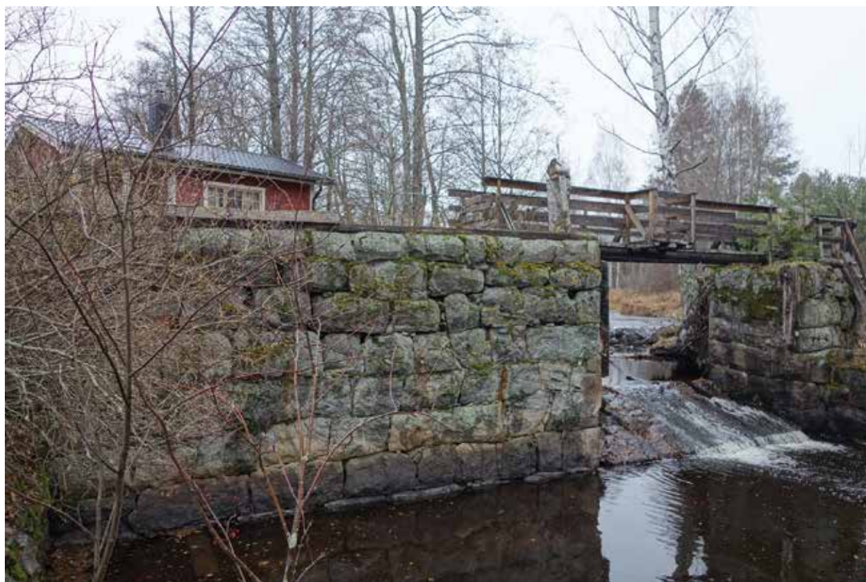
Fig. 148. Kvarndammen i Röste (130H) med fin stensättning av huggen sten i 7–8 skikt.
