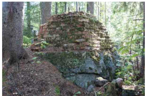
Fig. 91. Mitt i den tidigare sågverksbyggnaden finns två stycken höga fundament av huggen sten och tegel.
