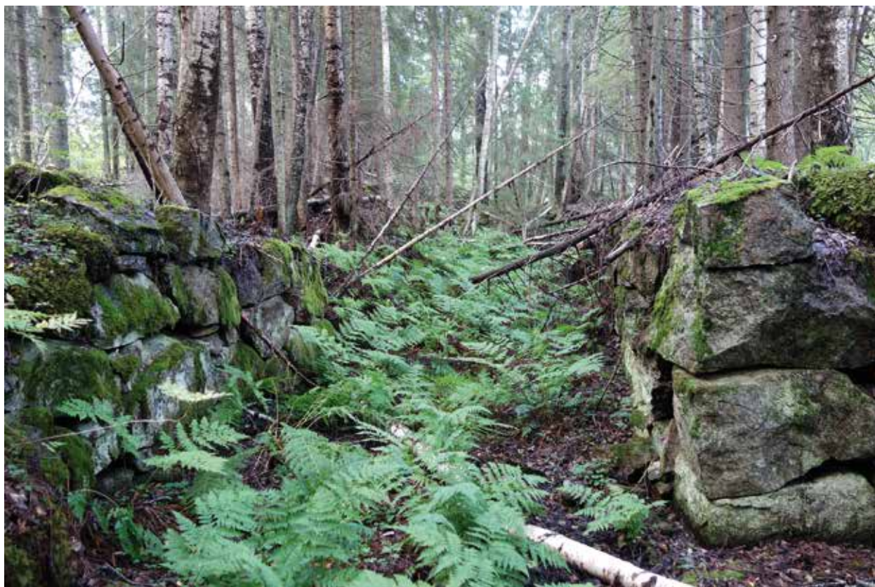
Fig. 31. Stensatt kanal vid Nyfors hammare, smedja, spikfabrik eller kraftstation (9, 167H). Kanalen är intill 1,7 m hög. Flera stensatta terrasser finns i området.
