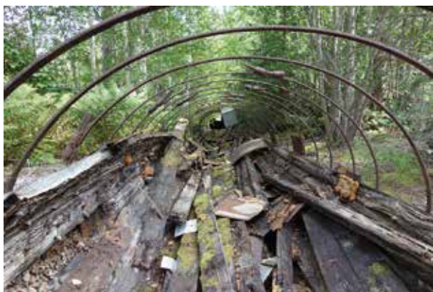
Fig. 117. Den delvis raserade tilloppstuben mellan Nedre Bergforsdammen och kraftstationen.
