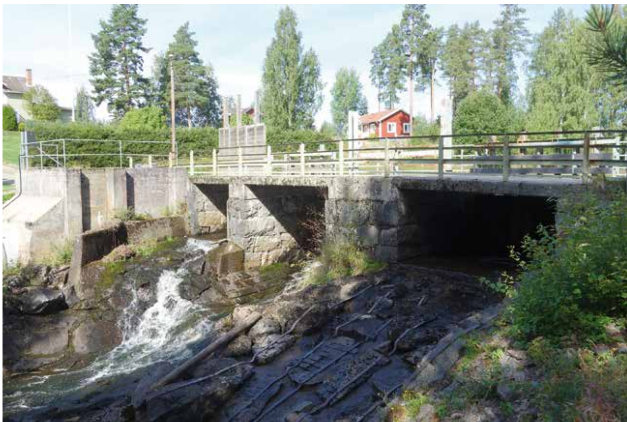
Fig. 85. Övre Bergforsdammen idag, vilken dämmer upp Åsbackasjön. I dammen (111H) är tre utskov, samt i dammens bortre västra del en påbyggnad av betong varifrån en tub leder till kraftstationen nedströms. Foto mot nordväst.
