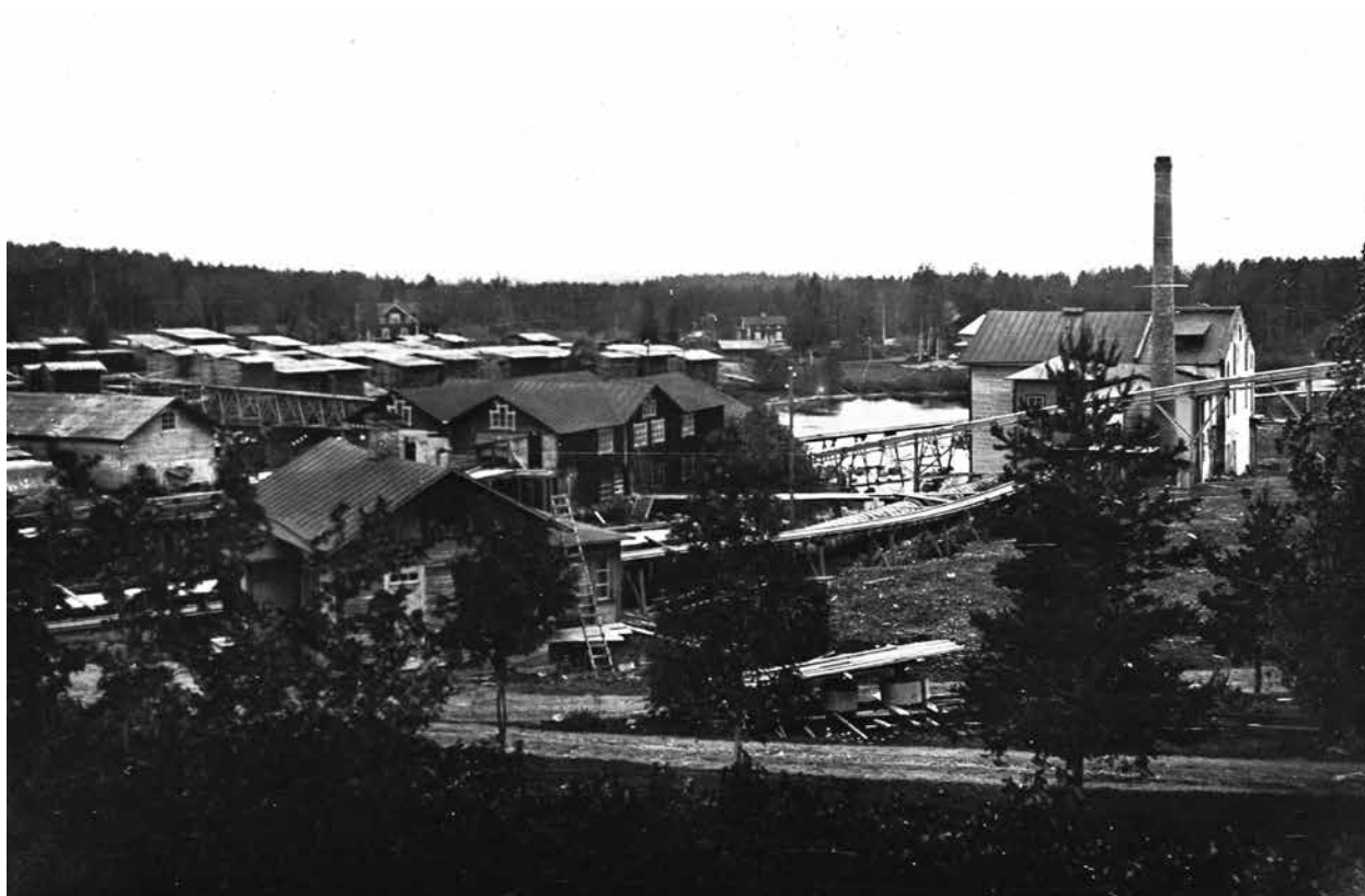
Fig. 105. Åsbacka såg till vänster. Träsliperiet är den stora vita byggnaden med skorsten och med en vattentub som leder in i den. Fotograferat från herrgårdsbacken under 1930-talet.
