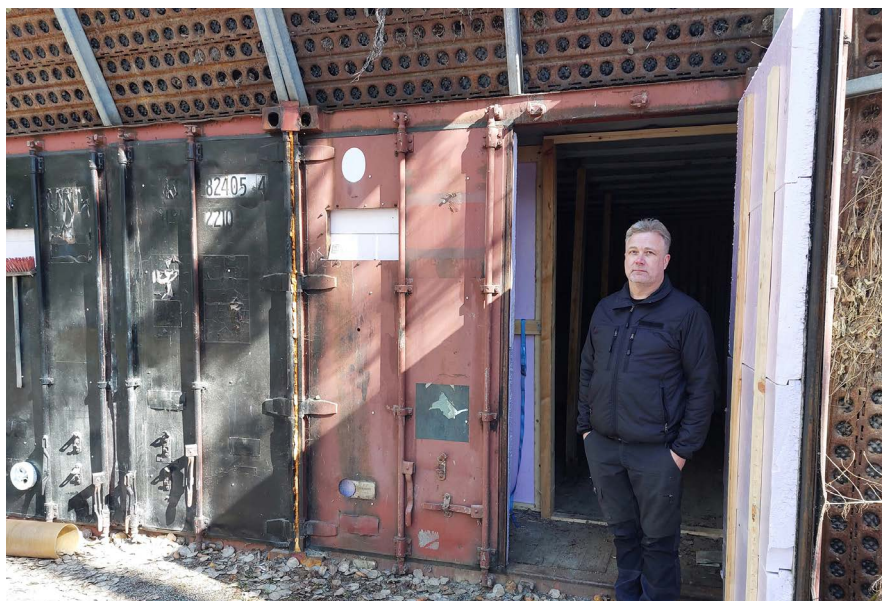
Potatislager byggd av sjöcontainer.
