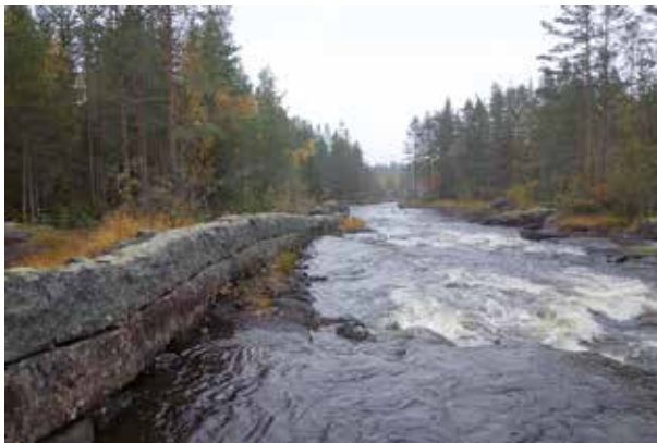
Fig. 174. Ledarm (119), 70 m lång (N-S), 2 m bred och 0,8 m hög, av 0,8–1,5 m långa och 0,4 m breda och höga huggna stenar i två skikt på strömsidan, ihopsatta med järnband. Inåt land är natursten och skarpkantad sten. Delvis övermossad. Ansluter till moränstrand i S och avslutas i N mot större stenblock. Belägen på åns V strand. Foto mot N.
