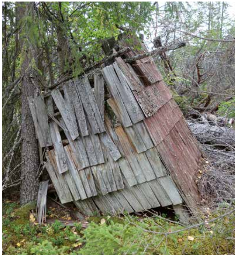
Fig. 23. Dass (36), troligen till "Storkojan", 1,5 x 1,5 m stort och 2 m högt. Byggt av reglar av granslanor, klätt med handspäntat furuspån i tvålagstäckning. Delvis rödfärgat. Beläget ca 15 m N om åkant. Foto mot V.
