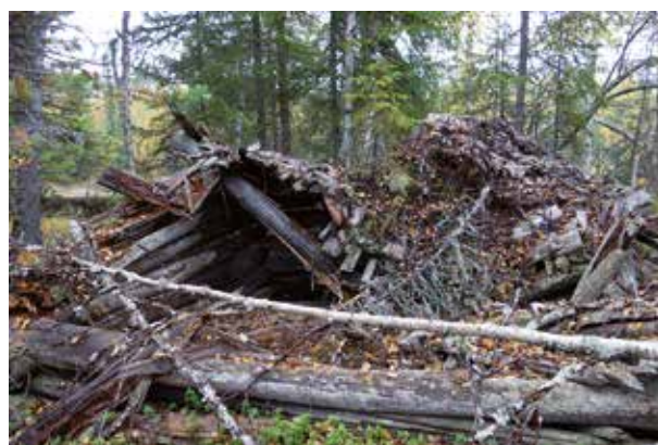
Fig. 135. Myrslätterlada eller flottarkoja (109). 5 x 4 m (NV–SÖ), helt raserad förutom 2–6 delvis bevarade timmervarv. Runda timmerstockar. Belägen ca 10 m SV om ån, med myrmark i S–SV. Foto mot NÖ.
