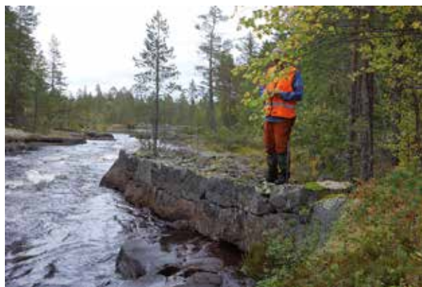
Fig. 72. Ledarm (64), 11 m lång (Ö-V), 1,5-2 m bred och 1 m hög. Av intill 1 m långa huggna stenar mot forsen, i 2 skikt sammanhållna med järnband samt småsten bakom mot landsidan. Ansluter i Ö mot berghäll och i V mot strandklippa. Belägen på åns S strand. Foto mot Ö.
