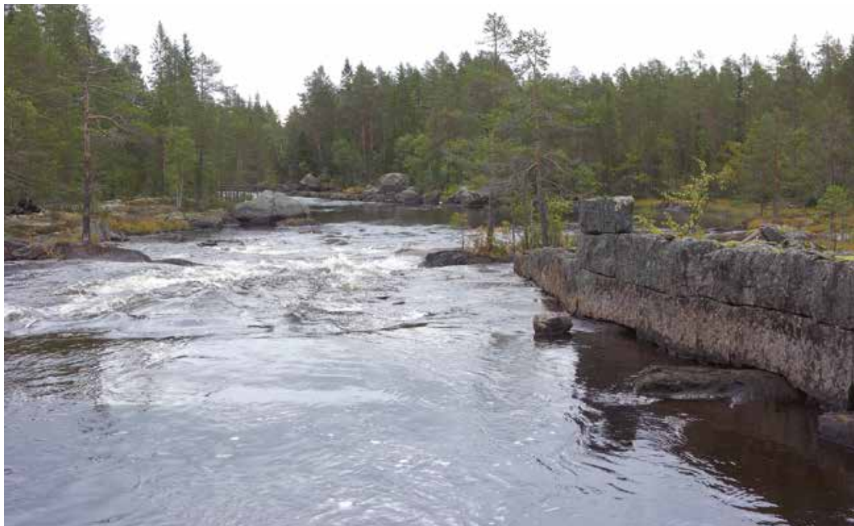
Fig. 98 och 99. Dammvallar (19) på båda sidorna om ån och delvis i åfäran. S sidan: 25 m lång (Ö-V), 2 m bred och 0,9 m hög, av en rad huggen sten, 2 m långa och 0,4 m höga, ihopsatta med järnband, i 2 skikt. Synliga borrhål i stenarna. Mot landsidan är vallen sluttande och består av 0,25–0,7 m stora naturstenar och skarpkantade stenar. N sidan: 28 m lång (NÖ-SV), 2 m bred och 0,9 m hög, av en rad huggen sten, 2 m långa och 0,4 m höga, ihopsatta med järnband, i 2 skikt. Synliga borrhål i stenarna. Mot landsidan är vallen sluttande och består av 0,25–0,7 m stora naturstenar och skarpkantade stenar. De huggna stenarna har slät sida mot strömmen, men inte slät sida mot stranden. Ansluter i V resp NV till strandkant, går över hållar i forsen. I Ö nedanför forsen är en mindre stenhög. Dammvallarna avslutas i ett dammfäste, som består av 3 skikt huggen sten. Foto mot SÖ och NV.
