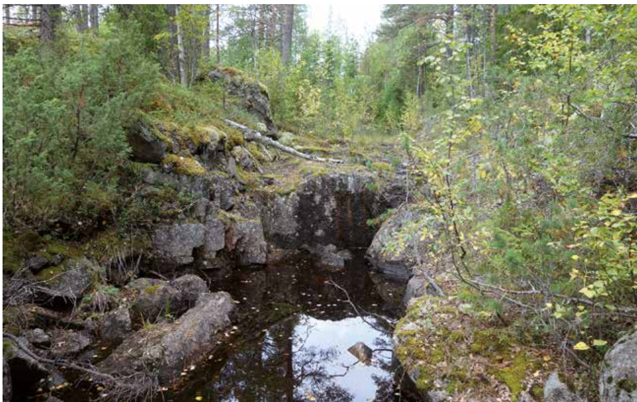
Fig. 27. Kanal (34), ca 45 m lång (NV-SÖ), 4–5 m bred och 0,5–2 m djup. På 4–5 ställen med intill 0,8 m höga kallmurade kanter. Skär av en udde i ån på dess NÖ sida. Delvis belägen i naturlig sänka i moränen, delvis nedsprängd i sänka i berghäll. Enligt kostnadsförslag i tabell i syn 1918 kan detta vara "kanal sprängd och grävd 150 m. värde 600:00 kr [värde i befintlig byggnad]" (LA). Tydligt var kanalen tillkommen före 1918. Kanalen i bruk 1961. Foto mot NV.
