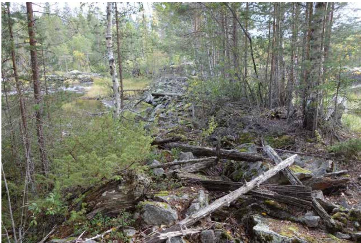
Fig. 58. Dammvall (93), 28 m lång (N–S), ursprungligen 2,5 m bred, sedan breddad åt V med 1,5 m bred stenvall av skarpkantad sten och 2 m bred grusvall. Kan ha fungerat som väg. I ursprungliga dammvallen är natursten 0,3–1,5 m stora. Delvis anlagd på häll och ansluter mot moränmark i N och bergklippa i S. Belägen på udde på åns N strand. Har samband med objekt 17. Foto mot S.
