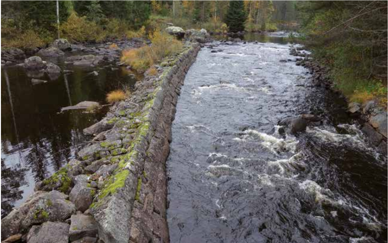
Fig. 193. Ledarm (1), 50 m lång (N–S), ca 2 m bred och ca 1 m hög, av intill 1 m långa och 0,4 m breda och höga huggna stenar, i tre skikt med flat sida mot forsen i V, ihopsatta med järnband. Mot landsidan i Ö är mindre natursten. Ansluter i N till brofäste och går delvis över en mindre gräsbeklädd ö. Belägen på åns Ö sida. Finns på kartor 1902, 1908 och 1918 (V12-39:1, 21-FÄR-AVS632, 21-FÄR-331). Enligt kostnadsförslag i tabell i syn 1899 ”Dubbelkista t.h. 70 m. repareras 140 kr [värde i befintlig byggnad] 140 kr [kostnad för föreslagna åtgärder i flottningsbyggnad]” (LA). Foto mot SV.
