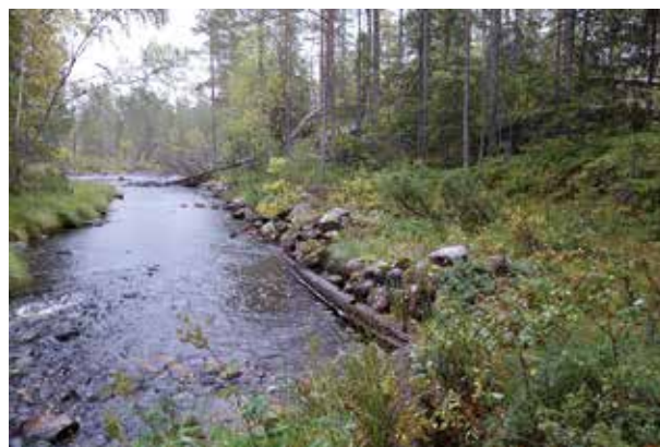
Fig. 101. Strandskoning (44), 12 stycken stenkistor, 1–2,5 m stora och 0,5–0,8 m höga, av 0,2–0,5 m stora runda stenar, belägna ett par meter från varandra längs en 42 meter lång sträcka. I kistorna i V delen finns stockar, både längsgående och tvärliggande. Delvis övermossad och gräsbeväxt. Belägen i S strandkant på sidofärra till å. Foto mot Ö.
