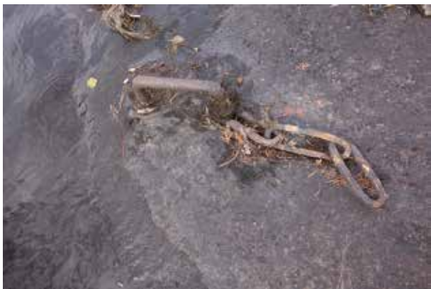
Fig. 59. Varpring (69), en 0,15 m i diameter stor, handtagsliknande länk fastsatt i berghäll, och med 0,3 m lång kedja. Belägen på svagt NÖ-sluttande berghäll, intill vattenbryn på åns S strand. Enligt kostnadsförslag i tabell i syn 1899 har varpringen troligen hållit en "Dubbel bom 35 m à 0.80. 28 kr [kostnad för föreslagna åtgärder i flottningsbyggnad]" (LA). Foto mot N.
