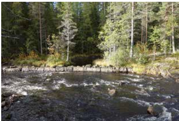
Fig. 116. Ledarm (75), 30 m lång (NV-SÖ), 2 m bred och 0,7 m hög, av intill 1,2 m långa och 0,5 m stora huggna stenar i 1-2 skikt med flat sida mot forsen och med mindre natursten och skarpkantad sten mot landsidan. Ihophållen med järnband. Ansluter i NV till håll och stänger av en mindre sidofåra av ån. Belägen på åns NÖ sida. Foto mot N.
