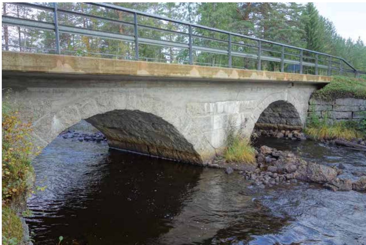
Fig. 128. Landsvägsbro (15), med 2 valvade brospann 5 m breda och 1,8 m höga, av intill 1,5 m långa och 0,4 m breda och tjocka huggna stenar, i kallmur. Landfästena är halvrunda, förstärkta av huggen sten i 5–6 skikt, i kallmur. På senare tid har bron fått en förstärkning av betong. Brobana av betong och räcken i metall. Foto mot NV.
