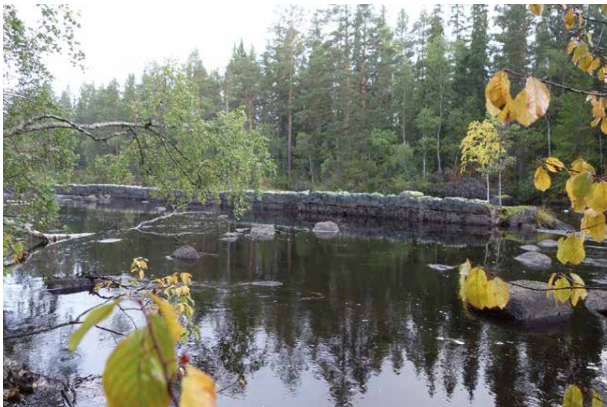
Fig. 111. Ledarm (49), 135 m lång (NV-SÖ), 2,5 m bred och 1 m hög, av 1–1,5 m långa och 0,4 m stora huggna stenar, i 2 skikt, med flat sida ut mot forsen. Mot landsidan i N är mindre natursten och skarpkantad sten. Ansluter i V till N åstranden, i Ö slutar den mitt i ån. Belägen mitt i ån. Foto mot NV.
