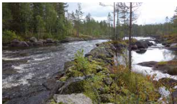
Fig. 95. Ledarm (58), ca 25 m (Ö–V), 2 m bred och 1,2 m hög, av 0,3–1 m stora naturstenar och skarpkantade stenar. Ansluter i V till stranden och i SÖ till mindre ö. Belägen på åns S strand. Foto mot SÖ.
