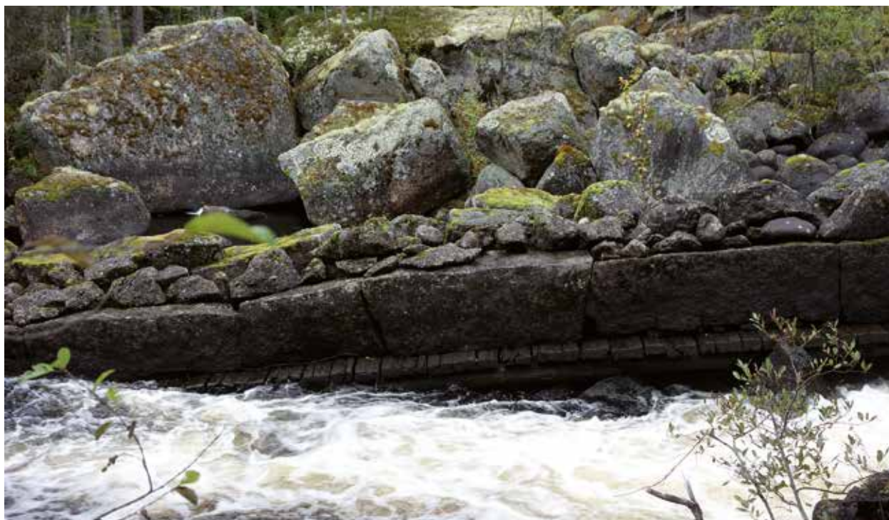
Fig. 102 och 103. Kanal (54), 260 meter lång, kanal (55) 182 m lång, ibland enskiktad av huggen sten, intill 1,5 m långa och 0,3–0,4 m stora, men mestadels av huggen sten i 2–3 skikt. Sammanhållna av järnband och krampor. Planhuggen sida av stenen mot strömsidan. Mindre natursten och skarpkantad sten finns på kanalkantens landsida. Längs en kortare del av kanalen ligger längsgående rundstockar mot botten, samt tvärgående sågade plank på dessa, och ovanpå slutligen huggen sten i ett skikt med småsten ovanpå. Belägna på åns N och S sida samt i ån. Kanalen är ca 2,5 m bred i dess Ö halva, men ca 7–8 meter bred i den V delen. Enligt kostnadsförslag i tabell i syn 1899 kan objekt 54 vara "Leddarn t.v. nybyggd af sten 121 m à 8.00 968 kr [värde i befintlig byggnad]". Enligt kostnadsförslag i tabell i syn 1899 är objekt 55 möjligen detta som åsyftas "Grof bjelkbom med två stödkistor 70 m à 1.25 87.50 kr" och detta "Bjelkbom t.h. 30 m à 0,70 21 kr [värde i befintlig byggnad]". Någonstans mitt på objekt 54 och 55 fanns även en damm enligt samma kostnadsförslag 1899 "Damm t.v. af sten l = 3.5; h = 2.30 med 2 luckor af 1.3 resp. 1.5 m bredd. Luckorna utbytes mot nya. 50 kr [värde i befintlig byggnad] 20 kr [kostnad för föreslagna åtgärder i flottningsbyggnad]". I samma kostnadsförslag även "Leddarn t.h. nybyggd af sten 12 m. 96 kr Leddam t.v. nybyggd af sten 10 m. 80 kr [värde i befintlig byggnad](LA). Foto mot NV och S.
