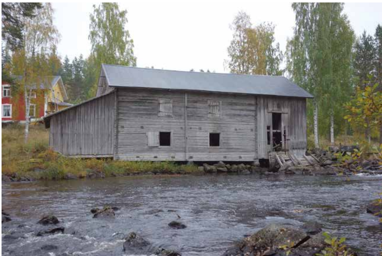
Fig. 195. Kvarnbyggnad (30), 22 x 10 m stor (NÖ–SV). Knuttimrad och delvis panelklädd, omålade, 2 våningar hög. Plåttak. Rester av vattenhjul i SV delen av långsidan mot ån. Äldre industribyggnad, kvarn. Belägen direkt NÖ om dammvall (objekt 128) på SÖ sidan av ån. Kvarnen i Ängra. Finns på laga skifteskarta 1902 och 1918 (V12-39:1, 21-FÄR-331). Enligt kostnadsförslag i tabell i syn 1899 är detta ”quarn och trösk t.h. 130 kr [värde i befintlig byggnad]” (LA). Foto mot S.
