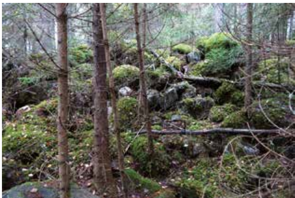
Fig. 171. Dammvall "Ängradammen" (8). Raserad, återstår oregelbundna stenhögar på vardera sidan om ån. Vall NV sidan: 38 m lång (NV-SÖ), 2,5–3 m bred och 0,5–2,5 m hög, där dammsidan mot forsen i SV är intill 1,8 m hög och dammsidan mot NÖ är intill 2,5 m hög. Av 0,4–1 m stora naturstenar och huggen sten, delvis övermossad. Förstärkt av en 3–3,5 m bred och 1 m hög jordvall i SV. Vall SÖ sidan: Lika som på N sidan, dock utan jordvall. Finns på laga skifteskarta 1902 (V12-39:1). Enligt laga skifteskarta 1918 (21-FÄR-331) ca 90 m lång damm (NV-SÖ). Enligt kostnadsförslag i tabell i syn 1899 "Dam: l = 92 m; b = 3.6; medelh. = 3.0 m. Slussöppning med 6 luckor = 6 m. Skibord 3.5 m. Rännsluss 2.5 m med 2 luckor 3500 kr [värde i befintlig byggnad] 2000 kr [kostnad för föreslagna åtgärder i flottningsbyggnad]" (LA). Foto mot S.
