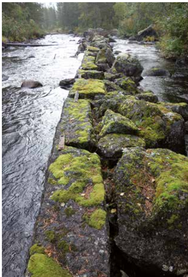
Fig. 111. Ledarm (49), 135 m lång (NV-SÖ), 2,5 m bred och 1 m hög, av 1–1,5 m långa och 0,4 m stora huggna stenar, i 2 skikt, med flat sida ut mot forsen. Mot landsidan i N är mindre natursten och skarpkantad sten. Ansluter i V till N åstranden, i Ö slutar den mitt i ån. Belägen mitt i ån. Foto mot NV.
