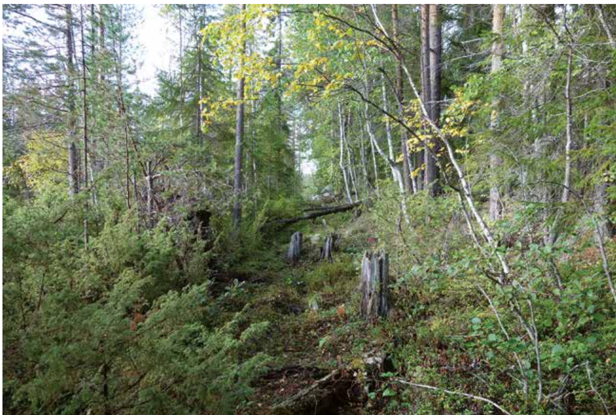
Fig. 90. Flottningsränna (88), ca 90 m lång (Ö–V) och syns som en 2 m bred trädfri gata i skog med förmultnade trästockar i botten, 0,2–0,3 m grova, liggande vinkelrätt mot rännan. Helt övermossad och i rännan finns stubbar från äldre träd. Rännans båda ändar ansluter till åfåra. Belägen på mindre moränrygg 0–10 meter N om å. Enligt kostnadsförslag i tabell i syn 1899 "Ränna 270 m. 945 kr [kostnad för föreslagna åtgärder i flottningsbyggnad]" (LA). Flottningsrännan är bevarad i 1/3 av den totala längden. Foto mot V.
