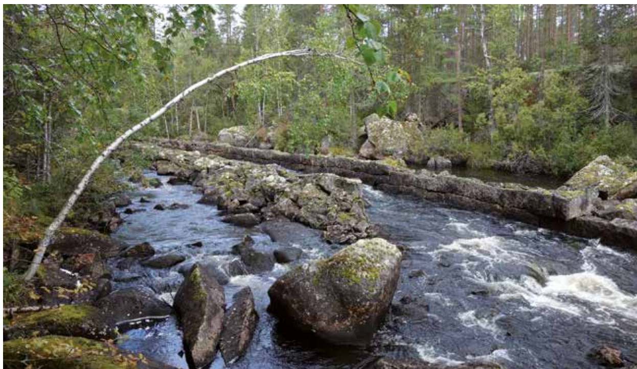
Fig. 102 och 103. Kanal (54), 260 meter lång, kanal (55) 182 m lång, ibland enskiktad av huggen sten, intill 1,5 m långa och 0,3–0,4 m stora, men mestadels av huggen sten i 2–3 skikt. Sammanhållna av järnband och krampor. Planhuggen sida av stenen mot strömsidan. Mindre natursten och skarpkantad sten finns på kanalkantens landsida. Längs en kortare del av kanalen ligger längsgående rundstockar mot botten, samt tvärgående sågade plank på dessa, och ovanpå slutligen huggen sten i ett skikt med småsten ovanpå. Belägna på åns N och S sida samt i ån. Kanalen är ca 2,5 m bred i dess Ö halva, men ca 7–8 meter bred i den V delen. Enligt kostnadsförslag i tabell i syn 1899 kan objekt 54 vara "Leddarn t.v. nybyggd af sten 121 m à 8.00 968 kr [värde i befintlig byggnad]". Enligt kostnadsförslag i tabell i syn 1899 är objekt 55 möjligen detta som åsyftas "Grof bjelkbom med två stödkistor 70 m à 1.25 87.50 kr" och detta "Bjelkbom t.h. 30 m à 0,70 21 kr [värde i befintlig byggnad]". Någonstans mitt på objekt 54 och 55 fanns även en damm enligt samma kostnadsförslag 1899 "Damm t.v. af sten l = 3.5; h = 2.30 med 2 luckor af 1.3 resp. 1.5 m bredd. Luckorna utbytes mot nya. 50 kr [värde i befintlig byggnad] 20 kr [kostnad för föreslagna åtgärder i flottningsbyggnad]". I samma kostnadsförslag även "Leddarn t.h. nybyggd af sten 12 m. 96 kr Leddam t.v. nybyggd af sten 10 m. 80 kr [värde i befintlig byggnad](LA). Foto mot NV och S.
