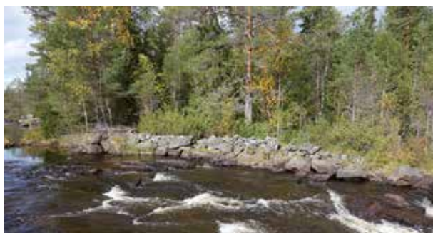
Fig. 82. Dammvall (60), 40 m lång (N-S) med en 15 m lång vinkel mot NV i dess N ände. Vallen är 2,4–3 m bred och 1,5 m hög. I ett ca 6 m långt mittenparti är huggna stenar, intill 1,2 m långa och 0,4 m stora i tre skikt mot strömsidan, men 0,1–2 m stora naturstenar och skarpkantad sten mot landsidan. De övriga delarna av vallen består enbart av natursten och skarpkantad sten. Avslutas i NV i forsen. Belägen på Ö stranden av en udde på åns S sida. Igensatt eller ombyggd damm? Kan den vara förstärkt under olika tider? Har samband med objekt 61. Ansluter mot objekt 18 i Ö. Enligt kostnadsförslag i tabell i syn 1899 "Dam af sten och jord tvärs öfver ån l = 39 m; b = 1.2; h = 1.9 m; Rännsluss 4.0 jordfyllning påföres ytterligare närmast stranden, hvarjemte starkare stenskoning anbringas närmast slussöppningen 234 kr [värde i befintlig byggnad] 100 kr [kostnad för föreslagna åtgärder i flottningsbyggnad]" (LA). Foto mot S.
