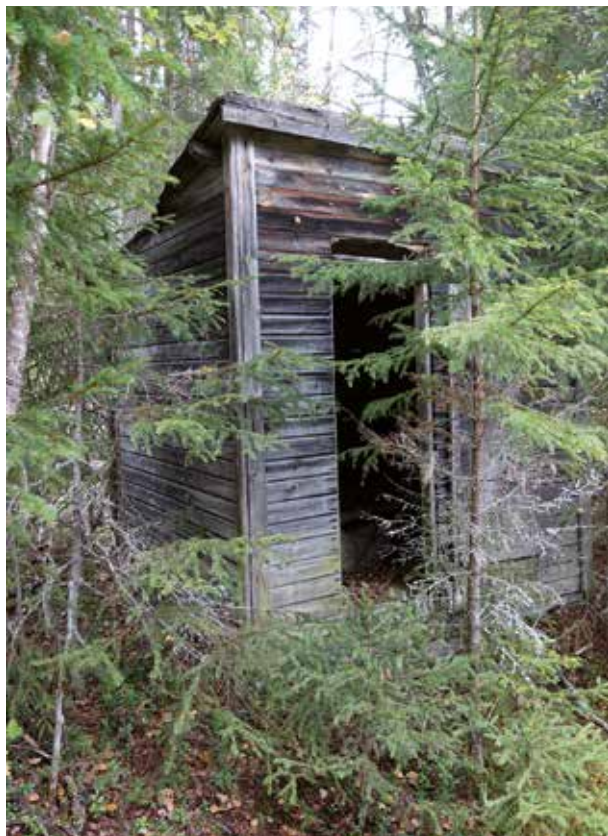
Fig. 22. Koja (38), 2 x 2 m stor och 2–2,5 m hög med sluttande pulpettak. Byggt av regelverk och spontade liggande bräder. Anlagd på enkel stengrund. Dörr åt S. Möjlig kamin inuti. Detta är en del av "Storkojan". Belägen på plan moränmark ca 20 m NÖ om åkant. Foto mot NÖ.
