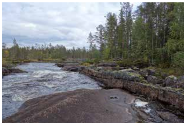
Fig. 71. Ledarm (63), 18 m lång (Ö-V), 3 m bred och 2 m hög på strandsidan och 0,7 m hög på forssidan. Av intill 1,5 m långa och ca 0,4 m stora, huggna stenar lagda i 1-2 skikt med slät sida mot forsen och med mindre natursten och skarpkantad sten, 0,5-1,5 m stora bakom mot landsidan. Belägen på åns S strand, delvis anlagd på berghäll. Foto mot Ö.
