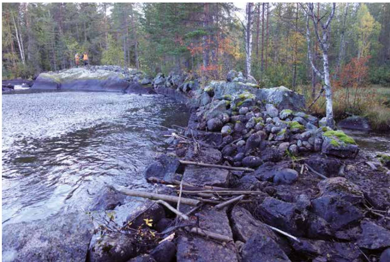
Fig. 131. Dammvall (21), den NÖ och N delen av den ca 65 m långa vallen, byggd som skalmur med huggna block i kanterna. Byggsdes troligen ny efter 1988. Foto mot NV.
