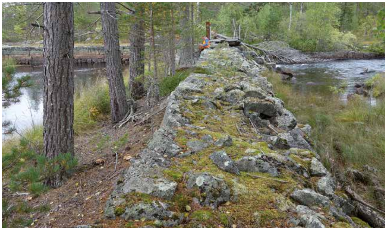
Fig. 52. Damm (17). Dammvall, belägen på båda sidorna av ån samt på ö i ån. S sidan: 22 m lång (N–S), 1,8–2,2 m bred, V sidan huggen sten, 1,5 x 0,4 m stora, i två skikt. Ifylld med cement och sammanbundna med järnkrämpor. Vallens fyllning och Ö sidan av mindre sten, mestadels skarpkantad, men även natursten. Ansluter i S till berghäll. V om vällen en 2 m bred trädbevuxen vall av grus. Dammfästet har förstärkning av intill 2 m långa och 0,4 x 0,4 m stora huggna stenar i 3–4 skikt. Järnförstärkning kvar i dammöppningen, men inga dammluckor. Enkel, ruten träbro. Foto mot N. Forts. beskrivn. fig. 54.
