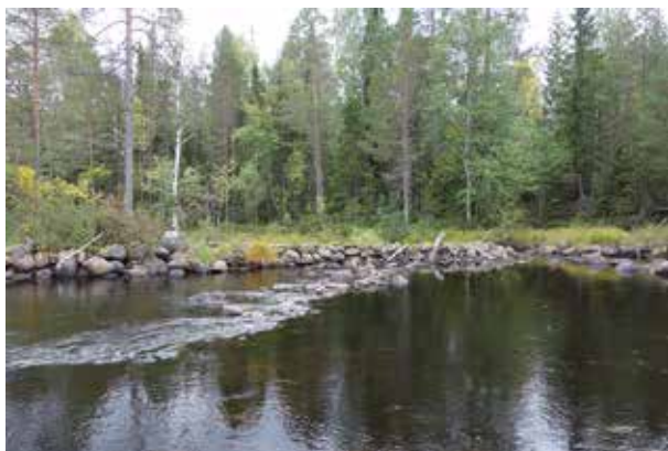
Fig. 18. Ledarm (37). Intill 20 m lång (Ö–V), 1 m hög och ca 1 m bred. Stänger av sidofärra mellan åns S strand och liten ö. Ansluter till stranden i V. Något raserad. Foto mot S.
