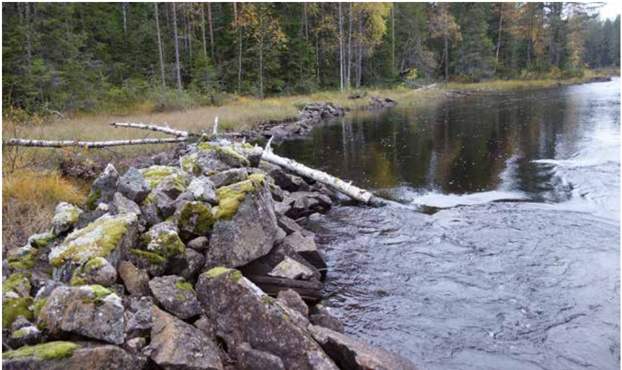
Fig. 155. Ledkista (126), i Ö delen 14 m lång (NV-SÖ), ca 2 m bred och intill 1,2 m hög, av 0,2–1 m stora skarpkantade stenar, med tvärgående stockar under, vilka bildar 1–2 m breda fackverk. I V delen 3 timrade stenkistor, 2–2,5 m stora och 0,4–0,8 m hög med 0,2–0,6 m stora naturstenar. Hela ledkistan är ca 45 m lång. Belägen på åns NV strand. Finns på kartor 1908 och 1918 (21-FÄR-AVS632, 21-FÄR-331). Foto mot V.
