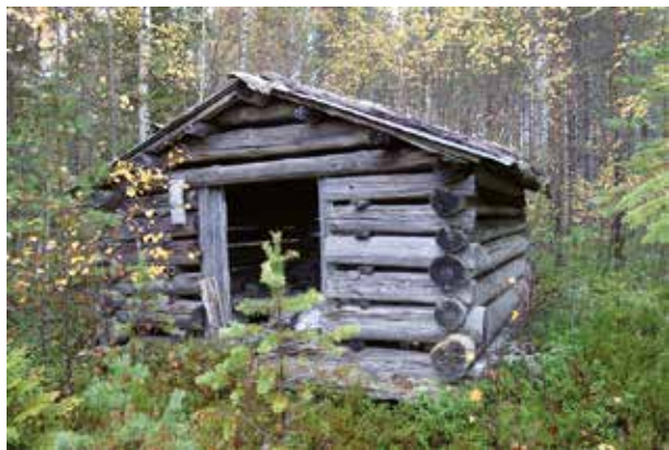
Fig 140. Myrslätterlada (111), 4 x 3,5 m (NV-SÖ) med glesa runda stockar och bevarat trägol. Tak av näver och träribbor med dolt plåttak därunder. Beläget ca 40 m NV om vattenbryn med myrmark omkring. Foto mot V.
