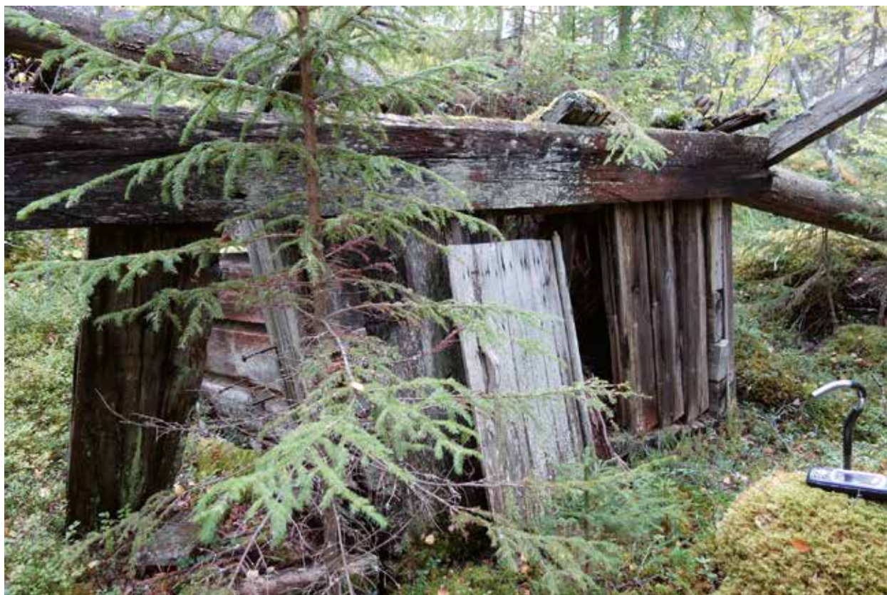
Fig. 32. Kojan, flottarkoja (41), 2,5 x 2 m stor och 1,5–2 m hög, med sluttande tak. Av halvkluvor, liggande stockar samt stående plank, med en dörröppning åt N mot ån. Identifierade initialer inristade på dörröverstycke, från vänster: WH, EF, EU, VH, PF och GF. Delvis raserad koja p g a nedrasade barrträd. 1 m N om och utanför kojddörren är en eldpall 2 x 1,5 m stor (Ö–V) och 1 m hög. Förmodad eldstadsöppning 1,2 x 1,4 m stor (Ö–V) och 0,5 m djup med öppning åt S mot kojjan. Kojan belägen ca 10 m S om åkant. Foto mot SV.
