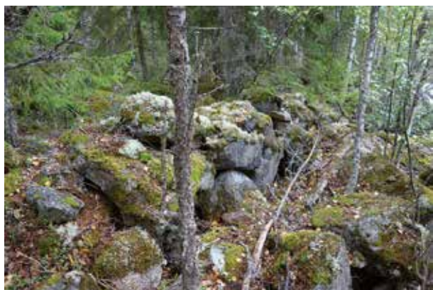
Fig. 120. Strandskoning (82), 10 m lång (Ö-V), 1,5 m bred och 1 m hög, av 0,2–1 m stora naturstenar och skarpkantade stenar. Ihophållen av några järnband. Belägen på moränmark 3–4 m N om ån. Delvis övermossad. Foto mot Ö.
