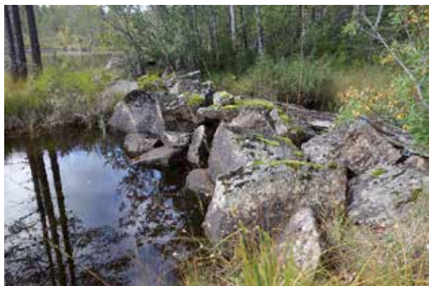
Fig. 67. Ledarm eller strandskoning (90), 14 m lång (NV–SÖ), 1,5 m bred och 0,6 m hög, av 0,5–1,5 m stora skarpkantade stenar. Ligger för och stänger av en naturlig sidoränna av å. Belägen på åns NÖ strand. Foto mot N.
