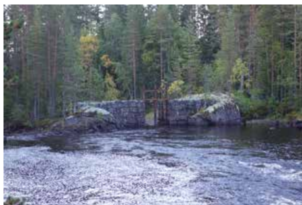
Fig. 131. Dammvall (21), den NÖ och N delen av den ca 65 m långa vallen, byggd som skalmur med huggna block i kanterna. Byggsdes troligen ny efter 1988. Foto mot NV.
