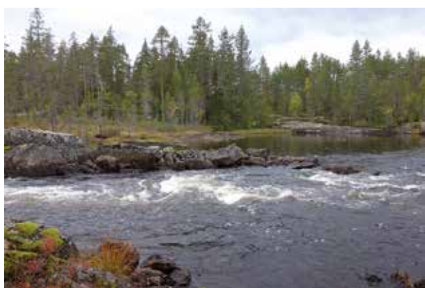
Fig. 65. Ledarm (66), 6 m lång (Ö–V), intill 1 m bred och 0,5 m hög, av 0,2–0,8 m stora stenar, både natursten och skarpkantad sten. Ansluter till stenblock i V. Belägen på åns N sida. Foto mot N.
