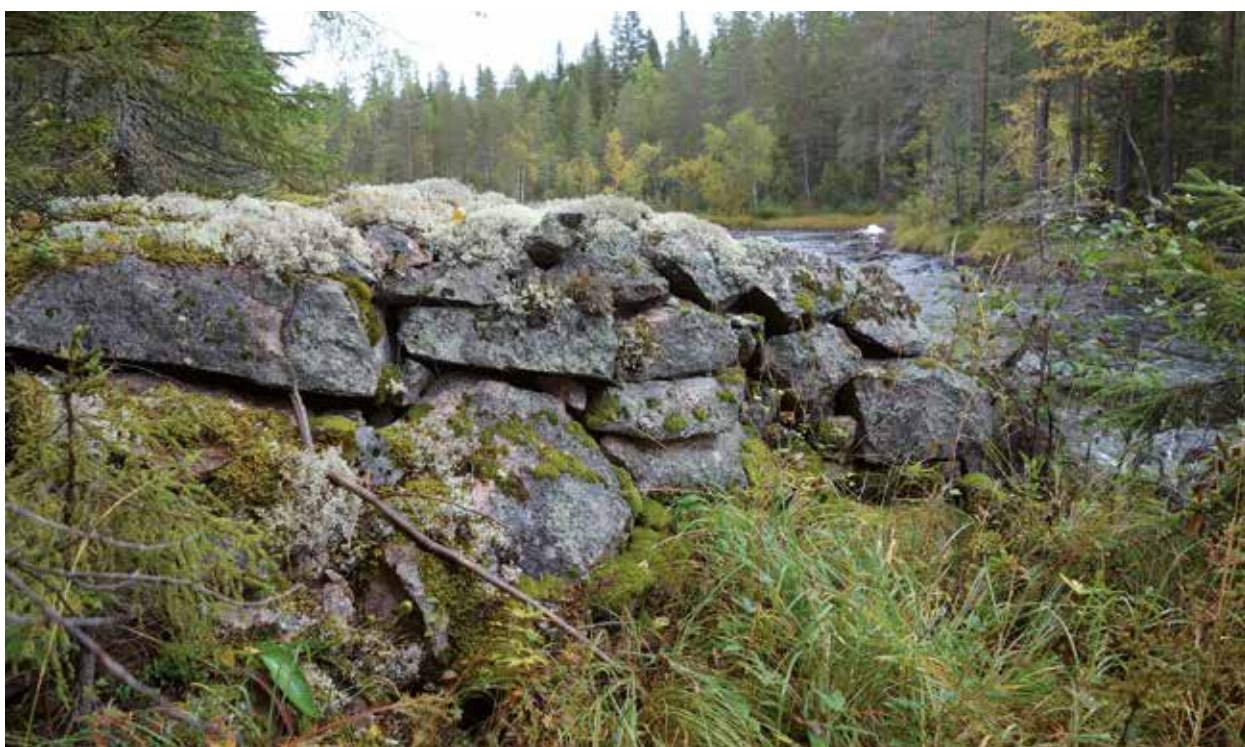
Fig. 50. Dammvall (102) på båda sidorna av ån. V sidan: vinkelrätt mot ån, 18 m lång (Ö–V), 1,5–2 m bred och 1,2 m hög. Av huggen sten, 0,4–1 m stora, i 5 synliga skikt. Delvis övermossad. Ö sidan: vinkelrätt mot ån, 5 m lång, 1,5–2 m bred och 1,2 m hög, av huggen sten. Belägen i strandkant. Foto av dammvallen på V sidan ån, mot N.
