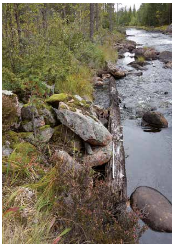
Fig. 20. Strandskoning (44), av 12 stycken stenkistor, 1–2,5 m stora och 0,5–0,8 m höga, av 0,2–0,5 m stora runda stenar, belägna ett par meter från varandra längs en 42 meter lång sträcka. I kistorna i V delen finns stockar, både längsgående och tvärliggande. Delvis övermossad och gräsbeväxt. Belägen i S strandkanten på sidofåra till å. Foto mot Ö.
