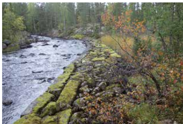
Fig. 119. Ledarm (81), 40 m lång (N-S), 3 m bred och 1,5 m hög, av intill 1,5 m långa och 0,4 m stora huggna stenar i 1–2 skikt, och ihopsatta med järnband. De huggna stenarna bildar ställvis en skalmur, med flat sida åt strömsidan i V och åt en bäckfåra i Ö, med mindre natursten mellan. Ansluter till berghäll i både N och S. Belägen på åns Ö strand. Foto mot N.
