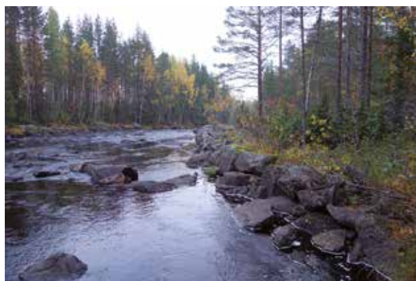
Fig. 179. Strandskoning (127), 95 m lång (N–S), ca 2 m bred och 1 m hög, av 0,3–1,5 m stora naturstenar och huggen sten, blandat. Ansluter till större block på tre ställen. Belägen på åns Ö strand. Foto mot N.
