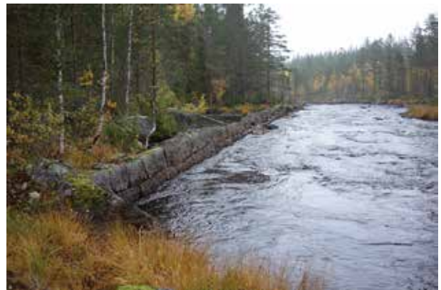
Fig. 175. Ledarm (120), 50 m lång (N-S), 2 m bred och 0,8 m hög, av 0,8–1,5 m långa och 0,4 m breda och höga huggna stenar i två skikt på strömsidan, ihopsatta med järnband. Inåt land är natursten och skarpkantad sten. Delvis övermossad. Raserad längs ett kortare avsnitt på mitten. Avslutas i S mot ett stenblock. Avslutas i N med ett rakt avslut i ån. Belägen på åns V sida. Foto mot N.
