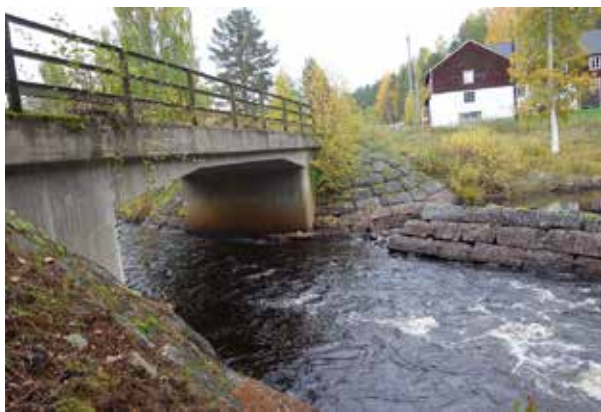
Fig. 190. Brofäste (2), gamla landsvägsbron. Brofästena är ca 4 m höga i 9 skikt av intill 1 m långa och 0,4–0,5 m höga huggna stenar. Kallmurade som glacismur. Delvis övermossat. Själva bron från senare tid, av betong med brobana av betong och räcken i metall. Bron finns på skattdäckningskarta 1751 (21-FÄR-10) och framåt. Omnämnt som "Landsvägsbro" i kostnadsförslag i tabell i syn 1899 (LA). Foto mot NÖ.
