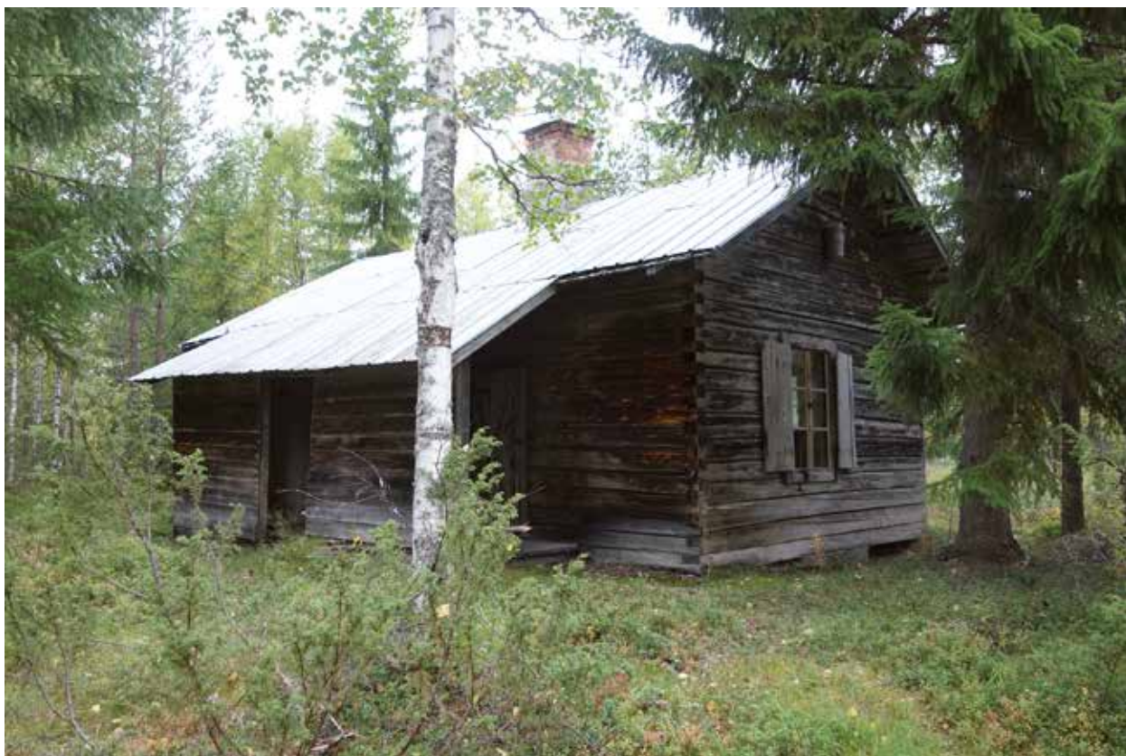
Fig. 86. Flottarbaracken "Skogshotellet" (72), ca 8 x 5 m stor (Ö–V), timrad med laxade knutar och plåttak. Belägen ca 35 m S om ån på sandmark med blandskog. Fler byggnader kan ha funnits i området. Enligt kostnadsförslag i tabell i syn 1899 "Barack t.h. 150 kr [värde i befintlig byggnad]" (LA). Foto mot NV.
