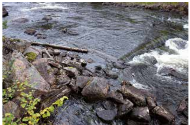
Fig. 19. Skibord (43), av fastkilade stockar vertikalt utgående mot forsen, och når ut mot mitten av ån. På dessa finns längsgående stockar liggandes. I strandkanten är oregelbundna stenhögar formade som en enkel ledarm, 3–4 m lång (NV–SÖ) vilken ansluter mot block i Ö. Belägen på åns SV sida. Enligt kostnadsförslag i tabell i syn 1918 kan detta vara "t.h. enkelista af trä 24 m. à 3 kr 72:00 kr [kostnad för föreslagna åtgärder i flottningsbyggnad]" (LA). Foto mot NV.
