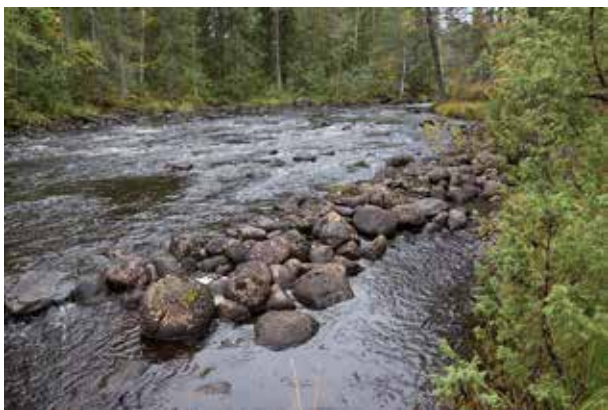
Fig. 124. Strandskoning (80), 9 m lång (NV-SÖ), 1 m bred och 0,2–0,3 m hög, av 0,2–0,3 m stora naturstenar. Belägen på åns N strand. Foto mot NV.
