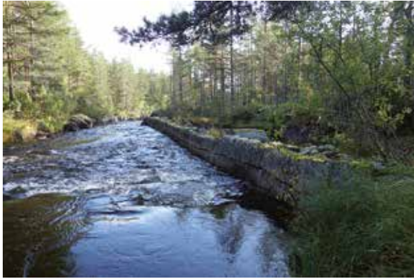
Fig. 114. Ledarm (51), ca 40 m lång (NÖ-SV), 1,5 m bred och 1,2 m hög av intill 1,5 m långa och 0,4 m stora huggna stenar i 2 skikt, med slät sida utåt forsen, samt med 0,4-1,5 m stora naturstenar och skarpkantade stenar inåt land i SÖ. Ansluter till strand i V och i Ö till en mindre ö. Belägen på åns SÖ strand. Foto mot NÖ.
