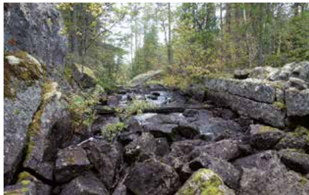
Fig. 107. Flottningsränna (20). Ställvis stenrensad och med stenskodd kant. Rännan har en ca 15–20 m lång del av huggna stenar och naturstenar, i 1–2 skikt. Finns på laga skifteskarta 1900 (V12-16:1, 21-FÄR-243). Foto mot V.
