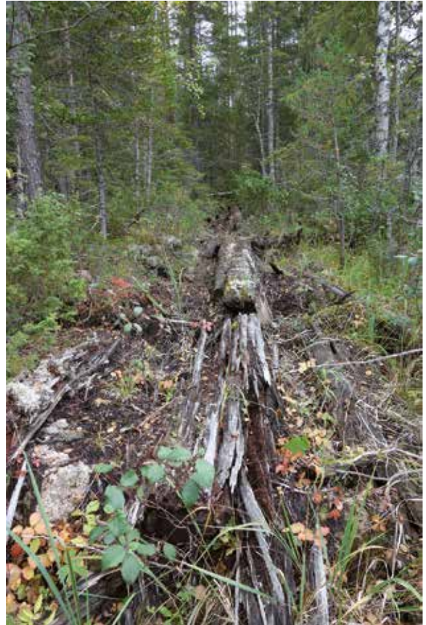
Fig. 30. Ledarm (31), ca 25 m lång (Ö–V) med svag båge åt N i dess V del. 0,5–2,5 m bred och 1 m hög, av 0,5–1 m stora, delvis huggna stenar, men mest natursten. Belägen på åns N strand. Skibord, 3 m långt (Ö–V) och 2,5 m brett, av 15 stycken ca 0,15 m breda bräder. Trädymlade. 3 m av ledarmen överlagrar skibordet. Dammvall, 5 m lång (N–S), 2,5 m bred och intill 1 m hög, av intill 1 m stora naturstenar. Helt övermossad. Belägen på åns S strand. Enligt kostnadsförslag i tabell i syn 1918 kan detta vara ”dam af trä värde 300:00 kr [värde i befintlig byggnad]” (LA). Foto mot N.
