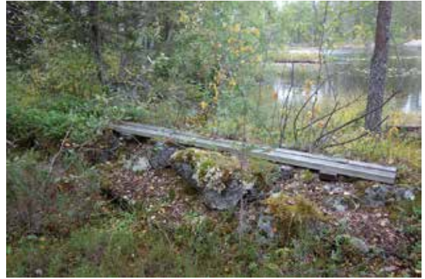
Fig. 62. Stenbrygga (70) längs flottarstig (46), 10 m lång (Ö-V), 1 m bred och 0,7 m hög, av skarpkantad sten. På stenbryggan en senare träspång. Belägen över blötmark. Övermossad och beväxt av blåbärsris och lövsly. Belägen 5 m S om å. En del av flottarstig objekt 46. Foto mot NV.
