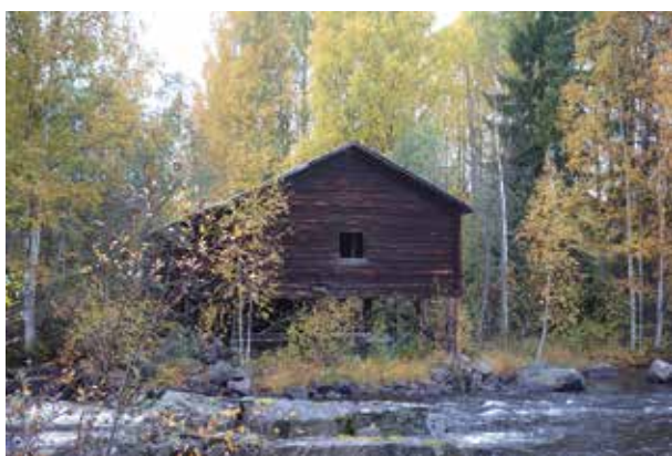
Fig. 196. Sågverksbyggnad (29), 14 x 8 m stor (NV–SÖ) Knuttimrad och stående på resta stockar och med plåttak. Äldre industribyggnad, sågverk. Belägen direkt NÖ om dammvall (objekt 128) på N sidan av ån. Sågverket i Ängra. Finns på laga skifteskarta 1902 och 1918 (V12-39:1, 21-FÄR-331). På kartan finns dessutom ytterligare en byggnad som inte kunnat återfinnas i fält, intill och NÖ om sågverket och vinkelrätt mot detta parallellt med stranden. Enligt kostnadsförslag i tabell i syn 1899 är detta ”såg och trösk t.v. 130 kr [värde i befintlig byggnad]” (LA). Foto mot N.
