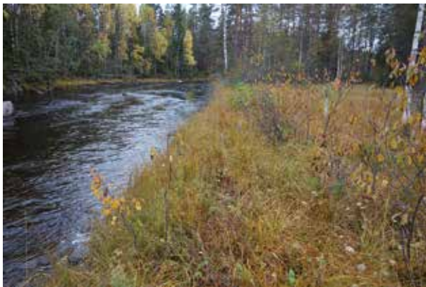
Fig. 183. Strandskoning (3), ca 80 m lång (N-S), ca 1,5 m bred och 0,4 m hög, av 0,2-0,3 m stora naturstenar. Svåravgränsad i längdriktning, kraftigt överväxt av gräs samt beväxt av äldre tallar. Belägen på åns V strand. Finns på kartor 1902, 1908 och 1918 (V12-39:1, 21-FÄR-AVS632, 21-FÄR-331). Enligt kostnadsförslag i tabell i syn 1899 kan detta vara "Dubbelkista t.v. 177 m repareras 531 kr [värde i befintlig byggnad] 177 kr [kostnad för föreslagna åtgärder i flottningsbyggnad]" (LA). Foto mot SV.
