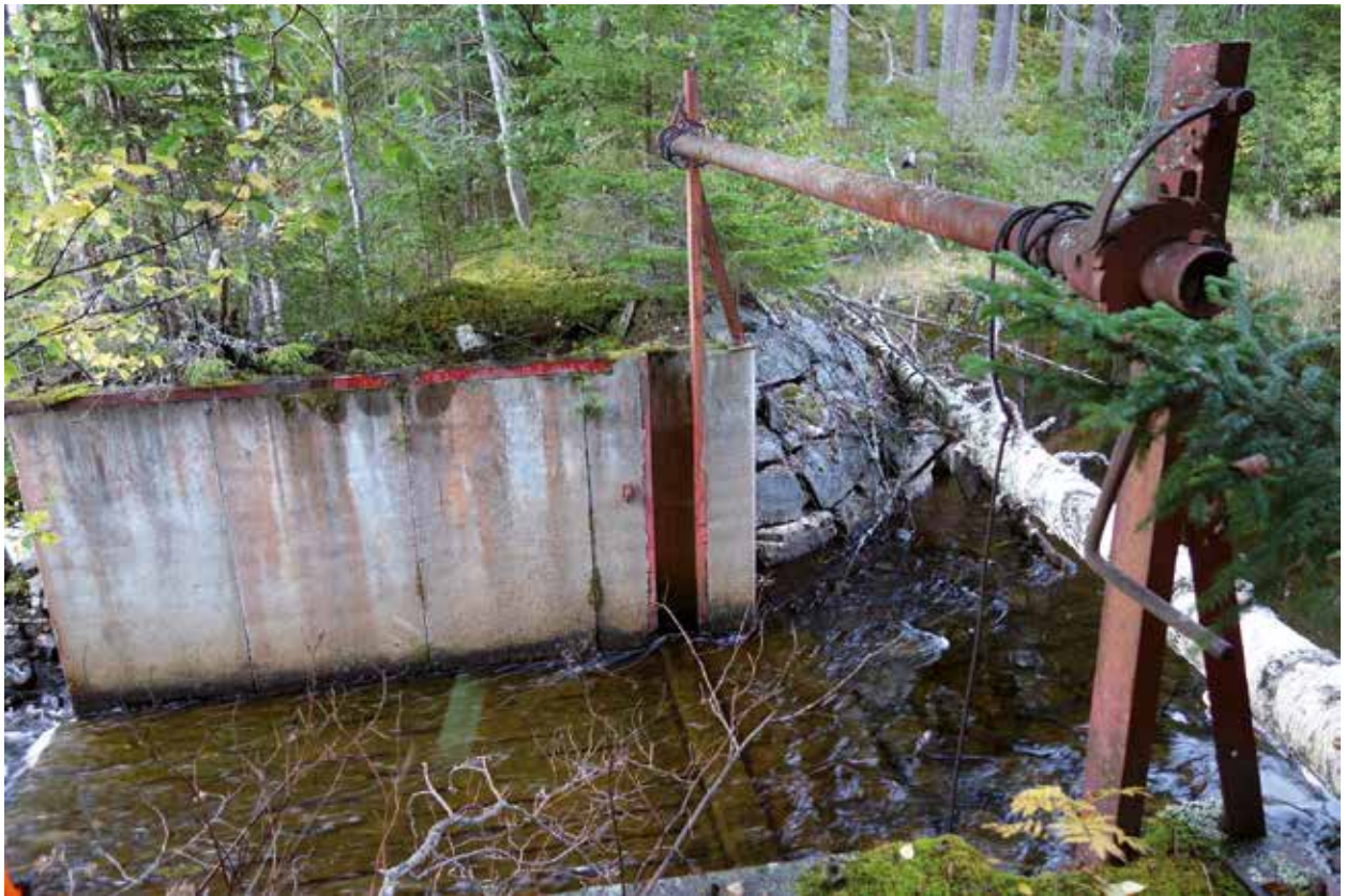
Fig. 160. Dammvall "Törndammen" (11), av mestadels betong med strandfundament av huggen sten. 5 synliga skikt och ca 2 m bred och 2 m hög. Av ca 1m stora huggna stenar. Skibord av trä i dammöppning. Nästan helt övermossad och beväxt av 20-tal mindre granar samt lövsly. Enligt laga skifteskarta 1918 (21-FÄR-331) är dammen ca 20 m lång (NÖ-SV). Dammen finns på laga skifteskarta 1902 och 1918 (V12- 39:1, 21-FÄR-331). Enligt kostnadsförslag i tabell i syn 1899 "Dam: l = 24 m; b = 3.0 m; h = 1.6 m, med 4 st grundluckor à 0.95 m; repareras 48 kr [värde i befintlig byggnad] 240 kr [kostnad för föreslagna åtgärder i flottsbyggnad]" (LA). Foto mot Ö. Se även fig. 13.
