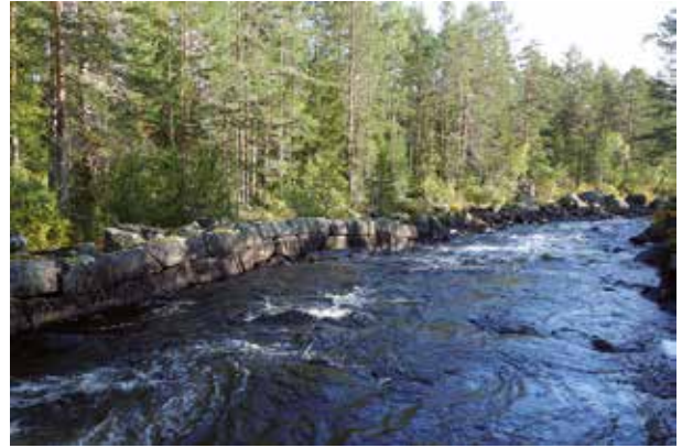
Fig. 115. Ledarm eller strandskoning (52), ca 10 m lång (NÖ-SV), 1,5 m bred och ca 1,2 m hög, av intill 1,5 m långa och 0,4 m stora huggna stenar i 2 skikt. Stenarna är sammanhållna med järnband. Planhuggen sida av stenen mot strömsidan. Mindre natursten och skarpkantad sten finns på kanalkantens N sida mot land. I ledarmens N ände är endast ett skikt sten. Stenen har synliga borrhål. Belägen på åns N och NV sida. Övergår i kanal 53+83. Foto mot NÖ.
