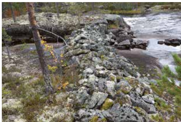
Fig. 68. Ledarm (92), 11 m lång (N–S), 2 m bred och intill 0,8 m hög, av 0,3–0,8 m stora naturstenar och skarpkantade stenar. Mossbeväxt. Belägen på åns N strand. Foto mot S.
