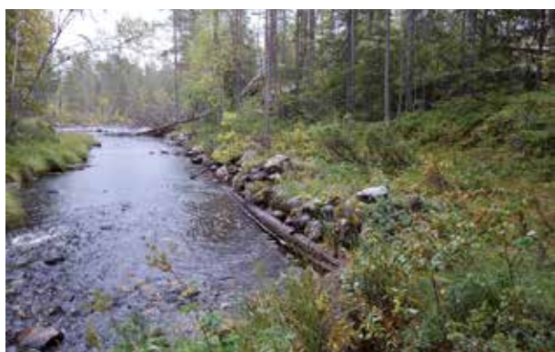
Fig. 20. Strandskoning (44), av 12 stycken stenkistor, 1–2,5 m stora och 0,5–0,8 m höga, av 0,2–0,5 m stora runda stenar, belägna ett par meter från varandra längs en 42 meter lång sträcka. I kistorna i V delen finns stockar, både längsgående och tvärliggande. Delvis övermossad och gräsbeväxt. Belägen i S strandkanten på sidofåra till å. Foto mot Ö.
