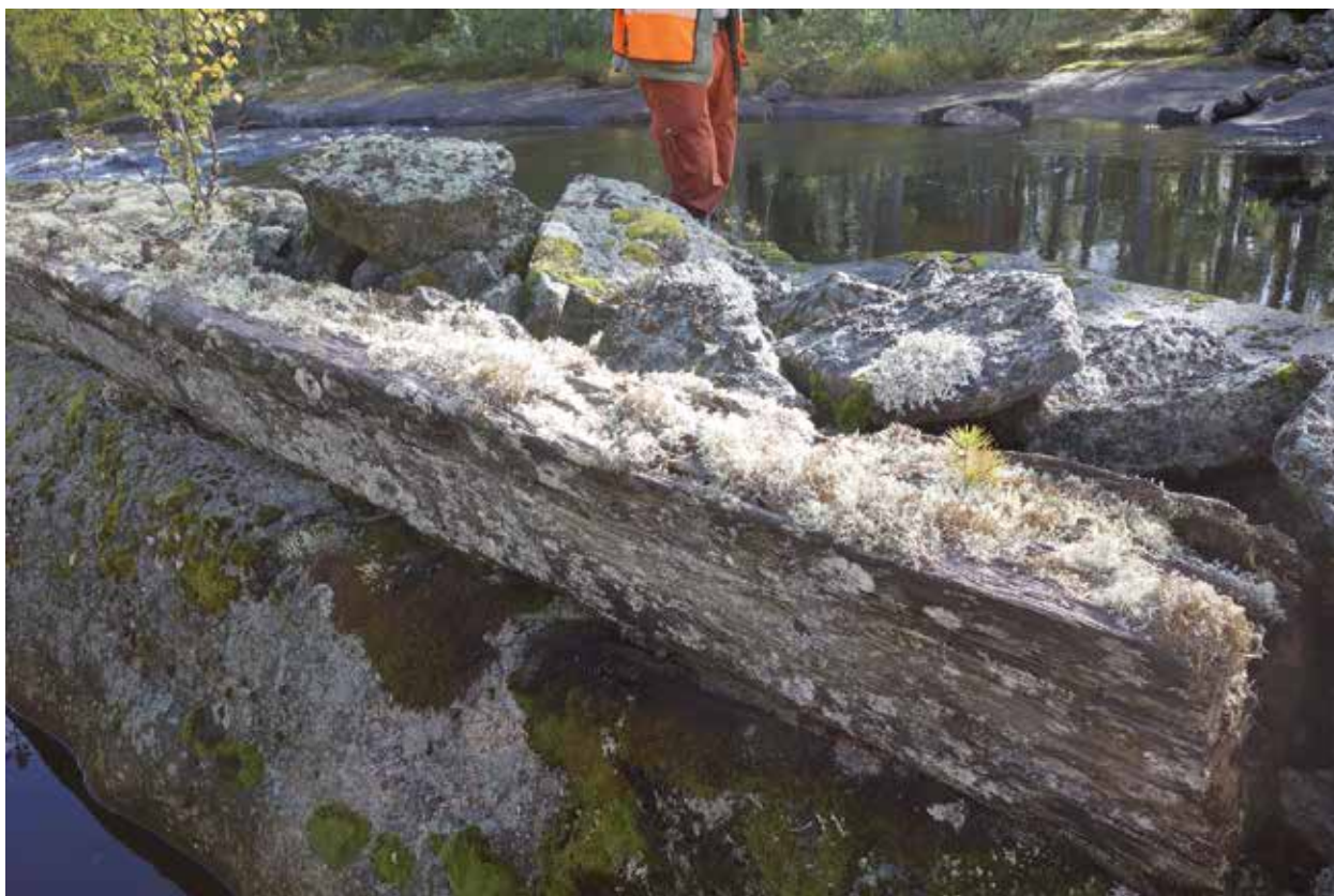
Fig. 73. Ledarm/vattenledare (89), 28 m lång (NV-SÖ), 2 m bred och 0,7 m hög, av 0,3–0,8 m stora grovhuggna stenar mot strömsidan. I SÖ delen en träsyll på toppen av berghällen mot landsidan i N. Syllens fyrkantigt sågad 0,35 x 0,35 m stor och 14 m lång och fastslagen i berghällen av 0,3 m långa smidda spikar. Belägen på åns N strand mellan två åfåror, där N fåran är igensatt. Enligt kostnadsförslag i tabell i syn 1899 "Dubbel kista L. = 10 m.; b. = 2.3; h = 0.5 m. 15 kr" samt "Dam för en sidogren l. = 16 m.; b = 2.7; 3.3 32 kr [kostnad för föreslagna åtgärder i flottningsbyggnad]" (LA). Foto mot SÖ.
