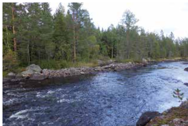
Fig. 80. Strandskoning (27), 25 m lång, 2–2,5 m bred och 1 m hög, av 0,4–1 m stora naturstenar och skarpkantade stenar. Belägen på åns N strand. Foto mot NÖ.
