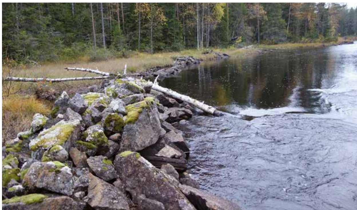
Fig. 192. Ledkista (126). I Ö delen 14 m lång (NV-SÖ), ca 2 m bred och intill 1,2 m hög, av 0,2–1 m stora skarpkantade stenar, med tvärgående stockar under, vilka bildar 1–2 m breda fackverk. I V delen 3 timrade stenkistor, 2–2,5 m stora och 0,4–0,8 m hög med 0,2–0,6 m stora naturstenar. Hela ledkistan är ca 25 m lång. Belägen på åns NV strand. Finns på kartor 1908 och 1918 (21-FÄR-AVS632, 21-FÄR-331). Foto mot N.
