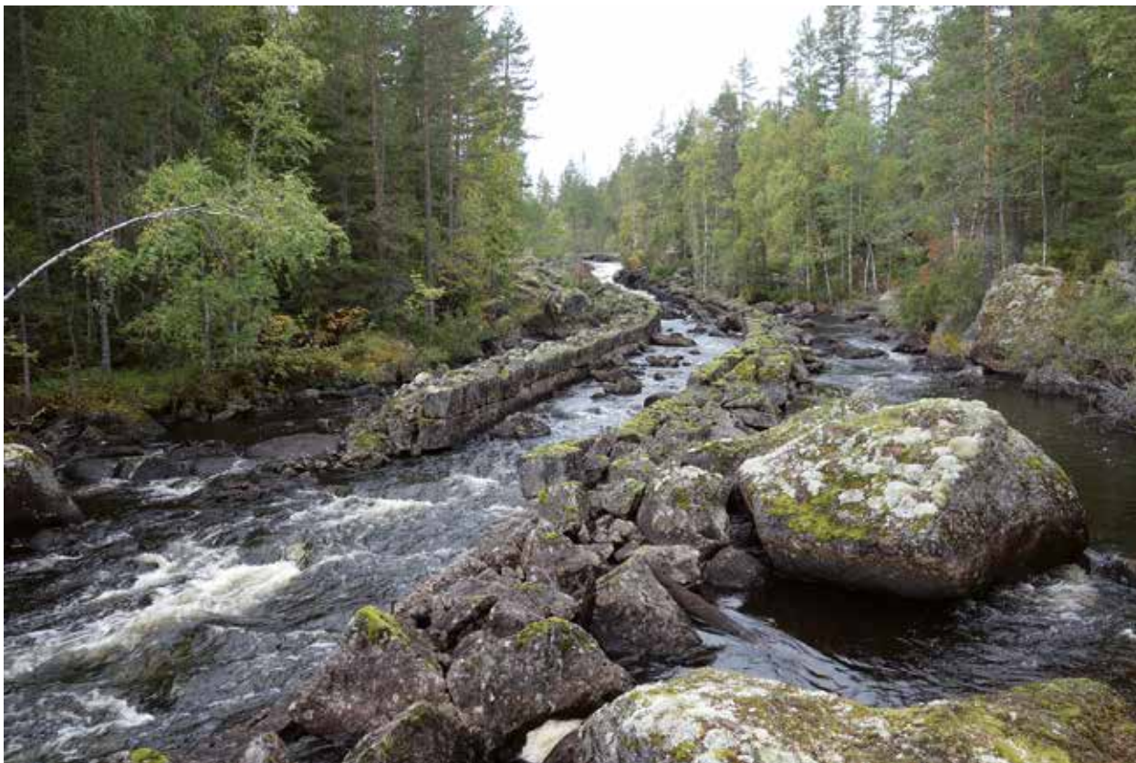
Fig. 122. Kanal (83), 220 m lång (NÖ–SV), 0,8–1,2 m hög, 6–12 m bred, smalare i Ö halvan och bredare i den V och försvinner på några ställen. Kanalens inre bredd är 2,5–3 meter. Byggd av intill 1,2 m långa och 0,4 m stora huggna stenar i 2 skikt. Planhuggen sida av stenen mot strömsidan. Mindre natursten och skarpkantad sten finns på kanalkanten landsida. Grövre smidda spikar islagna med jämna mellanrum. Kan det funnits en träbalk ovanpå stenarna tidigare? Avslutas i Ö av stenblock på vardera sidan av kanalen. Fisktrappa möjlig i sidogren N om kanal. Bildar kanal tillsammans med objekt 53. Foto mot V.
