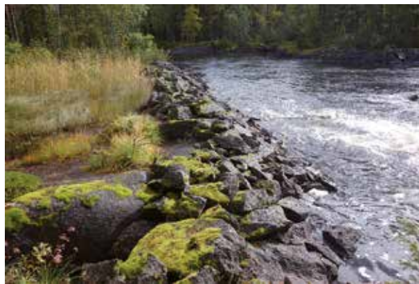
Fig. 77. Strandskoning (85), 25 m lång (NV-SÖ), 2–2,5 m bred och 0,8 m hög, av 0,2–0,4 m stora naturstenar och skarpkantade stenar. Skoningen sluttar ned mot forsen, som glacismur. Delvis belägen på håll. Belägen på åns N strand. Foto mot SÖ.
