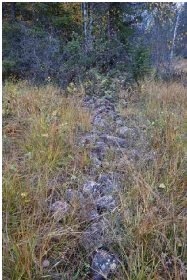
Fig. 185. Strandskoning (4), ca 10 m lång (NÖ–SV), 1 m bred och 0,1–0,2 m hög, av 0,3 m stora naturstenar. Delvis bortspolad i SV. Helt överväxt av gräs och beväxt av tall och björksly. Belägen på udde på åns SÖ strand. Finns på kartor 1902, 1908 och 1918 (V12-39:1, 21-FÄR-AVS632, 21-FÄR-331). Enligt kostnadsförslag i tabell i syn 1899 kan detta vara en del av ”Dubbelkista t.h. 70 m repareras 210 kr [värde i befintlig byggnad] 70 kr [kostnad för föreslagna åtgärder i flottningsbyggnad]” (LA). Foto mot SV.
