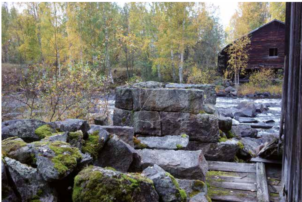
Fig. 194. Dammvall (128). S sidan: 17 m lång (NV-SÖ), 2 m bred och 1,5–2 m hög, av 0,3–0,6 m stora huggna stenar. Ansluter i S till slänt vid tomt och avslutas i N vid fyrkantigt dammfundament, 1,8 m högt, 1,5 m brett, av intill 0,7 m stora stenar. Järnbandade. Vallen delvis raserad. N sidan: kraftigt övermossad stenhög, ca 10 m lång (Ö-V) och 2 m bred samt 1 m hög. Dammen finns på laga skifteskarta 1902 och 1918 (V12-39:1, 21-FÄR-331). Enligt kostnadsförslag i tabell i syn 1899 "Dam, bildande ett 13 m brett skibord; quarn och trösk t.h. såg och trösk t.v. 130 kr [värde i befintlig byggnad]. Dubbelkista snedt ut längs sågväggen 15 m. lång, nybygges à 8.00 120 kr [kostnad för föreslagna åtgärder i flottningsbyggnad]" (LA). Foto mot N.
