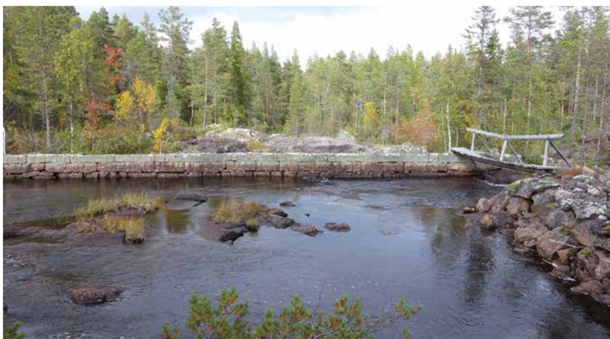
Fig. 81. Dammvall (26), 43 m lång (NV-SÖ), 1,5 m bred och intill 1 m hög, av huggna stenar i 3 skikt, 2–2,5 m långa, 0,4 m stora, sammanhållna av järnband. Stenarna i botten-skiktet är mindre skolsten. Avslutas på berghäll i Ö vid dammöppning. Över öppningen ligger en enkel träbro. Belägen på åns N strand. Har samband med objekt 73. Enligt kostnadsförslag i tabell i syn 1899 "Leddamm af sten t.v. 40 m à 7.00 28 kr [kostnad för föreslagna åtgärder i flottningsbyggnad]" (LA). Foto mot N.
