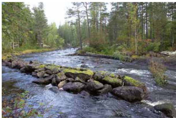
Fig. 112. Ledarm (50), 22 m lång (Ö-V), 1,5–2 m bred och 0,6 m hög, av intill 1,2 m långa och 0,4 m stora huggna stenar, i 1–2 skikt, med flat sida mot forsen i N. Ihophållna med järnband. Mot landsidan i S är mindre natursten och skarpkantad sten. Foto mot NV.
