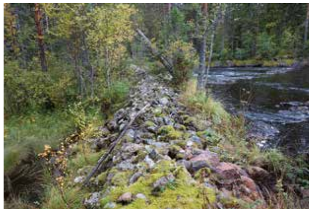
Fig. 48. Ledarm (95), 14 m lång (N–S), 1,5–2 m bred och 1–1,3 m hög, av 0,15–0,4 m stora naturstenar. Båda ändarna ansluter mot klippvallar. Belägen på åns Ö strand. Foto mot S.
