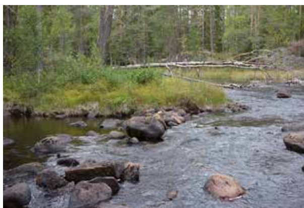
Fig. 29. Ledarm (42), 3,5 m lång, 1,5 m bred och 0,5 m hög av 0,3–1 m stora rundade stenar. Enligt kostnadsförslag i tabell i syn 1918 kan detta vara "t.h. kullerstensarm öfver gamla ån 30 150:00 kr [värde i befintlig byggnad]" (LA). Ledarmen kan vara äldre än 1918. Foto mot N.
