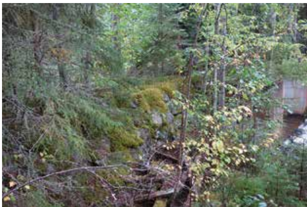
Fig. 161. Dammvall "Törndammen" (11), dess Ö del. Foto mot V.
