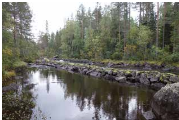
Fig. 118. Ledarm (77), 60 m lång (NV-SÖ), 2,5 m bred och 1 m hög, av intill 1,5 m långa och 0,4 m stora huggna stenar i 1–2 skikt, lagda med släta sidan mot forsen i S och ihophållen av järnband. Mindre natursten och skarpkantad sten finns mot landsidan i N. Innehåller enstaka större fasta block. Belägen på åns N sida, delvis i ån. Foto mot S.
