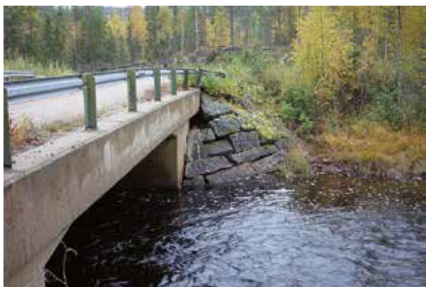
Fig. 149. Bro (113), med äldre brofästen, 7 m breda och 2 m höga, av intill 1 m långa och 0,3 m höga huggna stenar i 6–8 synliga skikt. N brofästet delvis raserat. Delvis övermossat. Senare betongbro med brobana i betong och räcke i metall. Här kan möjligen vara det som kostnadsförslag i tabell i syn 1899 kallas för "Kista t.h. snedt ut i ån; repareras 20 kr [värde i befintlig byggnad] 20 kr [kostnad för föreslagna åtgärder i flottningsbyggnad]" men även "Kista t.v. snedt ut i ån; repareras 16 kr [värde i befintlig byggnad] 16 kr [kostnad för föreslagna åtgärder i flottningsbyggnad]" (LA). Foto mot S.
