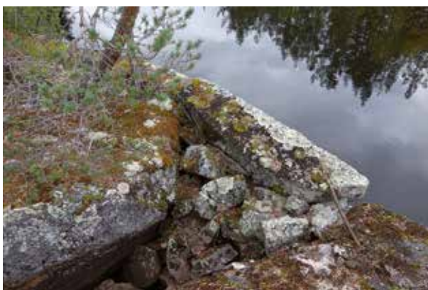
Fig. 63. Strandskoning (65), 3,5 m lång (Ö-V), 1 m bred och 1 m hög, av 1,5 m långa och 0,3–0,4 m stora huggna stenar mot strömsidan, fastsatta med järnkrampor i berghällarna samt mindre sprängstenar bakom in mot land. Anlagd som skydd mot skreva i berghäll. Plan sida mot forsen. Belägen på åns S strand. Foto mot NV.
