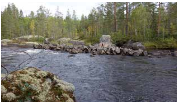
Fig. 94. Ledarm (56), 25 m lång (Ö–V), 1,5 m bred och ca 0,6 m hög, av 0,3–0,7 m stora naturstenar och skarpkantade stenar. Belägen på åns S sida, delvis i strömfåran. Foto mot V.
