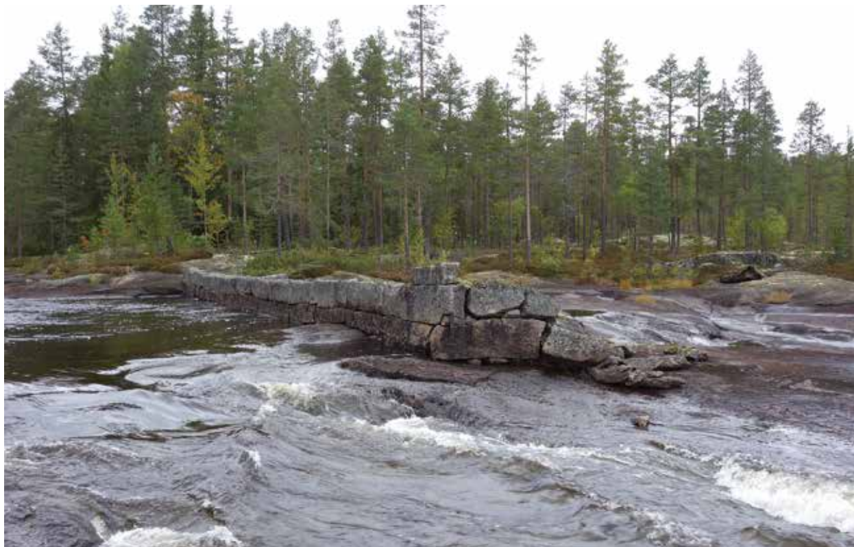
Fig. 98 och 99. Dammvallar (19) på båda sidorna om ån och delvis i åfäran. S sidan: 25 m lång (Ö-V), 2 m bred och 0,9 m hög, av en rad huggen sten, 2 m långa och 0,4 m höga, ihopsatta med järnband, i 2 skikt. Synliga borrhål i stenarna. Mot landsidan är vallen sluttande och består av 0,25–0,7 m stora naturstenar och skarpkantade stenar. N sidan: 28 m lång (NÖ-SV), 2 m bred och 0,9 m hög, av en rad huggen sten, 2 m långa och 0,4 m höga, ihopsatta med järnband, i 2 skikt. Synliga borrhål i stenarna. Mot landsidan är vallen sluttande och består av 0,25–0,7 m stora naturstenar och skarpkantade stenar. De huggna stenarna har slät sida mot strömmen, men inte slät sida mot stranden. Ansluter i V resp NV till strandkant, går över hållar i forsen. I Ö nedanför forsen är en mindre stenhög. Dammvallarna avslutas i ett dammfäste, som består av 3 skikt huggen sten. Foto mot SÖ och NV.
