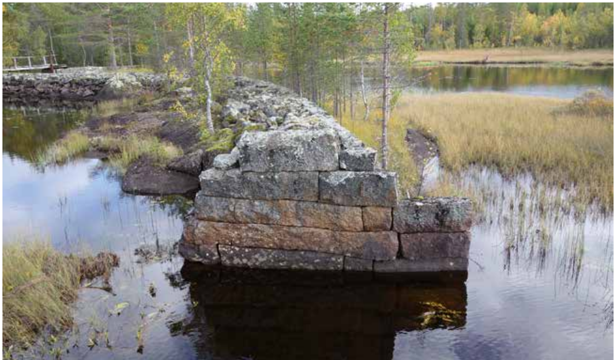
Fig. 54. Mot ö i ån: 53 m lång (Ö-V), 2 m bred och 1,2 m hög, S sidan huggen sten 1,5 m långa och 0,4 x 0,4 m stora, i 2-3 skikt. Sammanbundna med järnkrampor. Vallens fyllning och N sid är mindre natursten. Delvis anlagd mot stenblock och på berghäll. Vallens Ö del ansluter mot udde i åns N strand, och gör en svag böj mot N och avslutas med rak kant vid en 4 m bred dammöppning. Avslutningen består av fem synliga skikt av huggen sten, intill 1,5 m långa och 0,4 x 0,4 m stora. Tvärgående stockar, delar av skibord anas under vattenytan i dammöppningen. Har samband med objekt 93. Foto mot S. Forts. beskrivn. fig. 55.
