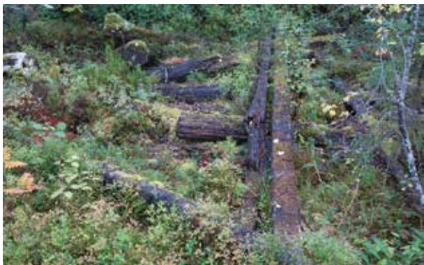
Fig. 106. Flottningsränna (20), ca 1,5 m bred. Nästan helt förmultnade, parvisa längsliggande stockar, och tvärliggande ca 0,5 m grova stockar under dessa, vinkelrätt mot rännan. Allt delvis förmultnat. Rännans tillopp i V avstängt, av en 1,5 m hög och 2,5 m bred stensamling. Rännan går runt en mindre berghäll, 0–30 m S om ån. Har återfunnits i ca 120 + 530 meter. Hela rännans längd har inte återfunnits. Enligt kostnadsförslag i tabell i syn 1899 "Ränna; repareras 1170 m 4680 kr [värde i befintlig byggnad] 1170 kr [kostnad för föreslagna åtgärder i flottningsbyggnad]" (LA). Foto mot Ö.
