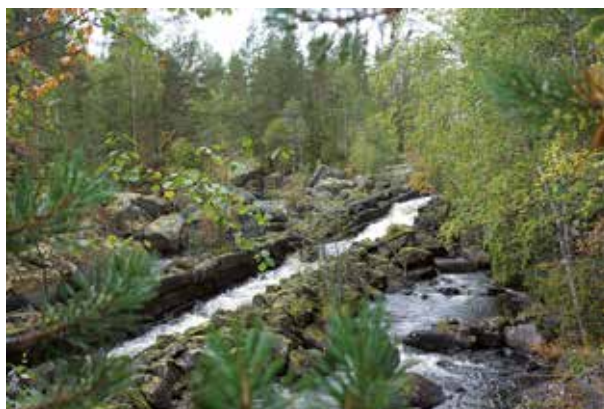
Fig. 121. Kanal (83), 220 m lång (NÖ-SV), 0,8–1,2 m hög, 6–12 m bred, smalare i Ö halvan och bredare i den V och försvinner på några ställen. Kanalens inre bredd är 2,5–3 meter. Byggt av intill 1,2 m långa och 0,4 m stora huggna stenar i 2 skikt. Planhuggen sida av stenen mot strömsidan. Mindre natursten och skarpkantad sten finns på kanalkantens landsida. Foto mot SV.
