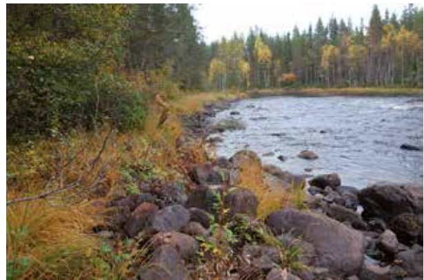
Fig. 184. Strandskoning (5), ca 60 m lång (Ö-V), möjligen rester av en ledarm. Består av spridd plockad natursten och tre möjliga rester av stenkistor i form av 2,5 m diameter stora stensamlingar. Har ev. haft timrade träkistor och troligen raserats efter flottningens slut. Belägen på åns N strand. Finns på laga skifteskarta 1902 och 1918 (V12-39:1, 21-FÄR-331). Foto mot Ö.
