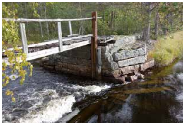
Fig. 57. Damm (17), dammöppning. Foto mot S.
