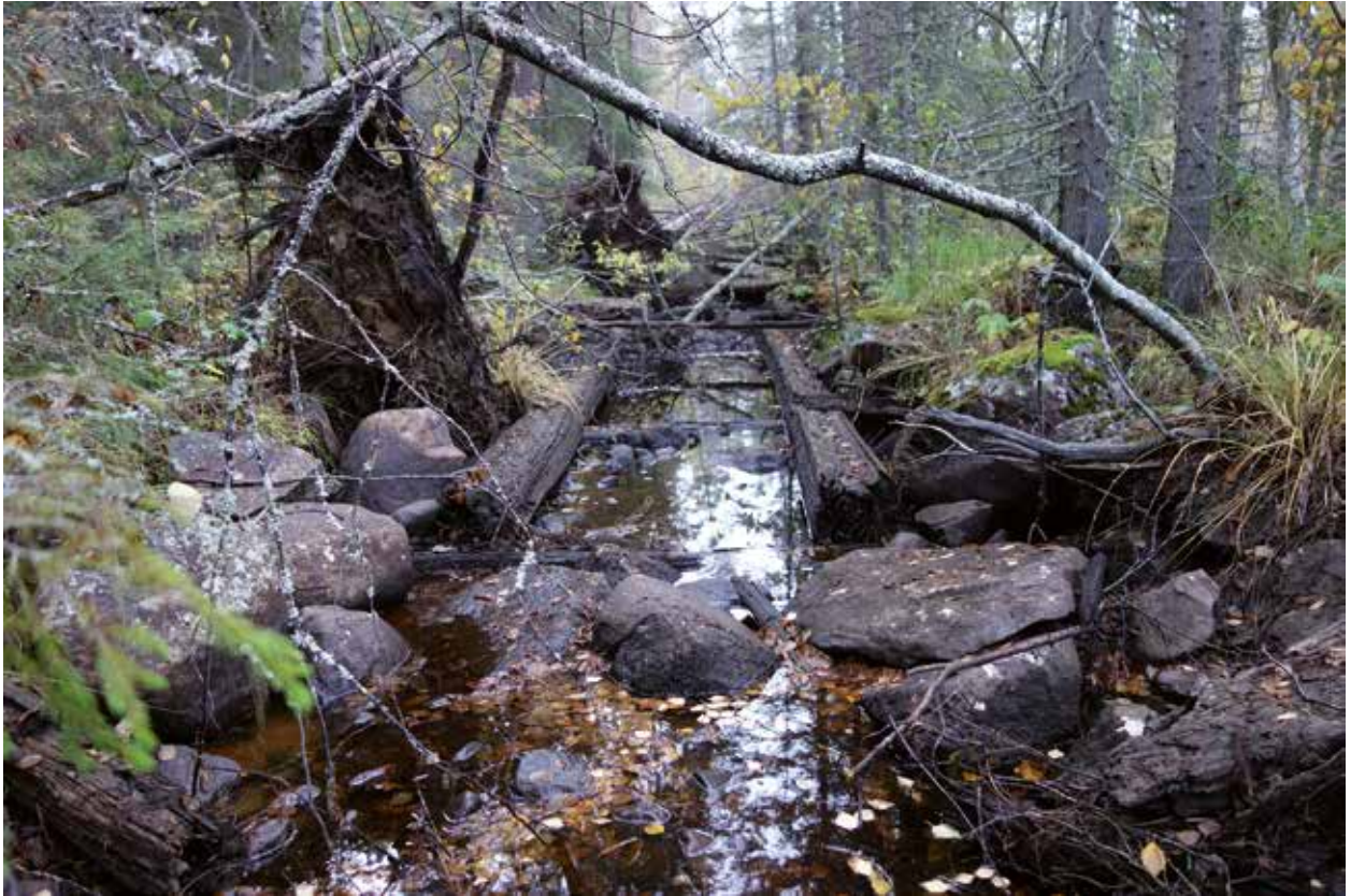
Fig. 170. Flottningsränna (118), ca 230 m lång (NÖ–SV) och 2 m bred. Delvis anlagd i sidofåra till ån på dess NV sida. Tvärgående 0,2–0,3 m grova stockar ligger med ca 2 meters intervaller och på dessa längsgående stockar i samma grovlek med ca 1 m mellanrum. Rännan delvis stenrensad. Avskiljs bitvis från huvudfåran enbart av en 2–2,5 m bred skogsbeklädd moränrygg. Den NÖ tredjedelen av rännan går helt på land i en 2–2,5 m bred stenröjd gata, ev. med stockar i botten. Rännan slutar tvärt i NÖ mot en dammvall (objekt 8), vilket innebär att dammen torde vara yngre. Alternativt kan rännan ha fortsatt över dammvallen (jämför objekt 7). Foto mot NÖ.
