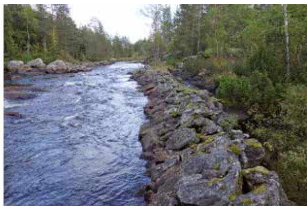
Fig. 79. Strandskoning (28), 38 m lång (Ö–V), 2–2,5 m bred och 1 m hög, av 0,4–1 m stora naturstenar och skarpkantade stenar. Konstruerad delvis som glacismur. Belägen på åns S strand. Foto mot Ö.
