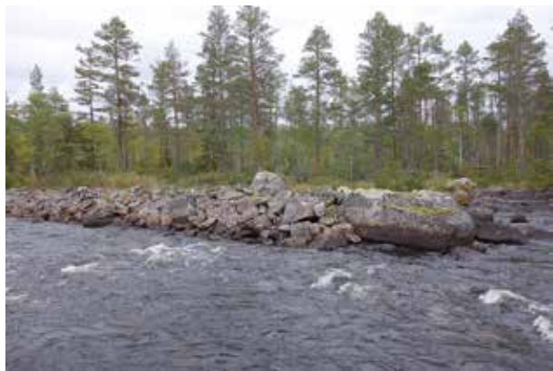
Fig. 76. Ledarm (24), 32 m lång (NV-SÖ), 3 m bred och 0,8 m hög, av 0,3–0,5 m stora naturstenar och skarpkantad sten. Ansluter i N mot stranden och avslutas i S mot ett stenblock. Belägen på åns N strand. Enligt kostnadsförslag i tabell i syn 1899 kan detta vara "Dubbel kista t.v. l = 39; b = 2,30; h = 0,9 117 kr [värde i befintlig byggnad] 78 kr [kostnad för föreslagna åtgärder i flottsrensörbyggnad]" (LA). Synd på ortofotokarta 1961 Foto mot N.
