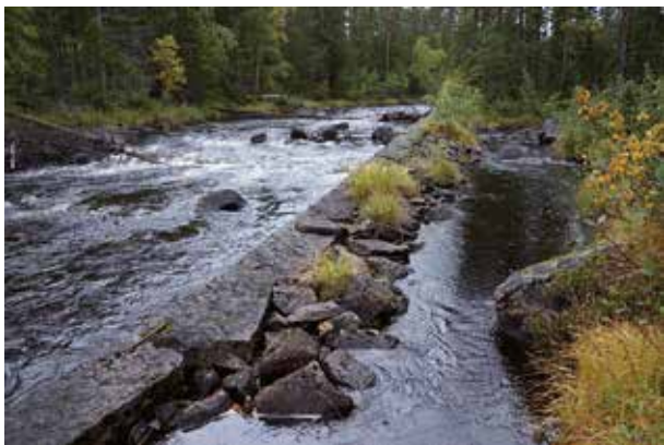
Fig. 47. Ledarm (94), 27 m lång (N–S), 2 m bred och 1–1,5 m hög. Huggna stenar, 1–2,2 m stora mot försen i 2–3 skikt, flest i N änden, men 0,25–0,5 m stora naturstenar mot landsidan. Järnkrampor håller de huggna stenarna. Ledarmen anlagd för att smalna av åfåran. Delvis anlagd på berghäll. Belägen på åns Ö strand. Foto mot N.
