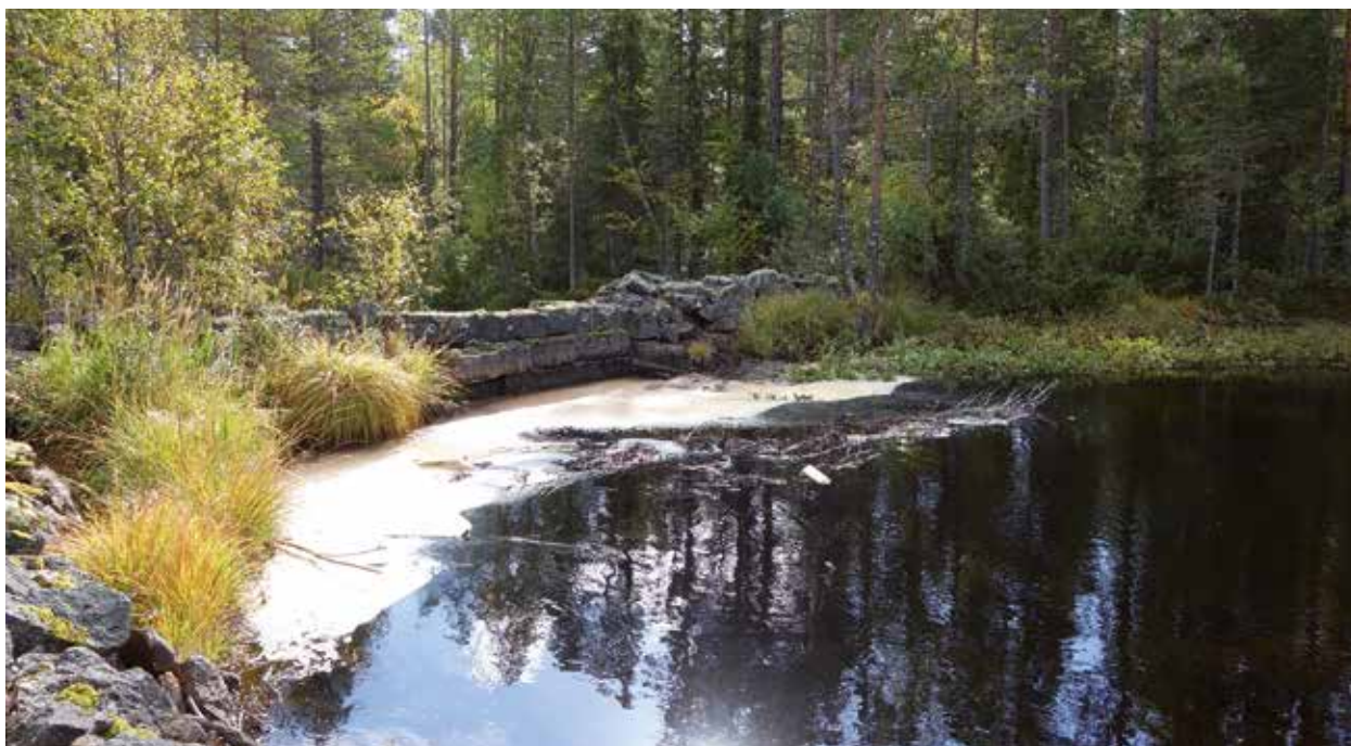
Fig. 82. Dammvall (60), 40 m lång (N-S) med en 15 m lång vinkel mot NV i dess N ände. Vallen är 2,4–3 m bred och 1,5 m hög. I ett ca 6 m långt mittenparti är huggna stenar, intill 1,2 m långa och 0,4 m stora i tre skikt mot strömsidan, men 0,1–2 m stora naturstenar och skarpkantad sten mot landsidan. De övriga delarna av vallen består enbart av natursten och skarpkantad sten. Avslutas i NV i forsen. Belägen på Ö stranden av en udde på åns S sida. Igensatt eller ombyggd damm? Kan den vara förstärkt under olika tider? Har samband med objekt 61. Ansluter mot objekt 18 i Ö. Enligt kostnadsförslag i tabell i syn 1899 "Dam af sten och jord tvärs öfver ån l = 39 m; b = 1.2; h = 1.9 m; Rännsluss 4.0 jordfyllning påföres ytterligare närmast stranden, hvarjemte starkare stenskoning anbringas närmast slussöppningen 234 kr [värde i befintlig byggnad] 100 kr [kostnad för föreslagna åtgärder i flottningsbyggnad]" (LA). Foto mot S.
