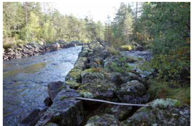
Fig. 117. Ledarm (53), ca 20 m lång (NÖ-SV), 1,5 m bred och ca 1,2 m hög, av intill 1,5 m långa och 0,4 m stora huggna stenar i 2 skikt. Stenarna är sammanhållna med järnband. Planhuggen sida av stenen mot strömsidan. Mindre natursten och skarpkantad sten finns på kanalkantens S sida mot land. Belägen på åns S sida. Ledarmen stänger av en sidofåra av ån. Övergår i kanal 83. Foto mot NÖ.
