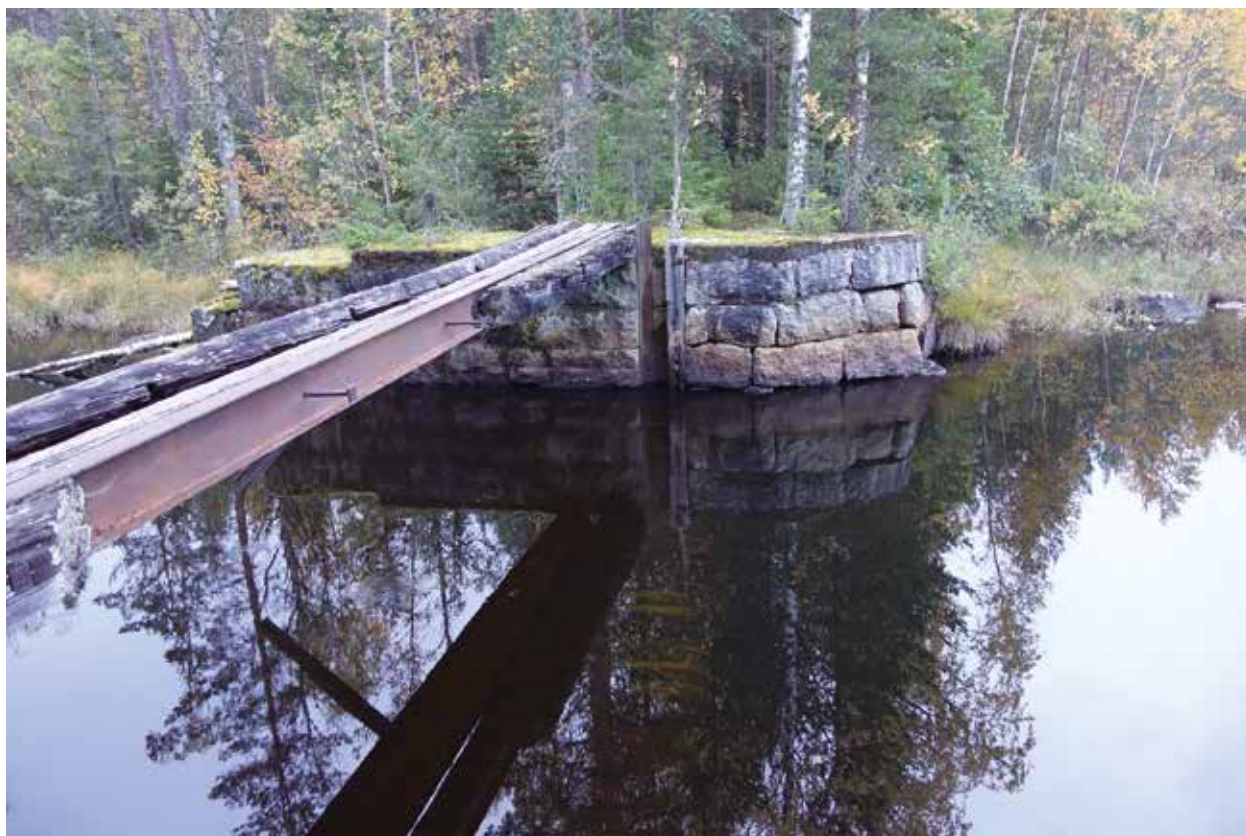
Fig. 169. Dammvall "Stordammen" (9). 10 m brett och 2,5 m högt damm- och brofäste på åns SÖ och NV sida, av ca 1,5 m långa och 0,4 m höga huggna stenar i 3–4 skikt, kallmur, men med ett cementlager på toppen. Dammfästet har trappstegsför- mation på nedsidan fästet. Dammvallen på N sidan: 50 m lång (NV–SÖ), 2–3 m bred och 0,8 m hög, av 0,5–0,8 m stora naturstenar. Helt övermossad. Ansluter till lövskogsbeklädd moränmark i N. Övertvåras av stig. Dammvallen på S sidan: 30 m lång (NV–SÖ), 3–4 m bred och 1–1,8 m hög. Helt jordbeklädd och skogbeväxt. Ingen bro finns kvar över dammen, endast 2 delvis raserade järnbalkar och även 4-sidigt sågade bjälkar stadda i kraftigt förfall. Dammen har heller inga dammluckor. Under bron i vattnet anas rester av ett skibord. Finns på laga skifteskarta 1902 (V12-39:1). Enligt laga skifteskartan 1918 (21-FÅR-331) var dammen ca 45 m lång (NV–SÖ). Enligt kostnadsförslag i tabell i syn 1899 är detta "Bro för väg till Sildra fäbodrar 70 m längd 800 kr [värde i befintlig byggnad]" (LA). Foto mot SÖ.
