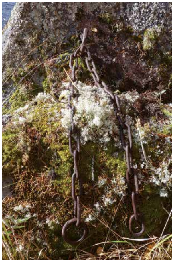
Fig. 84. Varpring (86), handtagsliknande 0,1 m stor länk islagen i berghäll samt en 0,3 m lång kedja. Belägen på åns N strand. Enligt kostnadsförslag i tabell i syn 1899 "Enkel läns t.v. 115 m à 0.30. 34.50 kr [kostnad för föreslagna åtgärder i flottningsbyggnad]" (LA).
