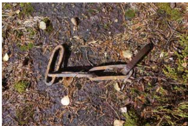
Fig. 84. Varpring (86), handtagsliknande 0,1 m stor länk islagen i berghäll samt en 0,3 m lång kedja. Belägen på åns N strand. Enligt kostnadsförslag i tabell i syn 1899 "Enkel läns t.v. 115 m à 0.30. 34.50 kr [kostnad för föreslagna åtgärder i flottningsbyggnad]" (LA).
