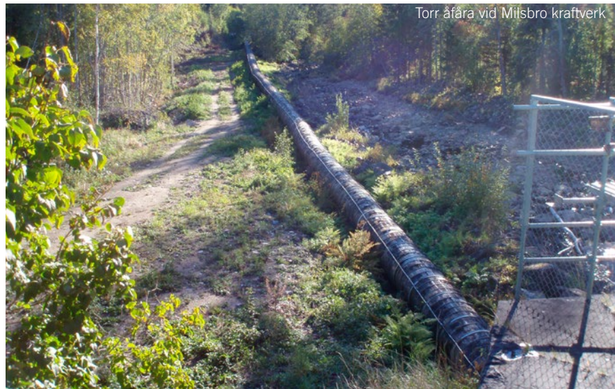
Torr åfåra vid Milsbro kraftverk
