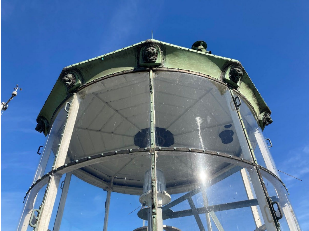
Lanterninens välvda glas tillkom 1903 vid byte av fyrapparat.
