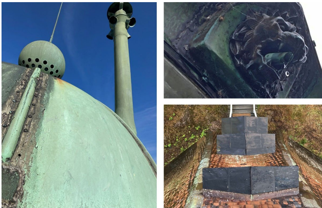
Bilden till vänster. Lanterninens kupoltak med skruvade täcklistor av koppar. Bilden uppe till höger. Vattenutkastare av gjutgods (brons) från 1859. Bilden nere till höger. Takhuvorna för entrédörr och fönster, tak av kopparplåt.
