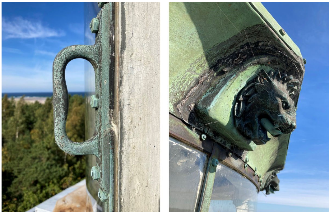
Bilden till vänster. Handtag för fyrpersonalen att hålla sig i vid fönstertvätt. Bilden till höger. Vattenutkastare av brons i form av lejonhuvud från året 1859. Vid demontering är det viktigt att alla beslag och skruvar märks upp för att återmonteras rätt.
