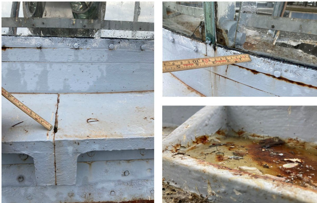
Bilden till vänster. Det nedre svängda hammarbandet som tillkom 1903. Bilden uppe till höger. De välvda glasen som ersatta tidigare plana 1903. Bilden nere till höger. Detalj av nedre hammarbandets insida med uppsamlingsränna för kondensvatten.
