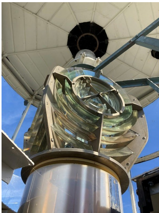
Bilden till vänster. Nuvarande roterande fyrlinsen av 4:ordningen (500mm) Bilden till höger. Högst upp en reservlins monterad ovan ordinarie lins.
