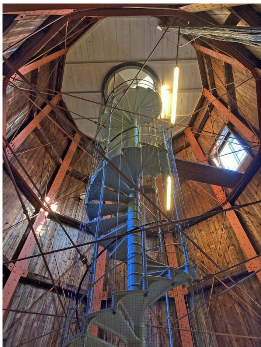
Bilden till vänster. Den centrala spiraltrappan av gjutjärn. Bilden till höger. Entré och nedre takhuv mot öster.
