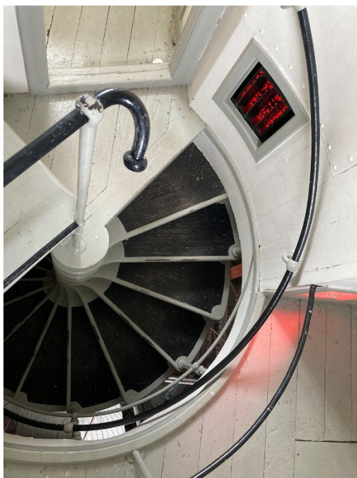
Bild till vänster. Trapphålets räcke avslutas med en smäcker svartmålad knopp. Bild till höger. Fyrtrappan avslutas med en mässingsknopp.
