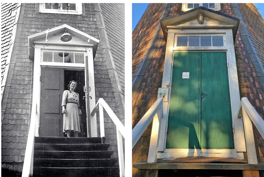
Bild till vänster. Entrédörren 1949. Utanpåliggande fyllningar. Bild till höger, Entrédörr idag, klädd med masonit, troligen är det samma ram, men speglarna är borttagna.
