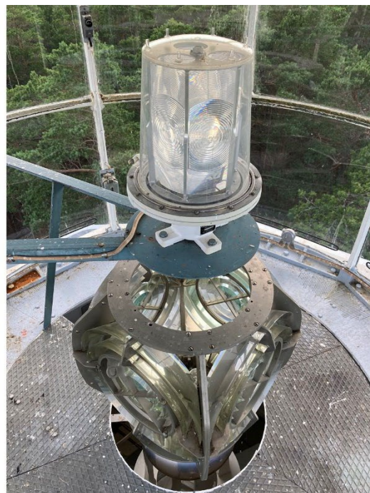
Bilden till vänster. Nuvarande roterande fyrlinsen av 4:ordningen (500mm) Bilden till höger. Högst upp en reservlins monterad ovan ordinarie lins.
