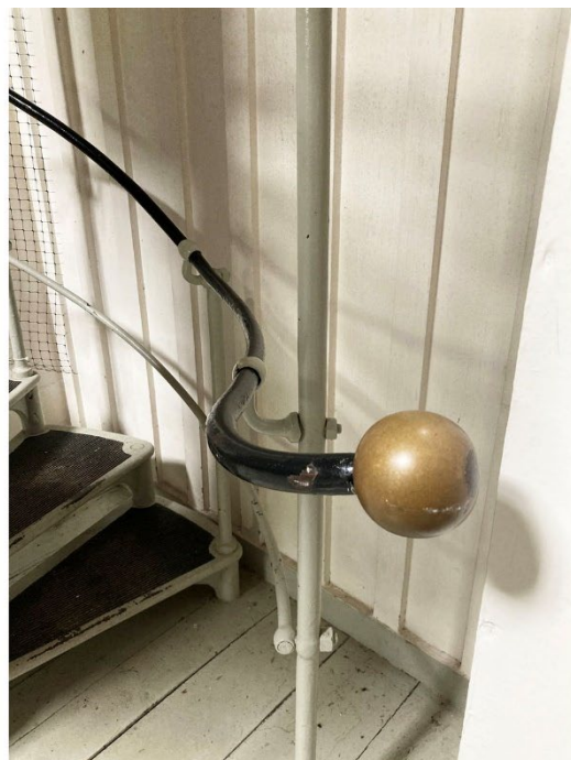
Bild till vänster. Räcke entréplan kring lodets schakt. Bilden till höger. Fyrtrappans handledare avslutas nere med en mässingsknopp.
