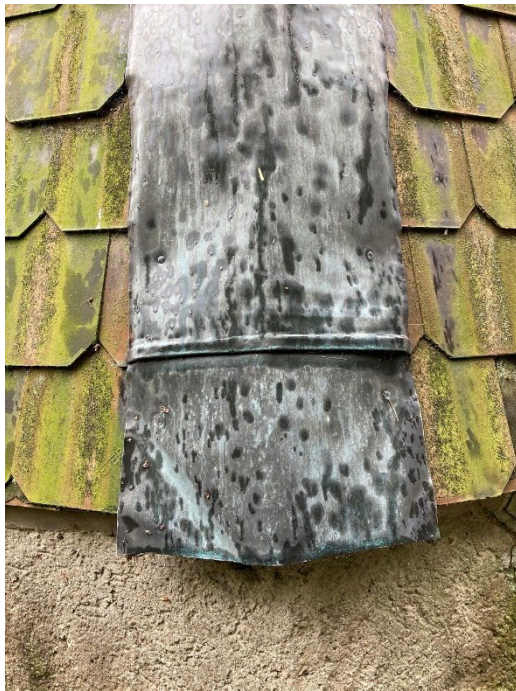
Bilden till vänster. Fyrtornets tio ytterhörn är klädda med kopparplåt. Bilder uppe till höger. De karakteristiska kopparspikarna med "smidd" skalle.
