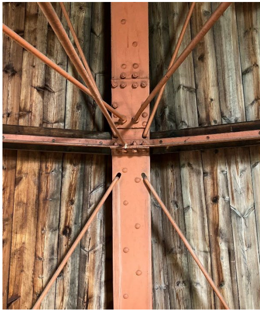
Bilden till vänster. 1903 förstärktes stålstommen med mängder av dragstänger som spändes in med vantskruvar. Anledningen var att fyrtornet svajade vid hård vind. Bilden till höger. Fyringenjörkontorets ritning till stagning 1903. Sjöfartsverkets arkiv.
