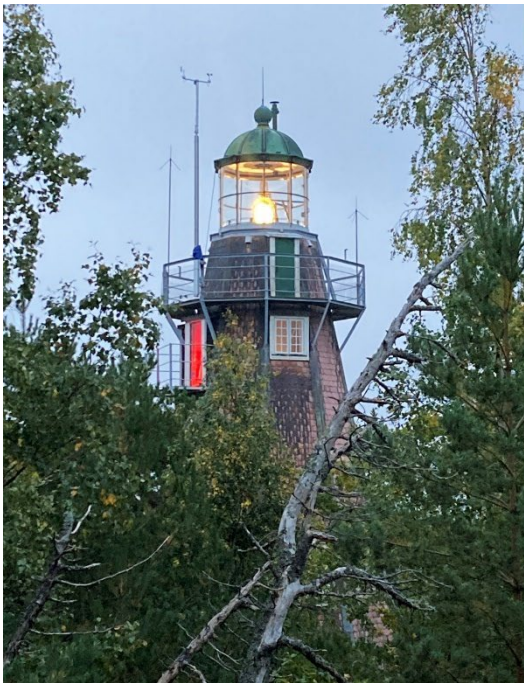
Bilden till vänster. Huvudlinsen (vitt sken) och bifyren (rött sken) en tidig morgon. Bilden till höger. Fyrtornet sett från väster.
