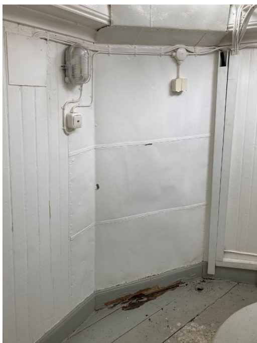
Bild till vänster. Skyddsplåten mot strålningsvärme från kaminrör i vaktrummet.
