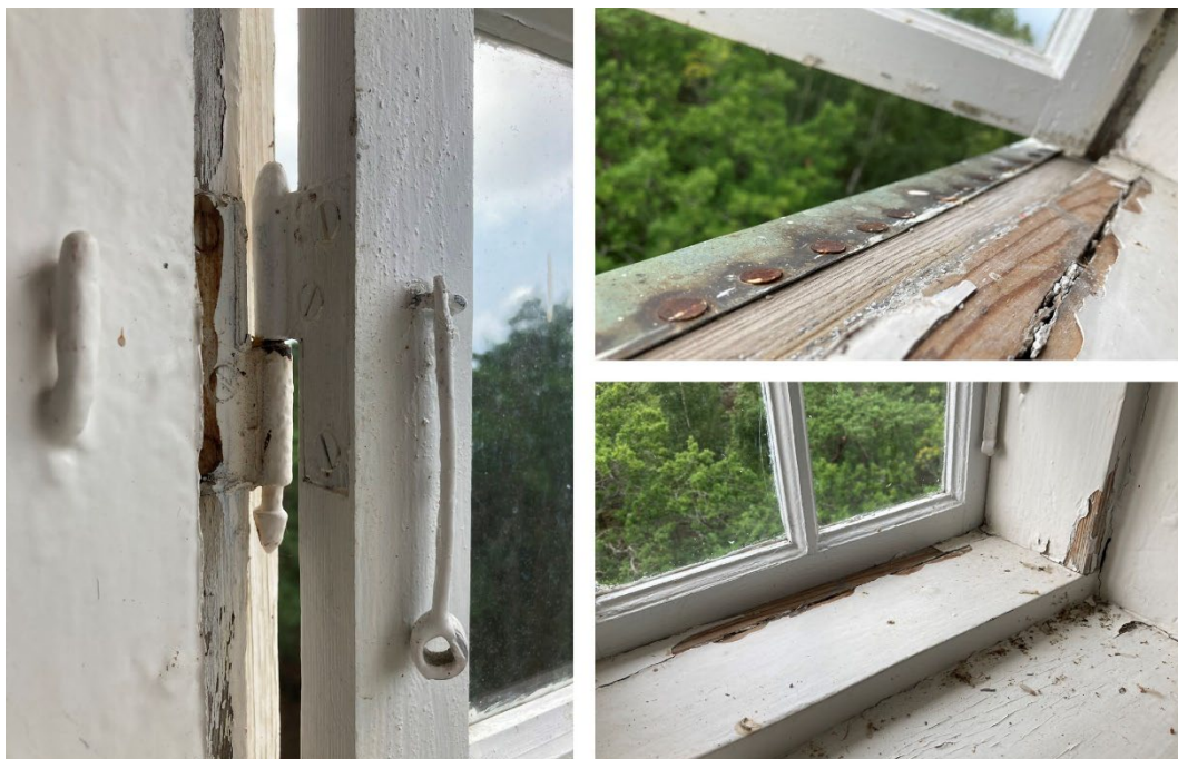
Bilden till höger. Ursprungliga gångjärn och uppställningsbeslag. Bilden uppe till höger. Vissa fönster har tillägg av en plåt på karmunderstycket. Bilden nere till höger. Fönstren delvis målade med diffusionstät färg.
