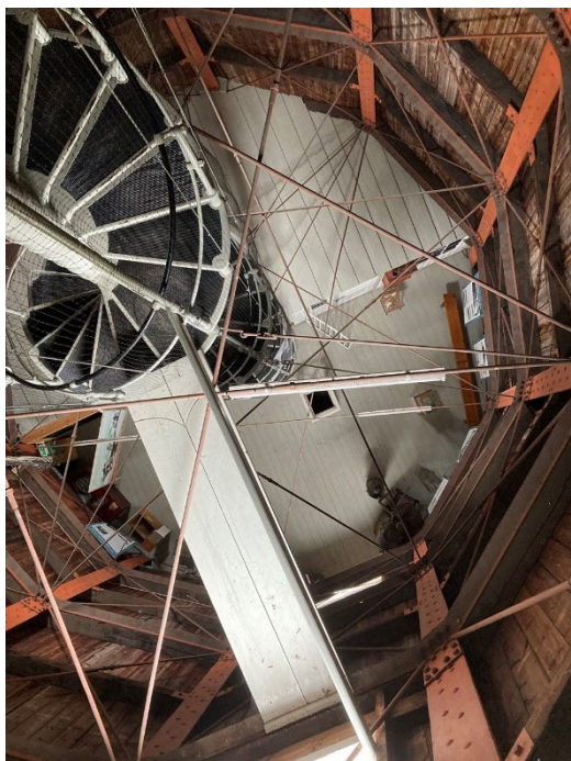
Bild till vänster. Spången till fönsterhuv. Bilden till höger. Fyrtrappan av gjutjärnssteg med sväng handledare av stål.
