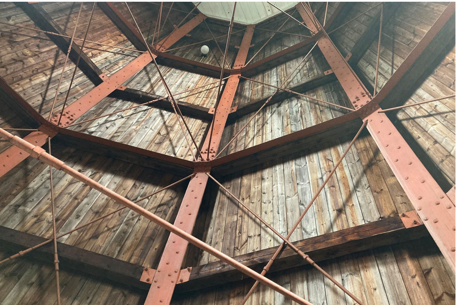
Den rödmålade järnstommen med beklädnad av stående tvåtumsplank.
