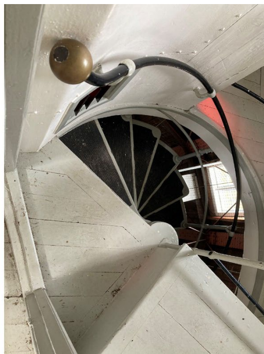
Bild till vänster. Trapphålets räcke avslutas med en smäcker svartmålad knopp. Bild till höger. Fyrtrappan avslutas med en mässingsknopp.
