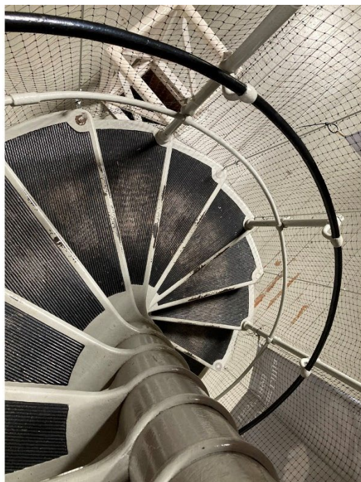
Bild till vänster. Spången till fönsterhuv. Bilden till höger. Fyrtrappan av gjutjärnssteg med sväng handledare av stål.
