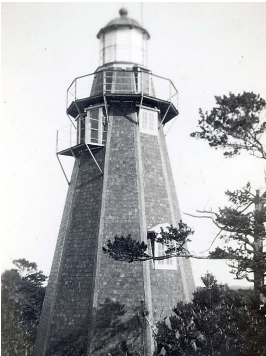
Fyrtornet kläddes med Eternit redan i mitten av 1920-talet. Foto 1929 Gotska Sandöns Hembygdsförening.
