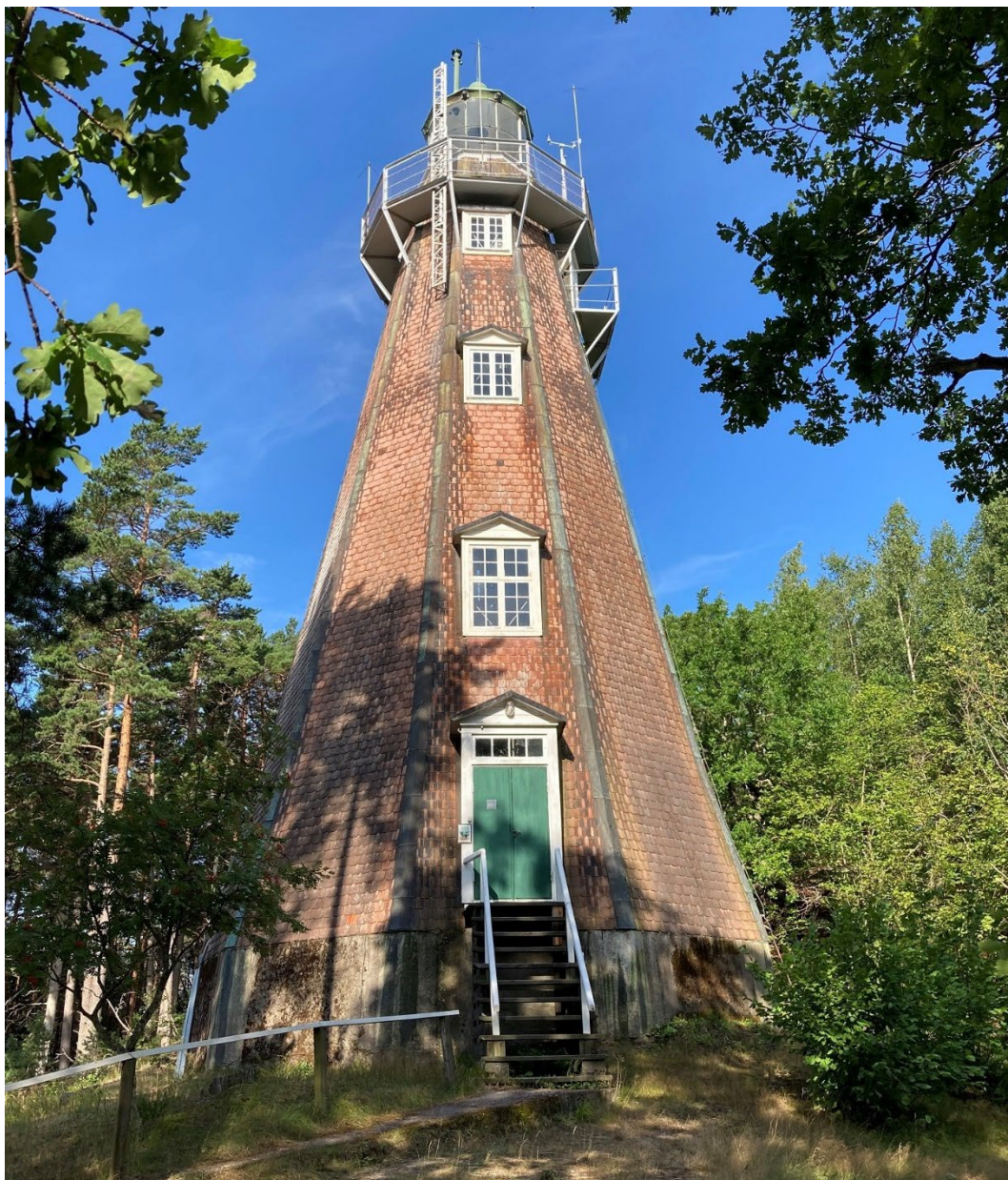
Fyrtornets entré från öster, Samtliga fönster är original från 1859.
