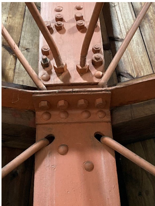
Bilden till vänster. Sammanfogning av stålkonstruktionen med skruvförband. Bilden till höger. En av de tio vattenutkastarna av brons och koppar på lanterninen.
