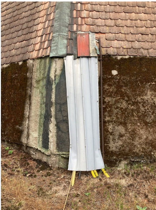
Bilden till vänster. Eldragningar slarvigt täckta med aluminiumplåt Bilden till höger. Rostsprängning i betongfundament.
