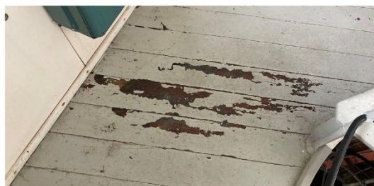
Bilden till vänster. Nuvarande fyrlins vilar på det gamla gjutjärnsfundamentet. Bilden uppe till höger. Luckan upp till lanterninens golv. Bilden nere till höger. Vaktrumets golv är bemålat med diffusionstät färgtyp.
