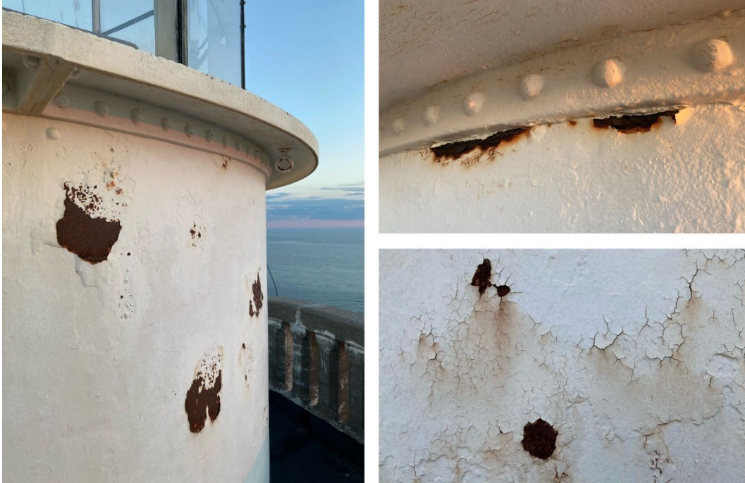
Lanterninen bas är tillverkad av nitad. Rostskyddsmålad och täckmålad vit
