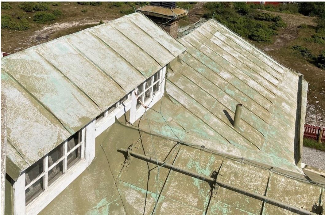
Den nuvarande, påbyggda, skyligheten över trapphuset täcker in den ursprungliga.
