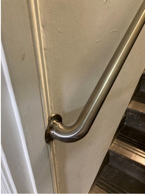
Huvudtrappans handledare av rostfritt stål.
