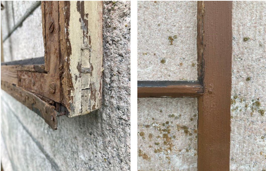
Ursprunglig enkelbåge med påsikad plåtremsa. Originalkulör troligen mörkockra.
