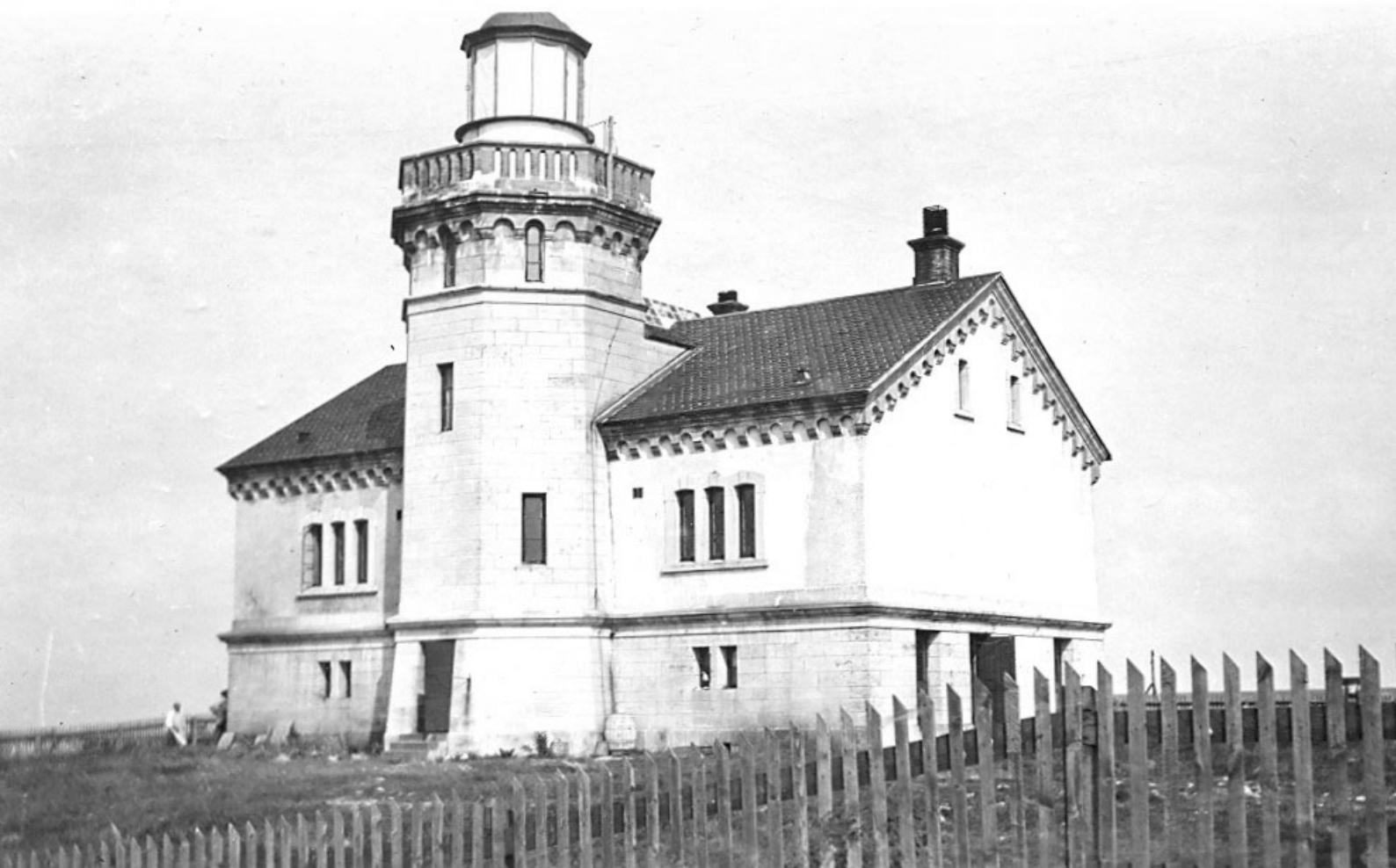
Fyrbyggnaden 1925. Papptaket är utbytt mot skiffer. Foto Sjöfartsverkets arkiv.
