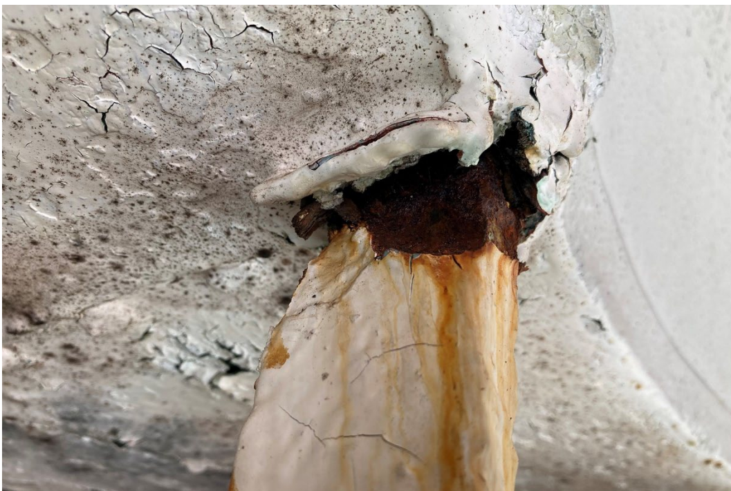
Del av järnstommen som bär upp kupoltaket.
