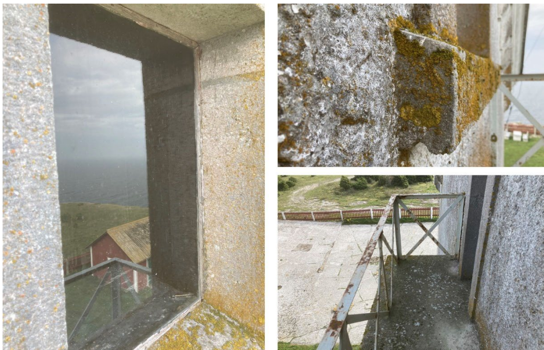
Bild till vänster. Bifyrens fönster sitter direkt mot stenomfattningen utvändigt. Bilden uppe till höger. Fönstrets undre stenomfattning med droppnäsa. Bilden nere till höger. Balkongens nitade järnräcke.
