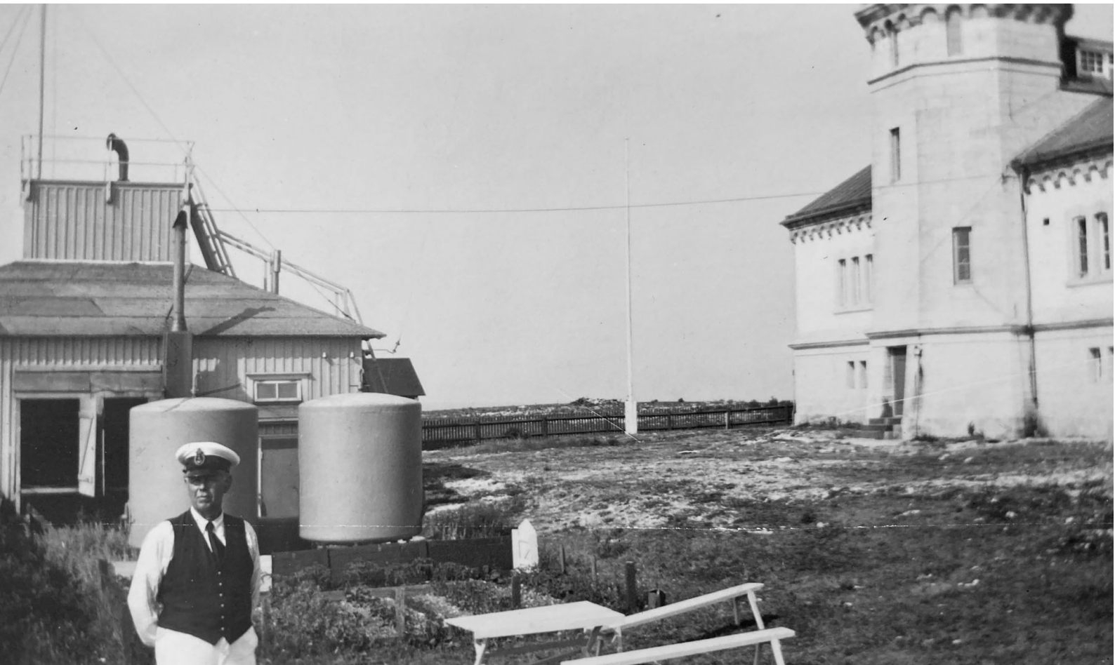
Fyrvaktare Gustaf Jakobsson framför Mistmaskinhusets råoljetankar. Luftledningen mellan byggnaderna tillhör radiofyren. Foto ca 1940, Sven Jakobsson privat.
