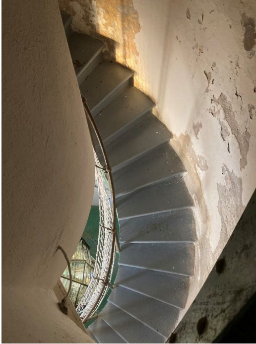
Bilden till vänster. Armerad betongtrappan är platsgjuten i ett helt stycke utan skarvar. Bilden till höger. Trappan börjar med ett bredare steg och en kraftig räckesstolpe.
