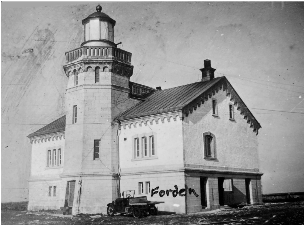
Fyrbyggnaden har fått ett svart falsat plåttak. Foto tidigt 40-tal, Sven Jakobsson privat. Parkerad vid fyren den T-ford -26 som nyttjades till transporter från Norderhamn mm
