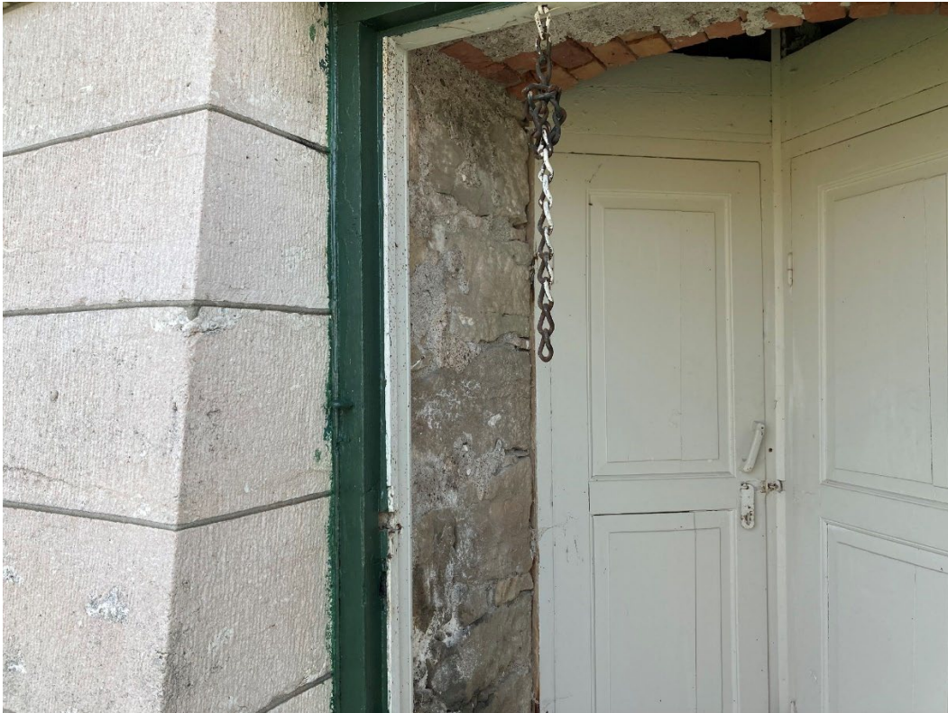
Ingång till matkällare i botten av fyrtornet. Den fint tandhuggna ytan på murverkets utsida övergår till grovhuggen kalksten på insidan.
