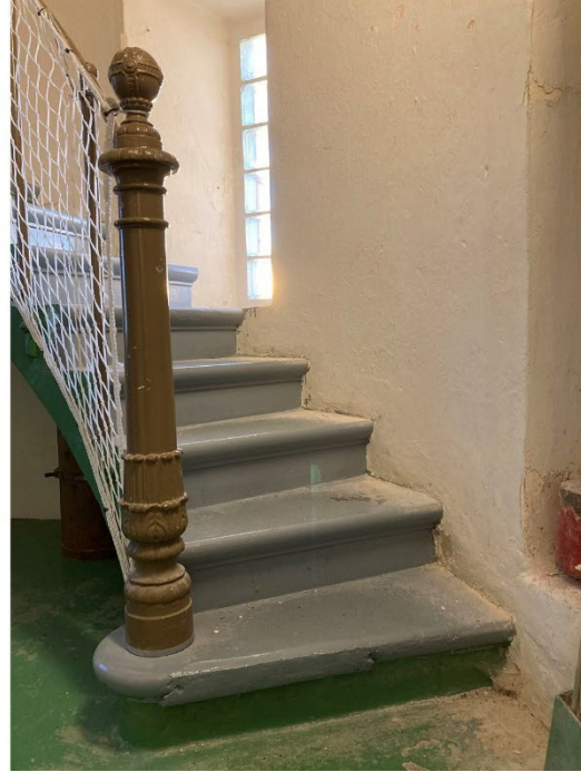
Bilden till vänster. Armerad betongtrappan är platsgjuten i ett helt stycke utan skarvar. Bilden till höger. Trappan börjar med ett bredare steg och en kraftig räckesstolpe.
