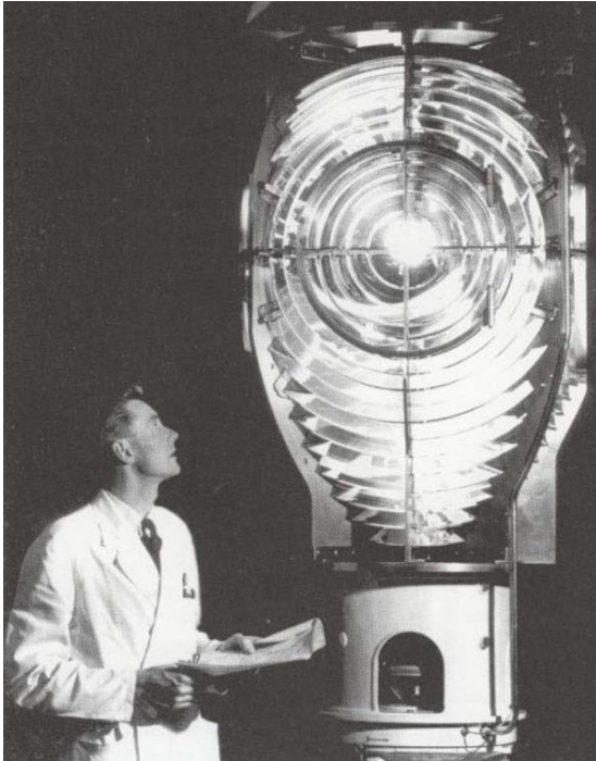
Bilden till vänster. Acetylenlågans ljusstyrka var mer än tillfredställande. Bild ur "Den stora boken om fyrar". Bilden till höger (tillägg) Nils Gustav Dalén. Fyrwiki.
