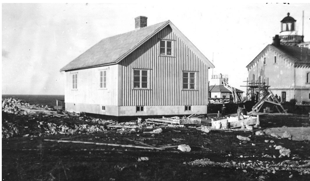
Den nya fyrmästarbostaden under uppförande 1938. Vid fyrbyggnadens södra gavel är ställning rest för upptagande av fönstret i fyrmästarens kök. Foto Sjöfartsverket.
