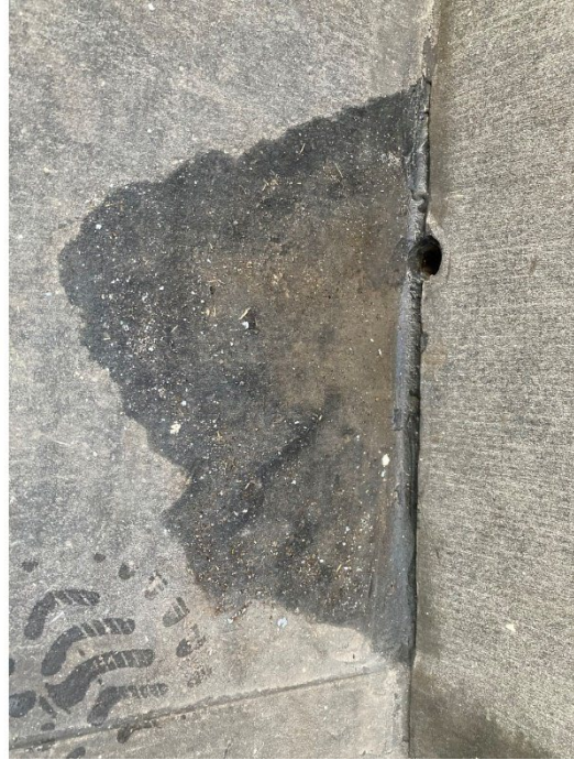
Bilden till vänster. Vertikalt utloppsrör i tätskiktet (vid inventering igensatt av sand) Bilden till höger. Horisontellt utloppsrör genom balustraden.
