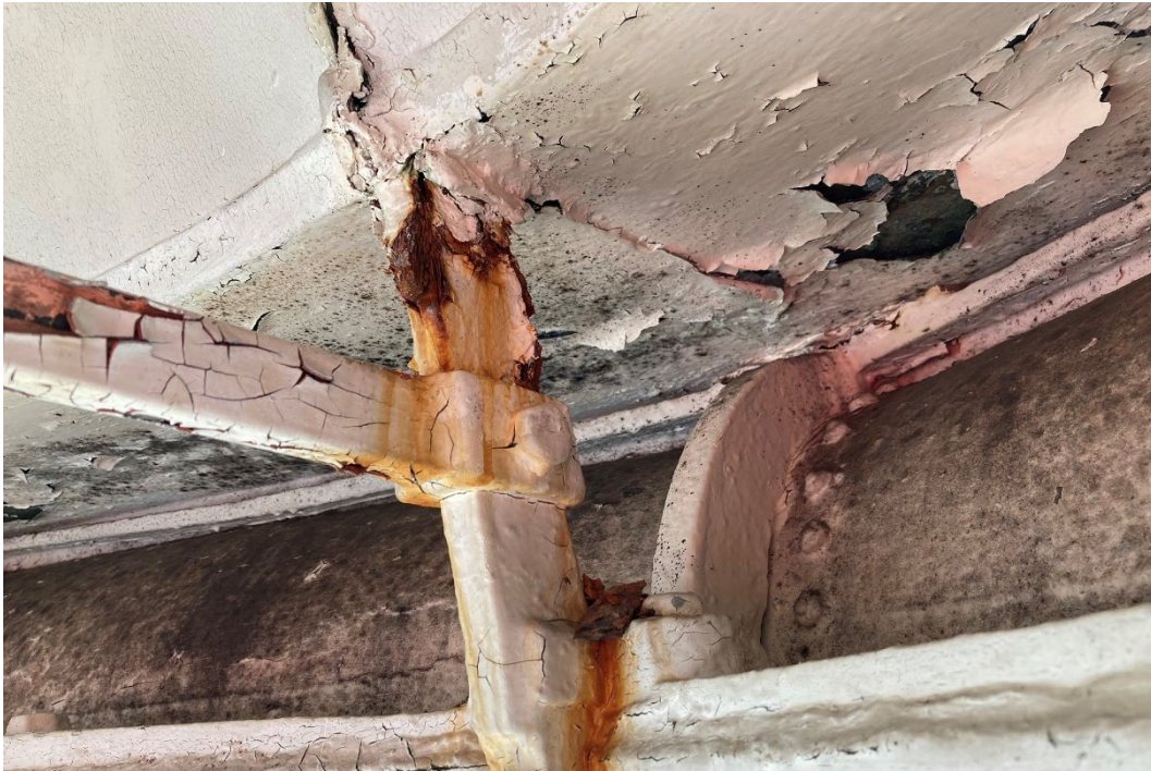
Lanterninens järnstomme var vid inspektionen bitvis mycket rostangripen.
