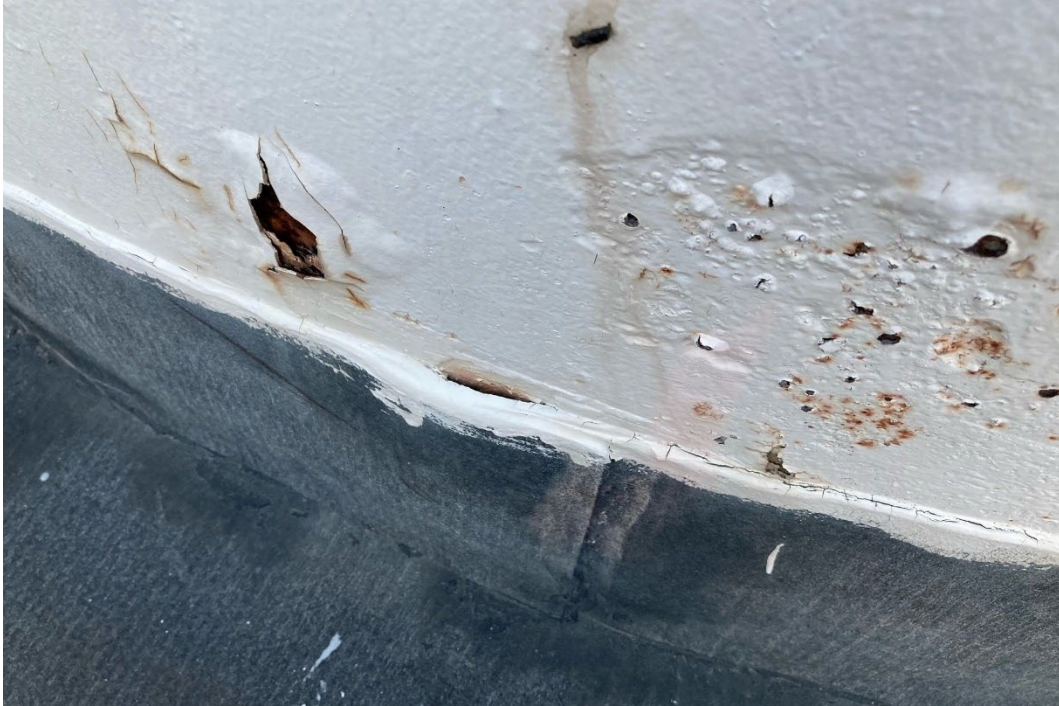
Gummiduken är uppvikt och helsvetsad mot stålplåten i lanterninen.
