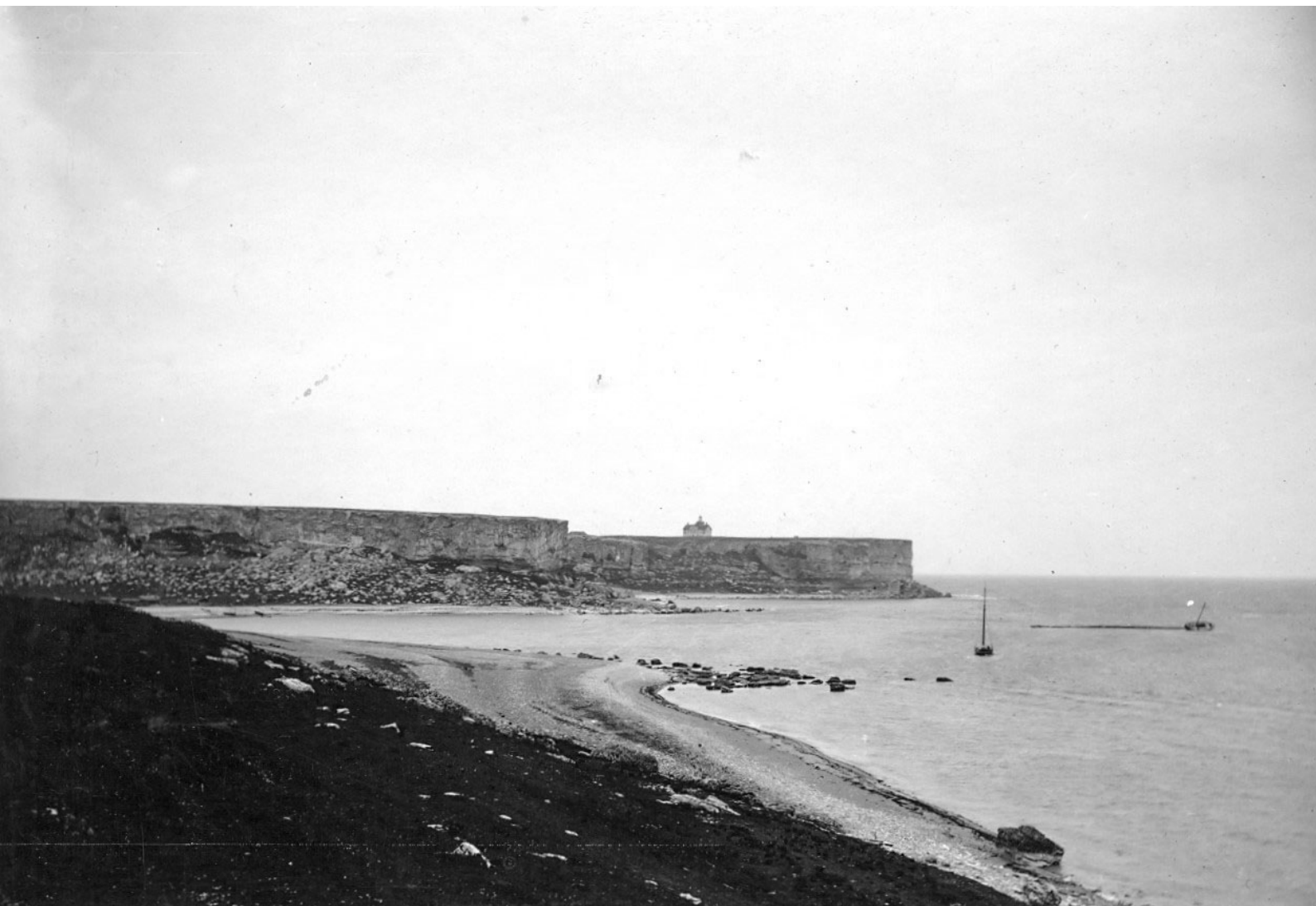
Det kombinerade Fyr- & bostadshuset fotograferat från Utfall av överingenjör John Höjer 1888. Foto Riksarkivet, Lotsstyrelsens arkiv.
