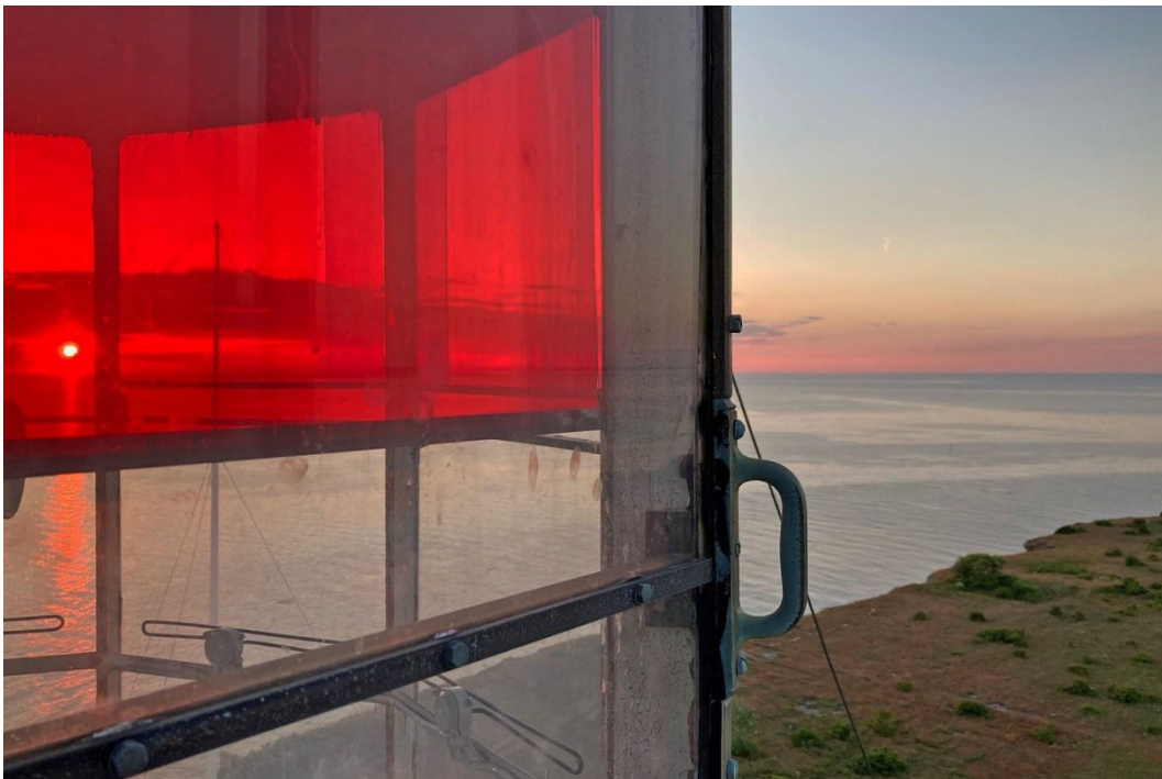
Glasen (Plexiglas) i lanterninen sitter fast med skruvade mässingslister. Handtaget av mässing eller brons var till för fyrbetjäningen att hålla sig i vid putsning av glasen.
