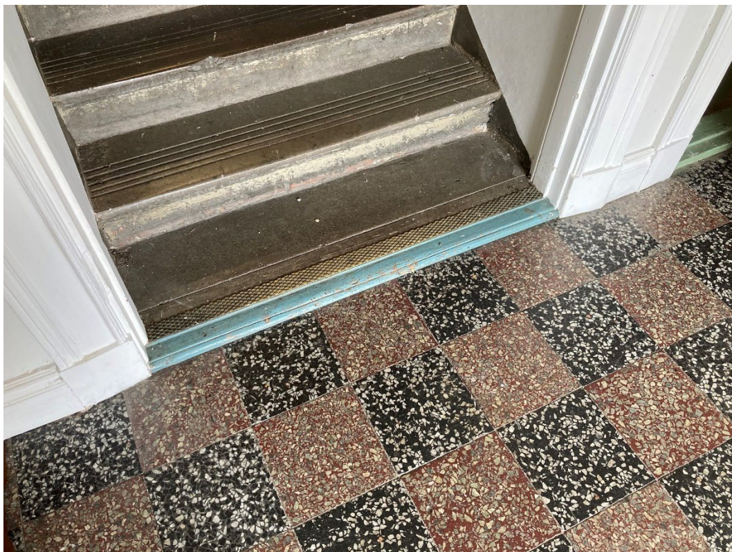
Entréhallens plattor av terrazzobetong och trappan av öländsk mörkröd kalksten.
