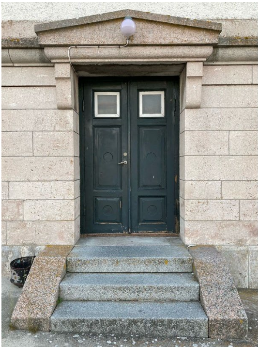
Bilden till vänster. Entrédörren av ek. Trappa och trappsidor av granit. Bilden till höger. Ingången till huvudtrappan där det tidigare satt en glasad pardörr.
