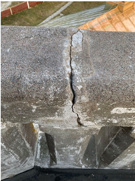
Betongbalustraden runt fyrterrassen är den ursprungliga från 1887, ett tidigt exempel på betong som byggnadsmaterial i utsmyckningar.
