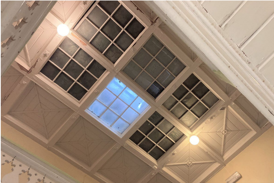
Trapphusets glasade undertak under den utvändiga skyligheten. Ett fack har på provrensats från isolering för att testa ljusinsläppet.
