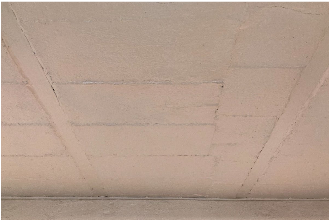
Källarbjälklag av betong gjutet mot brädform med ingjutna, bärande järnbalkar.
