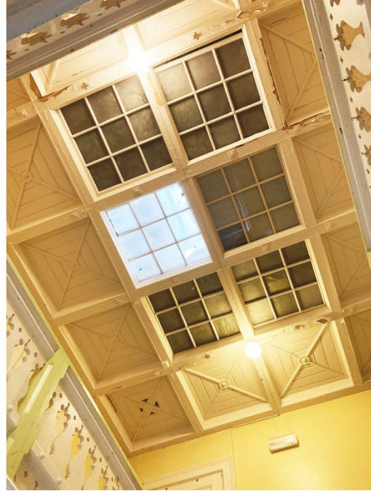
Bilden till vänster. Den ursprungliga skyligheten med vinklade glas. Bilden till höger. Undertaket består av ett ramverk av kraftiga träbjälkar.
