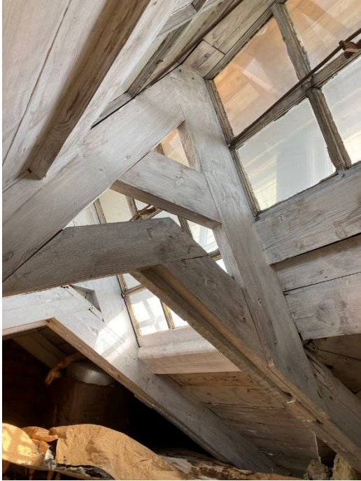
Bilden till vänster. Den ursprungliga skyligheten med vinklade glas. Bilden till höger. Undertaket består av ett ramverk av kraftiga träbjälkar.
