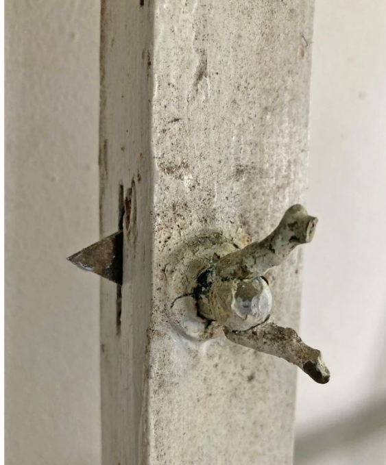
Ursprunglig inåtgående enkelbåge i fyrornets trapphus från 1887. Öppningsbeslag. Bågarna finns förvarade i förrådsutrymme utanför vaktrummet.
