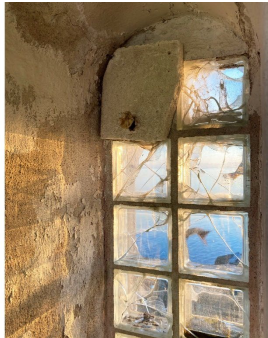
Bilden till vänster. Dörren till våningsplan med vaktrummet. Bilden till höger. Nästan samtliga betongglas i fyrtornet var vid inspektionen spräckta och några saknas helt. Hål är tätade med bruk och frigolit. Ursprungligen satt här inåtgående träbågar med enkelglas.
