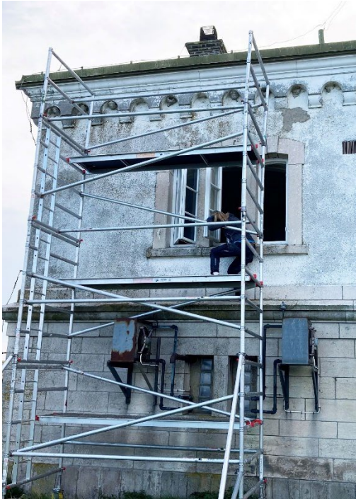
Bilden till vänster. Fasaderna behandlades avseende påväxt av alger. Bilden till höger. Helrenovering av fönsterbågar till fyrbyggnaden Karlsö Jagt- och Djurskyddsföreningen AB. Foto 2021
