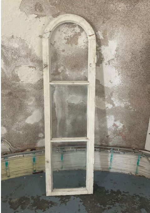
Ursprunglig inåtgående enkelbåge i fyrornets trapphus från 1887. Öppningsbeslag. Bågarna finns förvarade i förrådsutrymme utanför vaktrummet.
