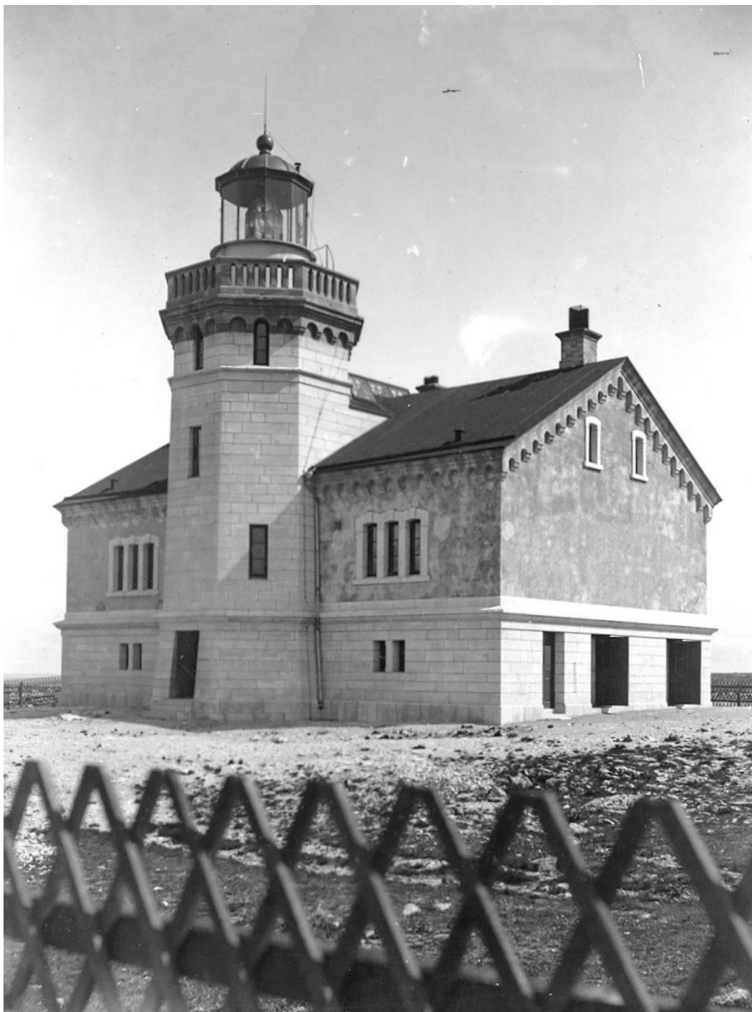
Fyren från sydväst strax efter färdigställandet. Taktäckning av tjärpapp lagd med listtäckning. Bakom fyrtornet syns den ursprungliga skyligheten till trapphuset. Foto 1888 i samband med John Höjers inspektion av nybygget. Sjöfartsverkets arkiv.
