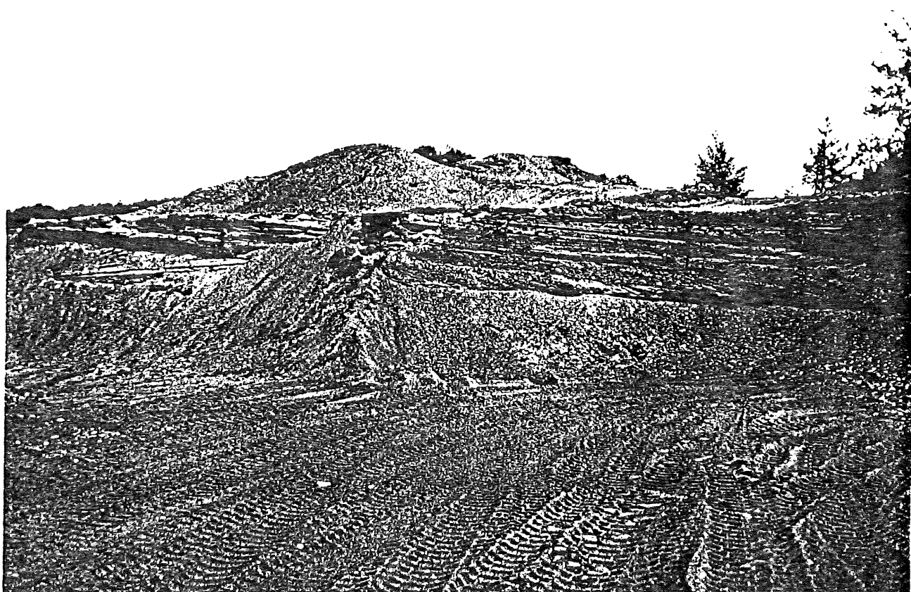
Figur 20. Totalt sett är det en klar övervikt av sand i Stångamalmen. Skärning i grusig svallsand avsatt på lager med väl sorterad sand. Sandtag T3. Foto: S-I Svantesson 1985.
