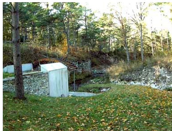
Bild 5. Kraftverket i Ireån. Vattnet som leds genom turbinerna mynnar till vänster i bild, huvudfåran går till höger.
