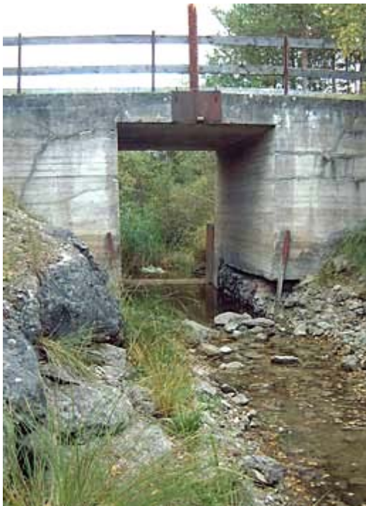
Bild 9. Dammkonstruktion i övre delen av inventeringsområdet.
