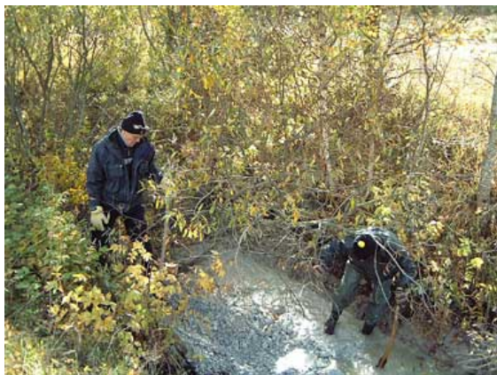
Bild 7. Konstruktion av lekplats för havsöring.
