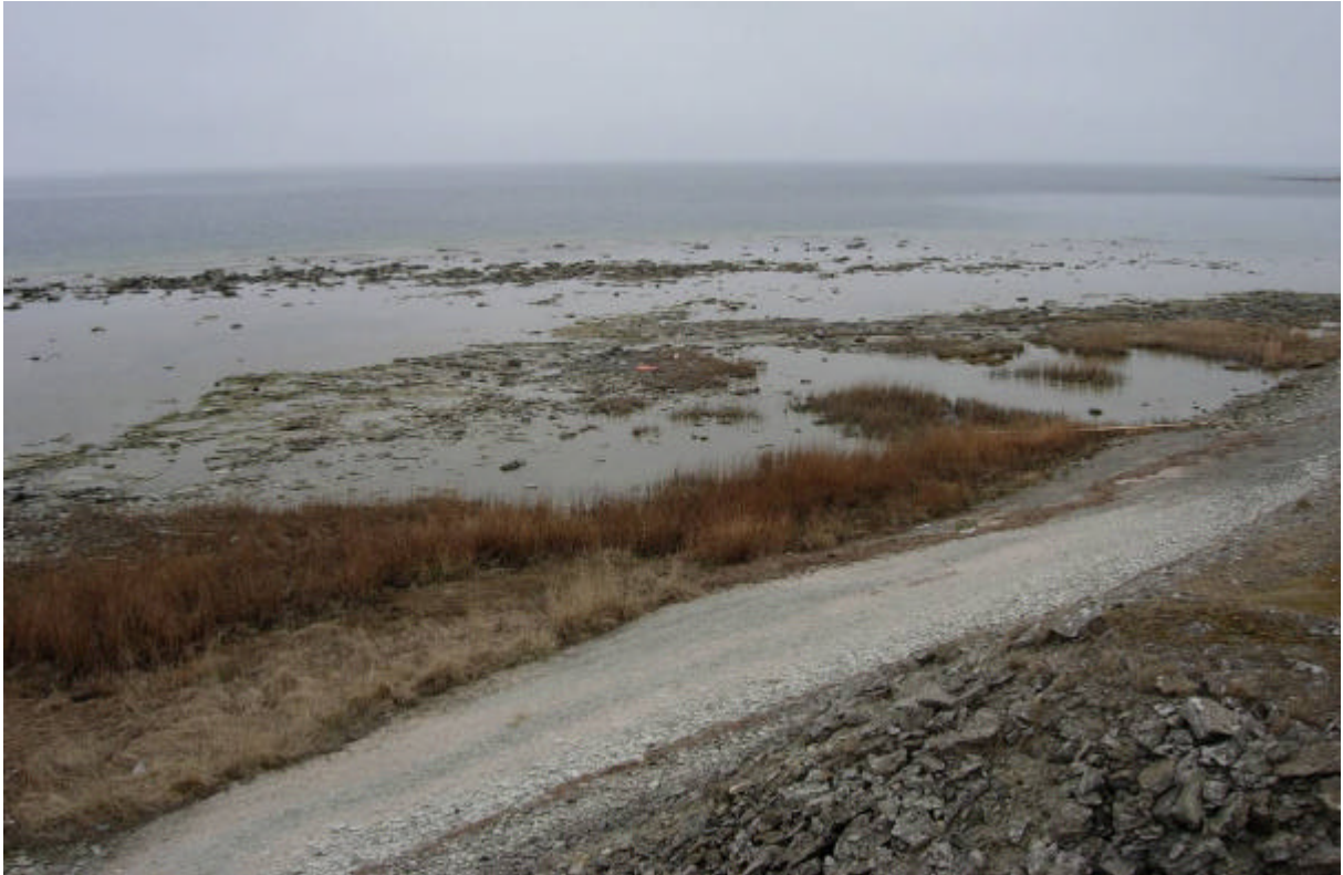
Figur 9b. Bilden visar den norra delen av damm 2. Vid besöket rådde lågvatten i havet och därmed var det lågt vatten även i damm 2.
