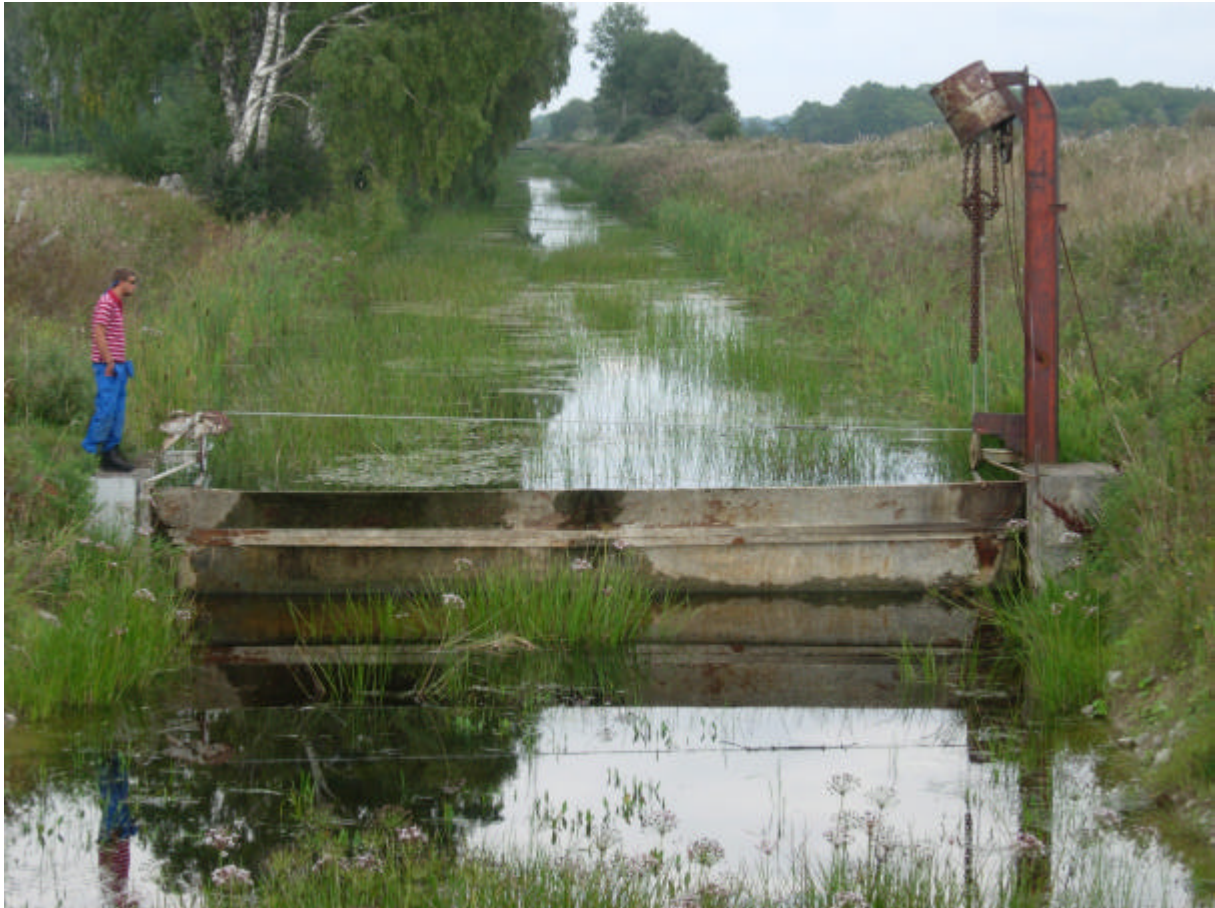
Figur 57. Reglerbar dammlucka i Snoderån (Storkanalen) som i uppfällt läge utgör ett totalt vandringshinder för alla vattenlevande organismer. Stora mängder juvenil abborre stod ansamlad i anslutning till dammluckan. Fundamentet göts 1969. Foto: Micael Söderman.
