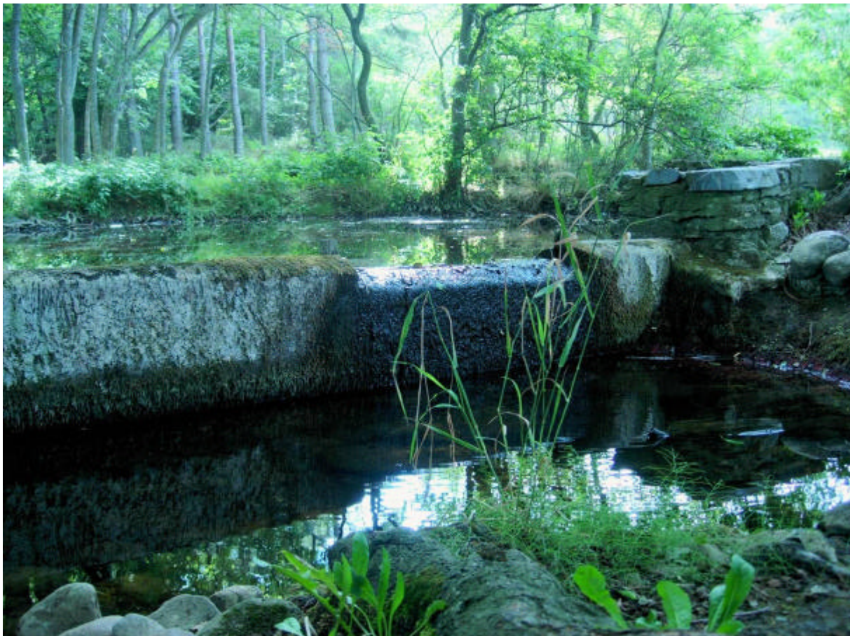
Figur 21. Dammen i Lummelundaåns mynning byggdes 1960 och är sannolikt orsaken till att åns flodnejonögonbestånd slogs ut. Foto: Micael Söderman.
