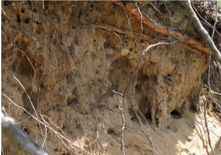
Fig 5. Stortapetsarbetet lägger ofta sina bon i eller i anslutning till "rothak", dvs överhäng som bildas av att rötter binder samman mark som i övrigt rasat bort. rothak förekommer ofta i kanter av täkter av naturliga skäl. Detta rothak ligger i 63 Gröna kullen, där stortapetsarbetet dock saknades.
