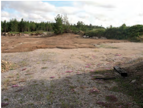
Överlagring av väl etablerad vegetation av baktimjan m.m. i grusmark. Det använda materialet är näringsrika tippmassor. För att täcka så stor yta som möjligt bredes lagret ut noggrant decimeterjockt. Russparken täkt. Pågående efterbehandling 2008.
