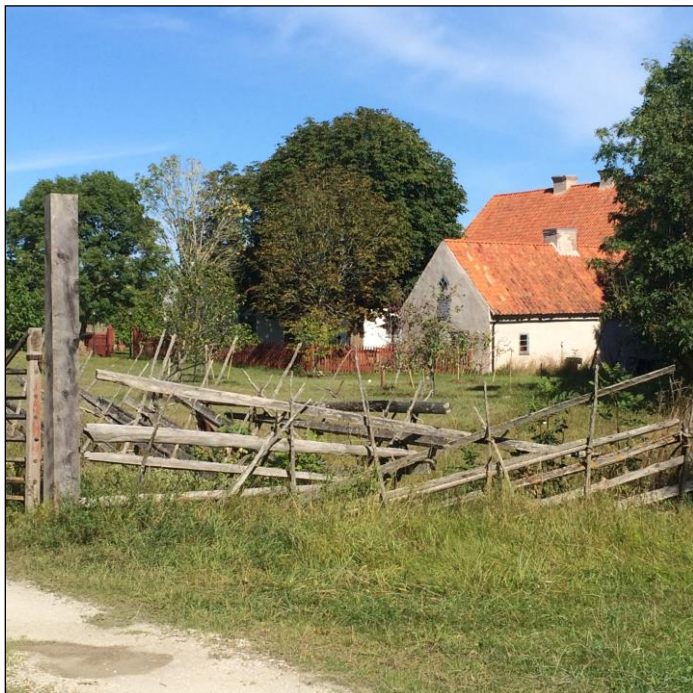
Mangårdsbyggnad och flygelbyggnad vid den västra parten på Hau gård.
