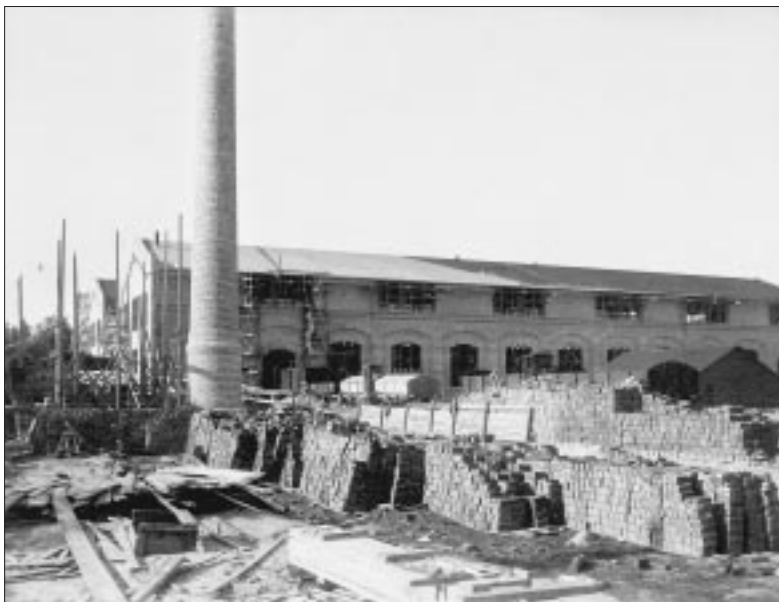
Byggnation av Notviksverkstaden, Notviken, Luleå kn.
