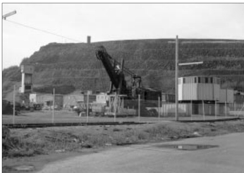
Kirunavaara, Jukkasjärvi sn (1999). Högt upp på Kirunavaara står Gråbergslaven, under den syns pallarna av gråstensavfall, som tidigt i brytningens historia gav berget en karaktäristisk siluett. Byggnaderna till vänster på bilden är gruvans man-skapsbaracker.
