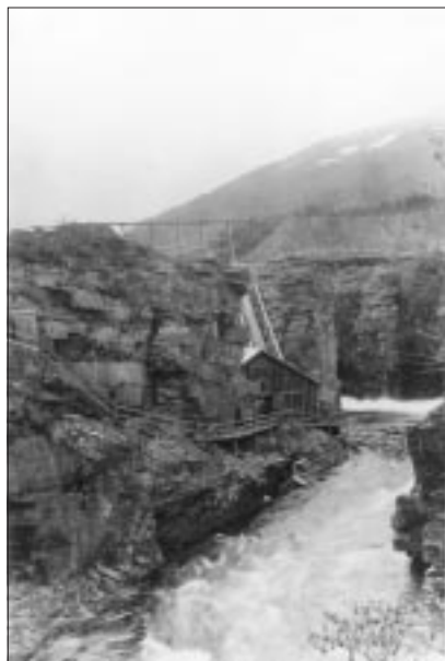
Elektricitetsverket i Abiskojokk, år 1900, Jukkasjärvi sn.
