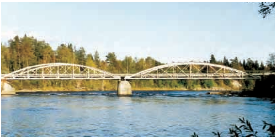
Fackverksbro av stål över Öre älv i Nordmalings kommun. Bron byggdes 1911 och stålfackverket levererades av Bergsunds Mekaniska verkstad i Stockholm. Foto: Andreas Grahn.
