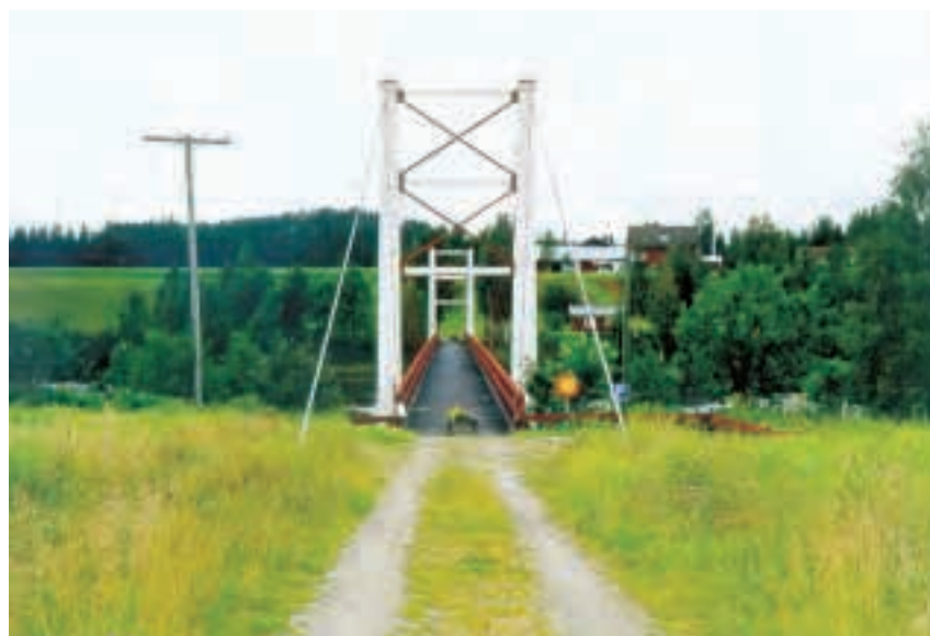
Hängbro över Vindelälven i Sellet. Bron byggdes 1929. Tornen och överbyggnaden är av trä. Numera används bron för gång- och cykeltrafik.
