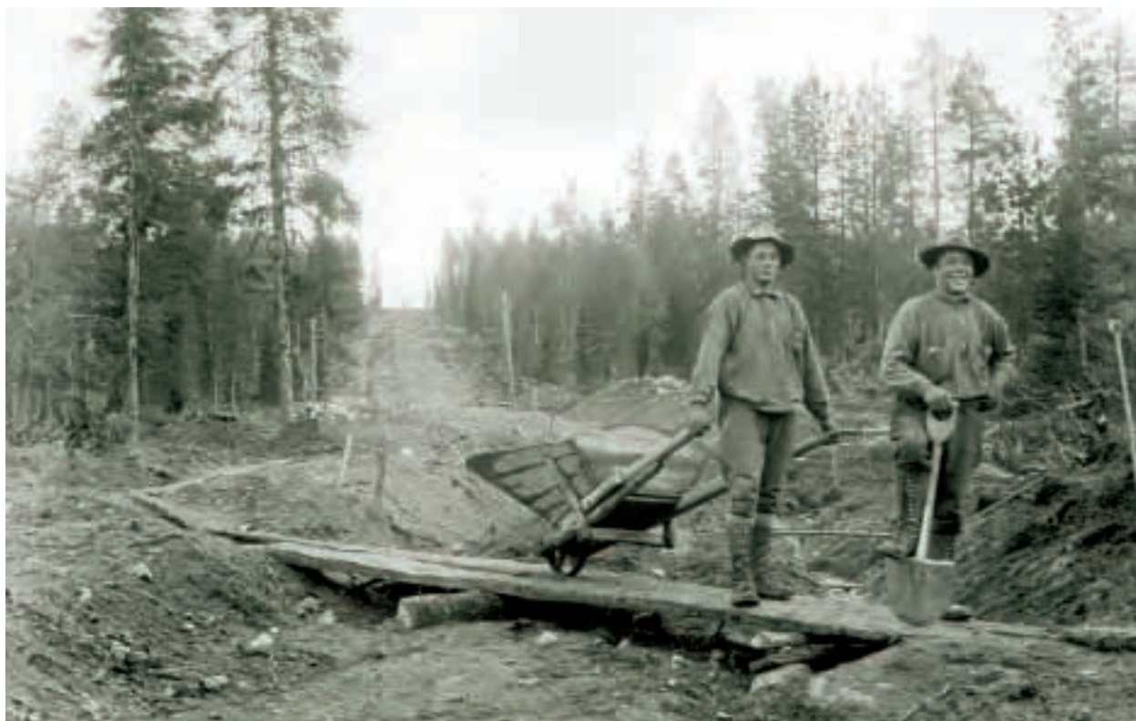
Vägbygge i Sorsele 1932. Foto: Västerbottens Museums fotoarkiv.
