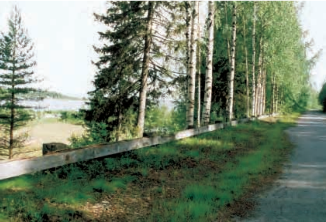
Gamla Riks 13 i Jävre. Vägen löper i högt läge, längs med åsen, med utsikt mot E4 och Jävrefjärden. Vågräcke av stengardister med navföljare i trä (420 m långt). Foto: Andreas Grahn.
