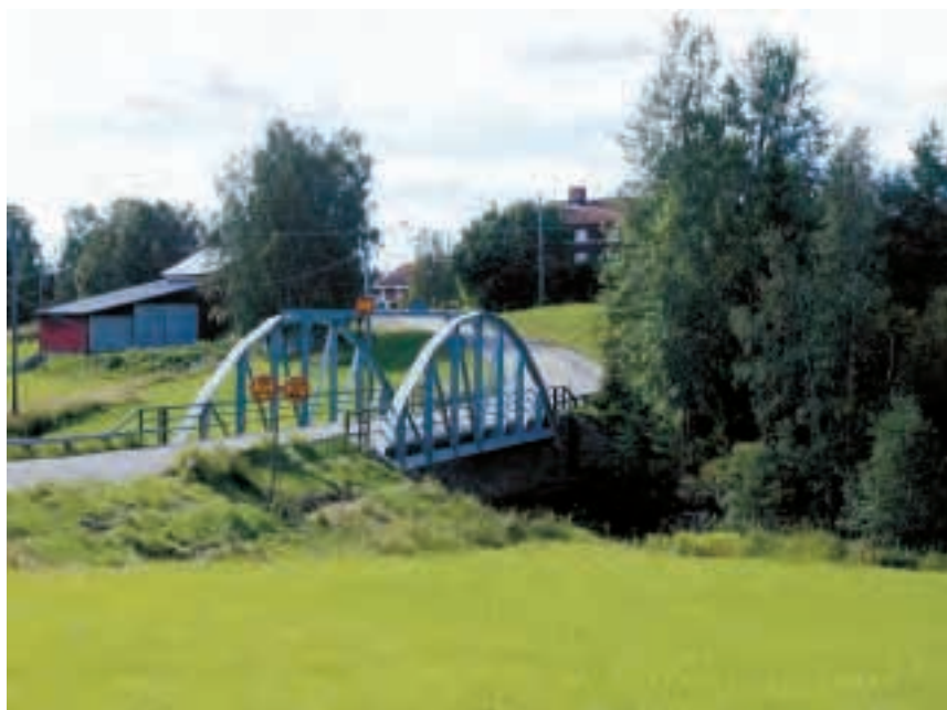
Väg 666. Fackverksbro över Rickleån, byggd 1926. Foto: Jeanette Joelson.
