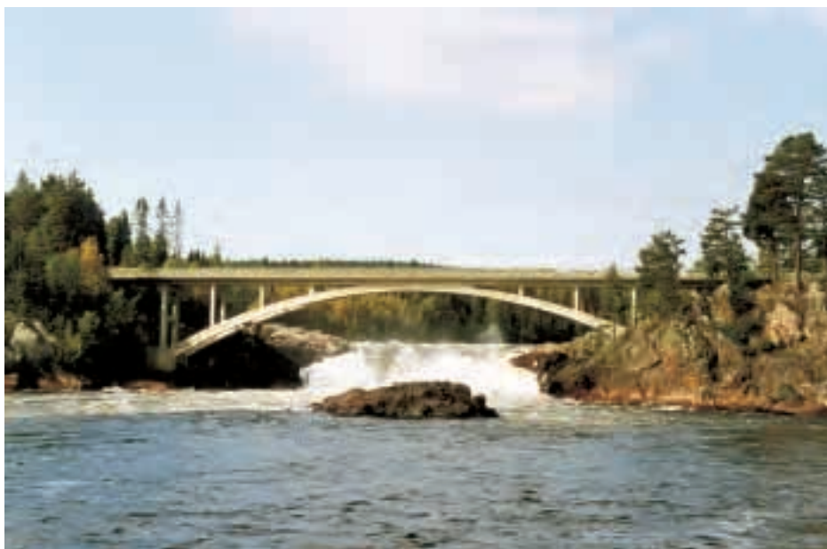
Bron över Kalixälven vid Jokkefall, den enda betongbågbron med överliggande brobana i trafik på statliga vägar i Norrbotten. Hela bron sedd från sidan, nedströms, mot VNV. Foto: Andreas Grabn.
