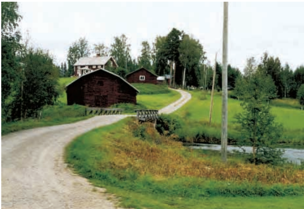
Södra kroken till Småträsk, väg 517. Smal grusväg som passerar äldre bebyggelse, uthus, rundloge. Balkbro med trädäck och träräcke. Foto: Andreas Grahn.
