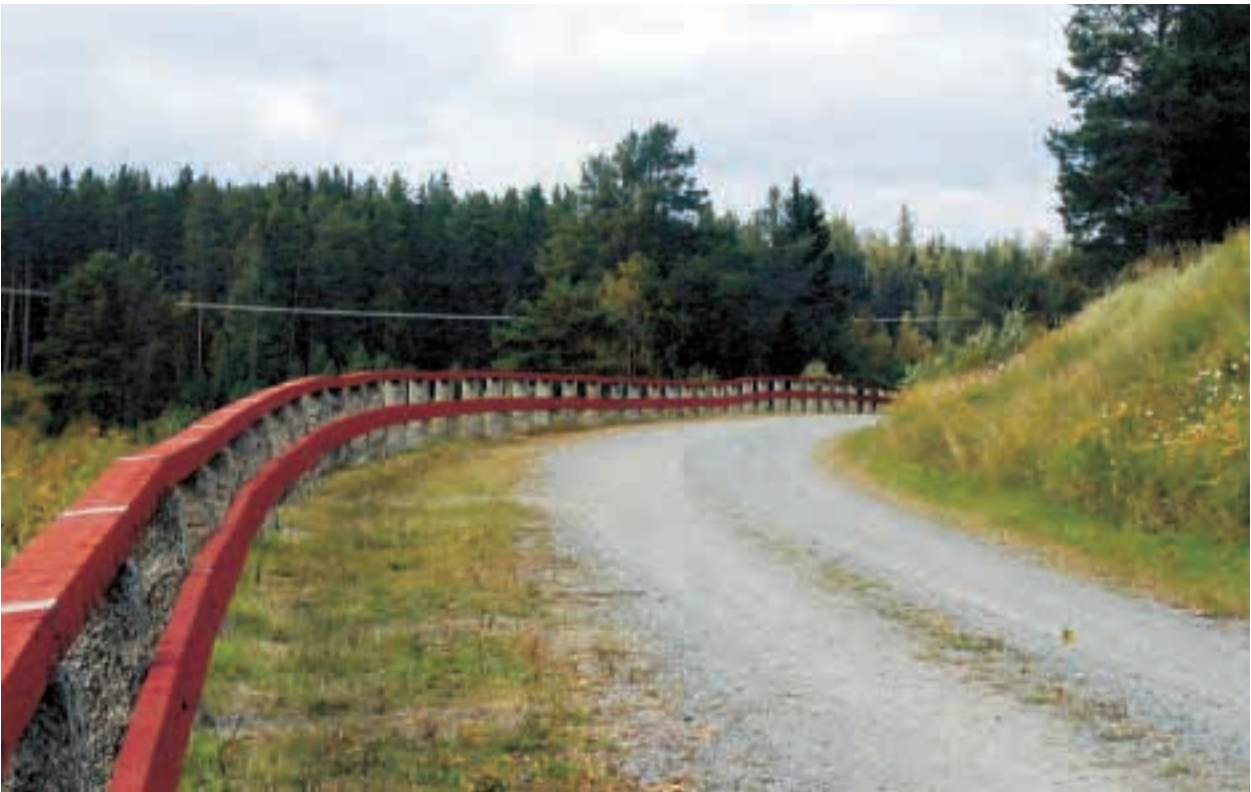
I byn Bränna, Vilhelmina kommun, finns ett 168 m långt vägräcke med stengardister, navföljare och toppliggare av trä. Räcket restaurerades år 2000. Foto: Jeanette Joelsson.
