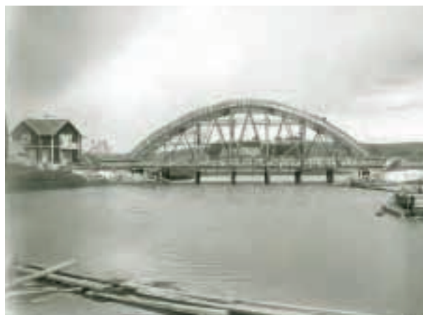
Betongbågbro i Gamla Falmark, Skellefteå, under byggandet på 1930-talet. Foto: Västerbottens Museums fotoarkiv.
