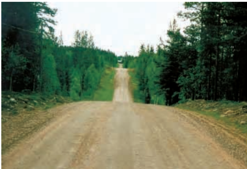
Karaktäristiska drag för s.k. AK-vägar, byggda under 1930 och 1940-talen, var den raka sträckningen och de återkommande variationerna i böjddled. Foto: Agneta Milton.
