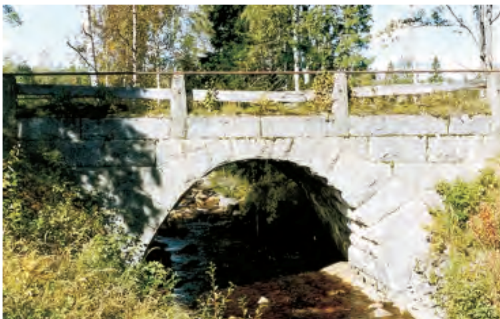
Stenvalvsbron över Stridbäcken vid Ava, uppfördes 1929-30 och ingick då i kustlandsvägen.
