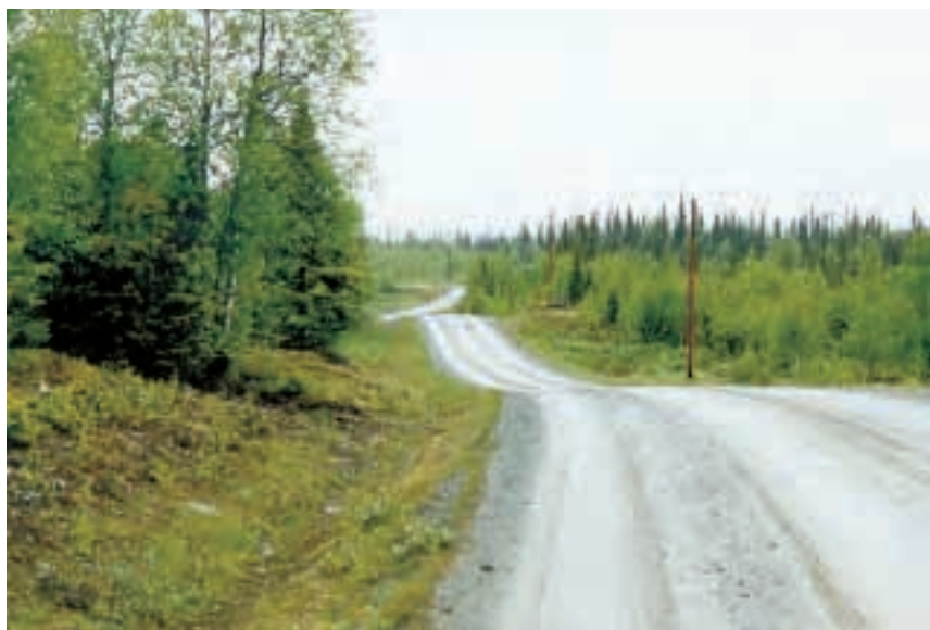
Väg 1093 från Dikanäs och norrut är kuperad och kurvig. Vägen byggdes på 1930-talet med en bredd på 3,0 m. Foto: Karolina Karlsson.
