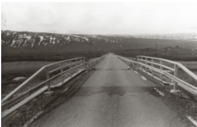
Räckan med en typisk utformning från början av 1970-talet. Toppföljare av U-balk, navföljare och vägräckan av omålade, galvaniserade kohlswabalk. BD 1366, plattambro över Vistas älv på väg 870 i Nikkaluokta, byggd 1973. Foto 1973, Vägverket Region Norr.
