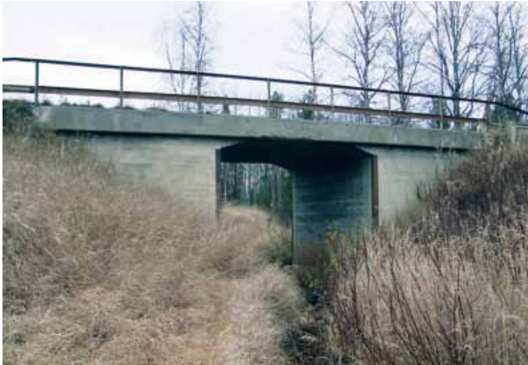
Plattrambro över Kosterbäcken byggdes redan 1933.
