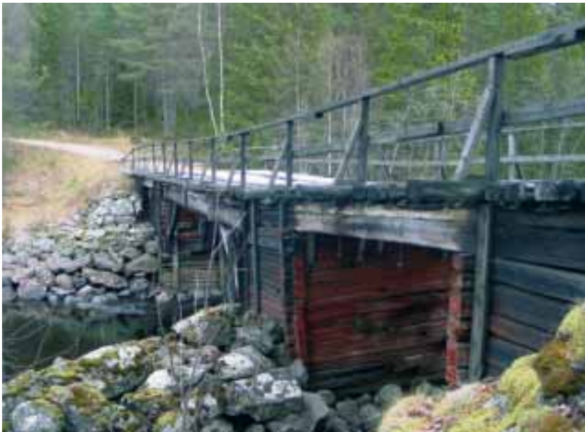
Sågforsbron i Piteå byggdes 1902, men kunde ha byggts redan flera hundra år tidigare. Den har en mycket ålderdomlig utformning av träbalkar på stenkistor av timmer.
