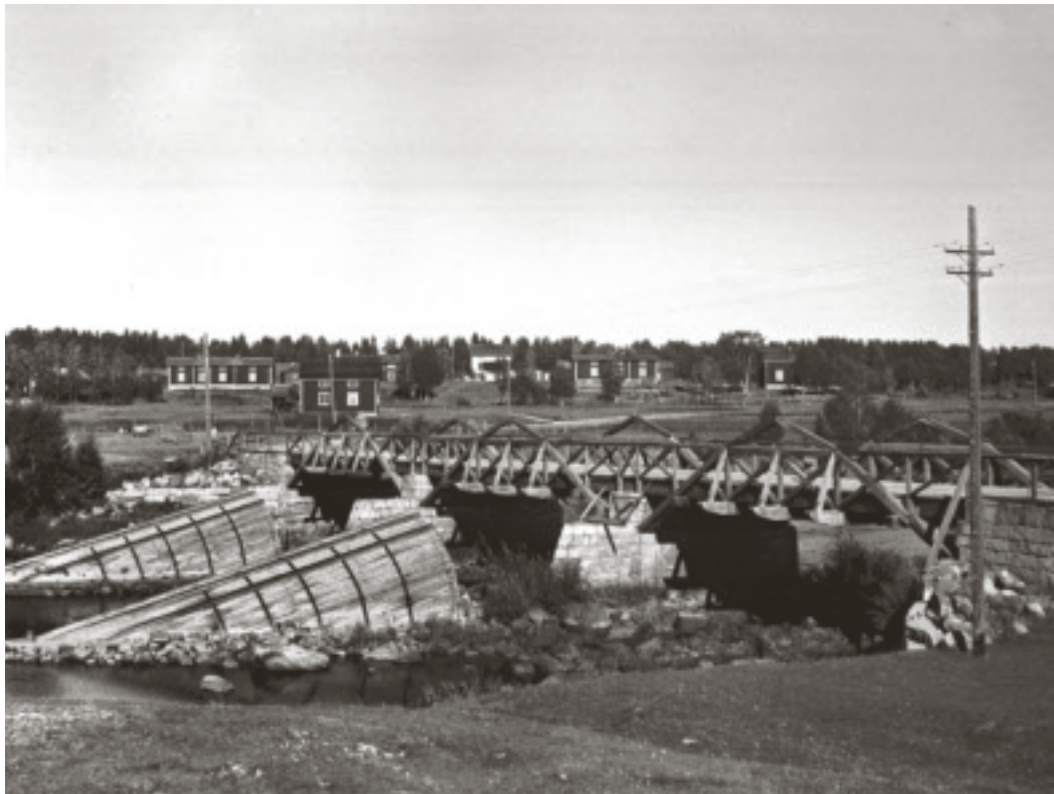
Norra bron i Sangis var ursprungligen en hängverksbro av trä. Notera de kraftfulla isbrytarna av trä. Foto 1939, Norrbottens museum.
