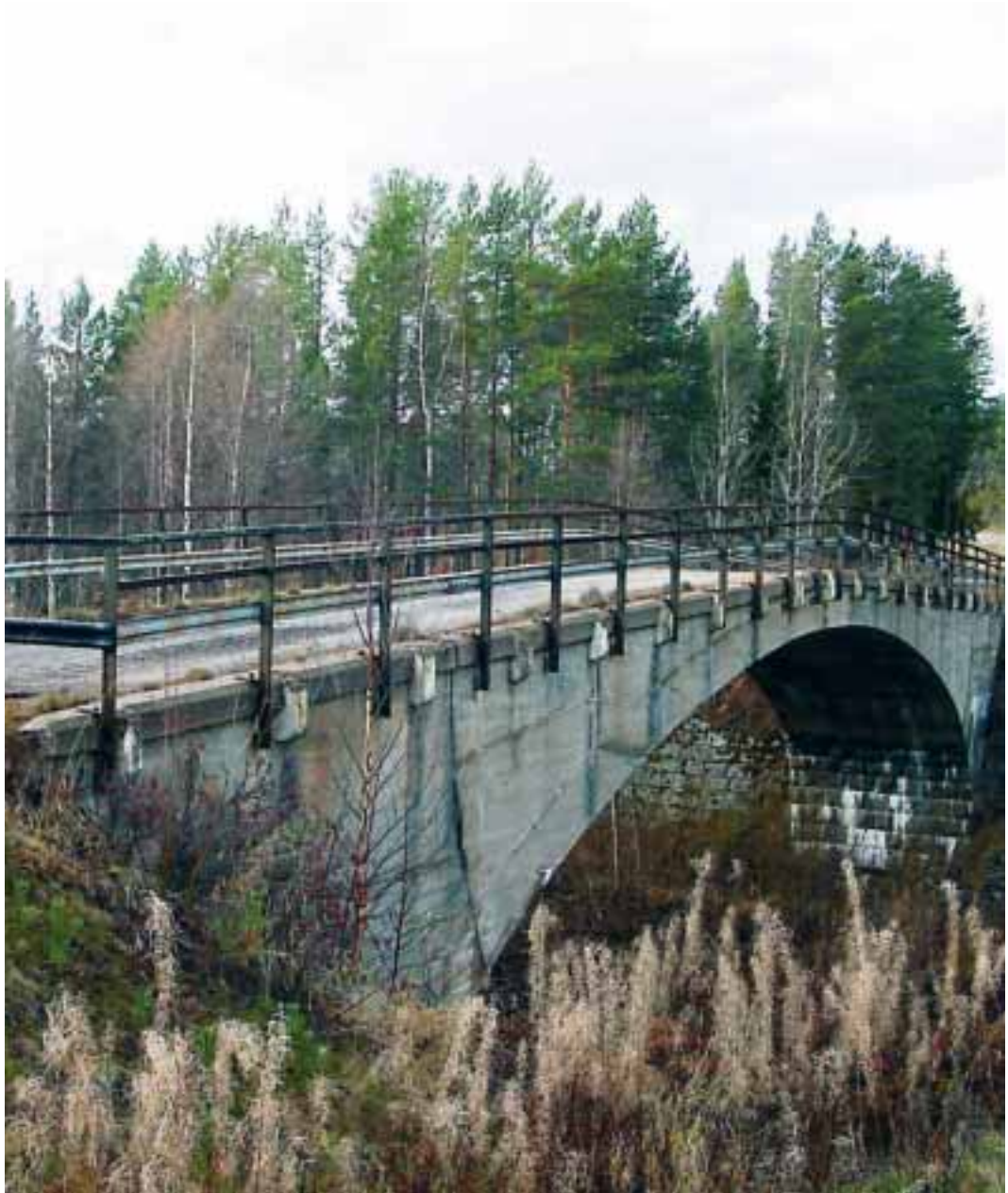
Stråkanbron från 1915 är länets första vägbro byggd av armerad betong. Bron ritades av Otto Linton, då chef för Järnvägsstyrelsens brobyggnadsavdelning.
