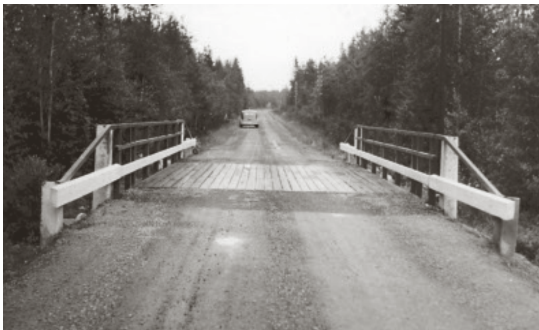
Gröna vinkeljärnsräcken med vitmålad navföljare av U-balk och korta vägräcken av vitmålad träplank på betongståndare. Höga betongståndare vid vägräckets anslutning till broräcket. Karaktäristisk utformning från 1930-talet till 1950-talet. BD 1021, stålbro över Forsträskbäcken på väg 761 i Niemisel, efter upprustning år 1950. Foto 1950, Vägverket Region Norr.
