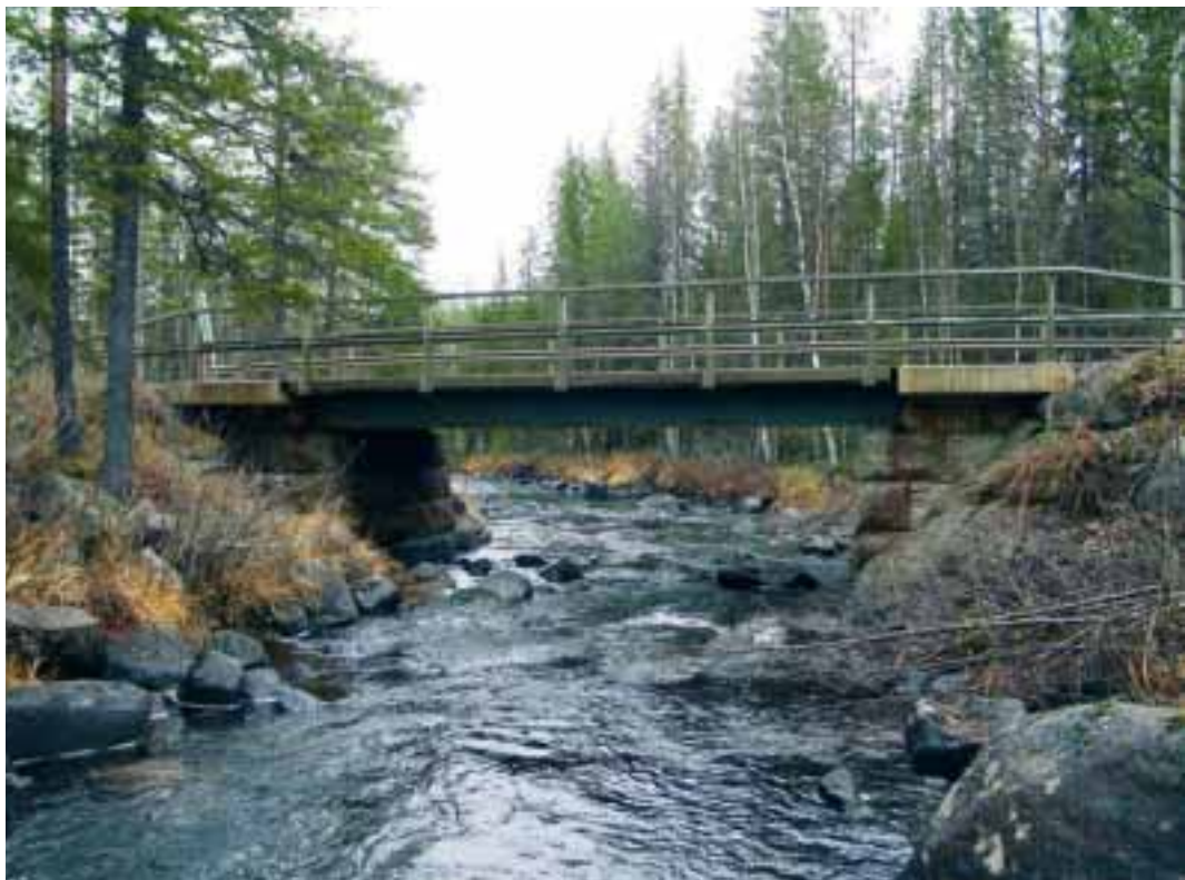
Stålbalkbron BD 795, byggd 1920, är endast 3,5 meter bred. Den kommer snart att ersättas av en dubbelt så bred plattambro.
