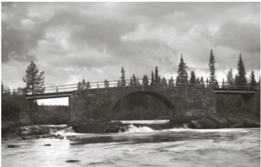
Stenvalvbron över Vassara älv före ombyggnaden 1935. Foto Norrbottens museum, Lea Wikströms samling.
