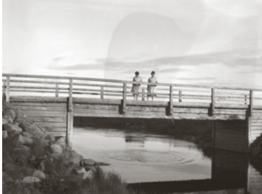
Träbro med träbalkar på timrade kistor. Hjältbron över Alån i Alvik. Äldre foto, Norrbottens museum.
