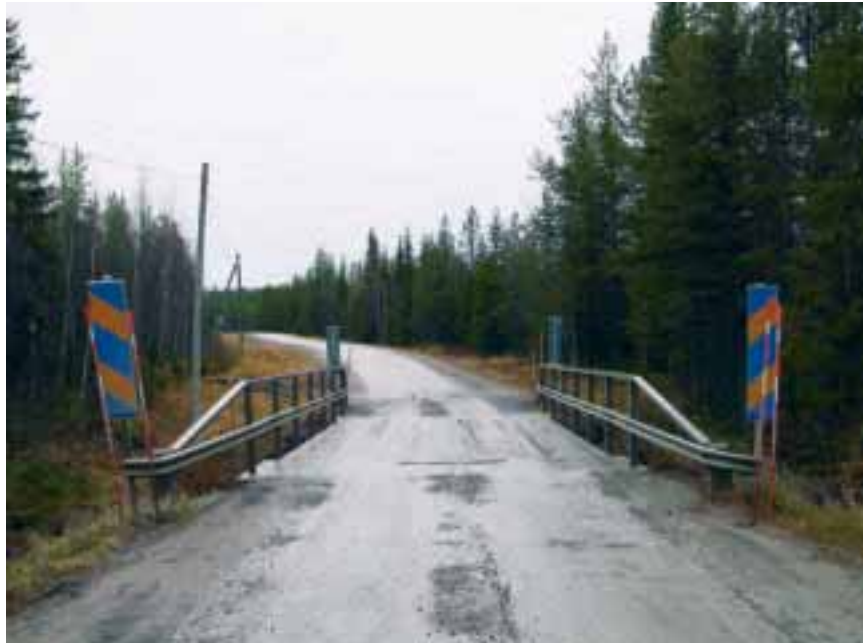
Väg 740 mellan Vuollerim och Puottaure byggdes i början av 1920-talet. Vid bron över Lagnäsån har vägen fortfarande en bevarad äldre karaktär. Den tunga timmerbiltrafiken i området tillsammans med dagens trafiksäkerhetskrav gör att vägen måste byggas om.
