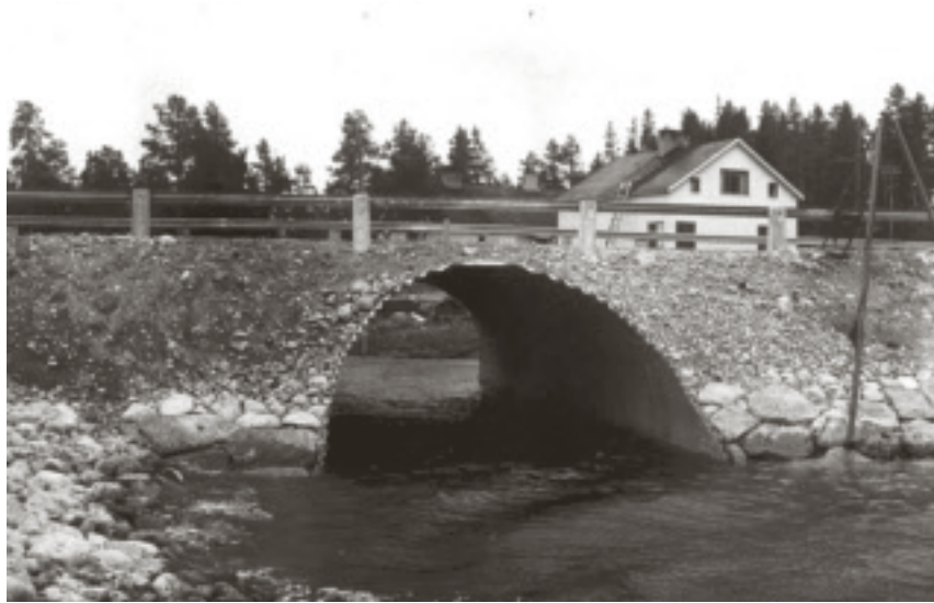
Plåttrumman BD 79 över Asptjärns utlopp vid Avaviken på väg 45 byggdes 1957. Den representerar de många vägtrumorna som byggts i länet sedan 1950-talet. Foto 1957, Vägverket Region Norr.
