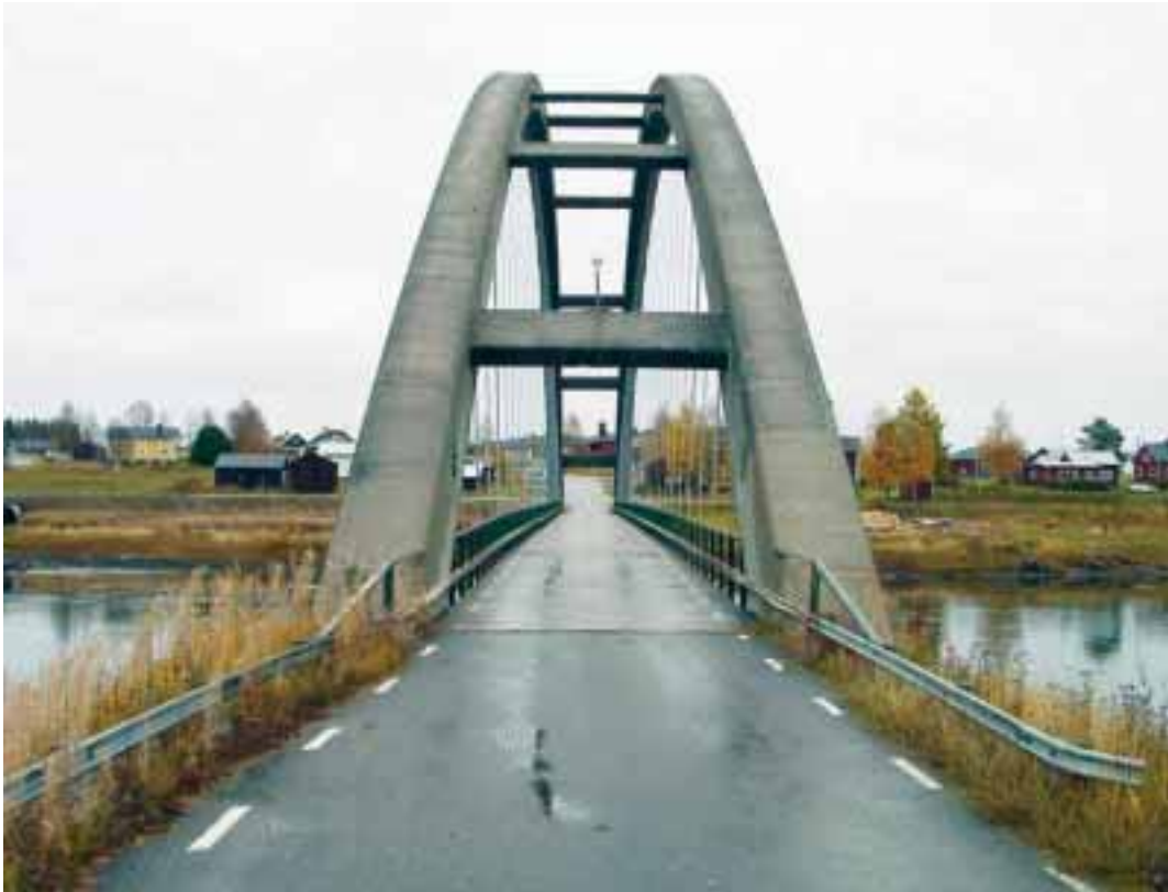
Betongbågbron över Kalixälven vid Tarendö, byggd redan 1935, är en av länets ståtligaste bågbroar.
