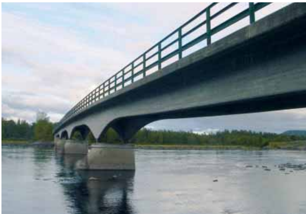
Balkbron över Vatjenavströmmen, byggd 1942, är en av länets stilrenaste betongbroar.
