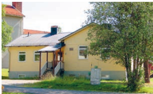
I tvättstugan kunde familjerna lämna in smutskläder för tvättning eller tvätta själva. Byggnaden har slammade tegelväggar och tidstypiska fönster och dörrar.
