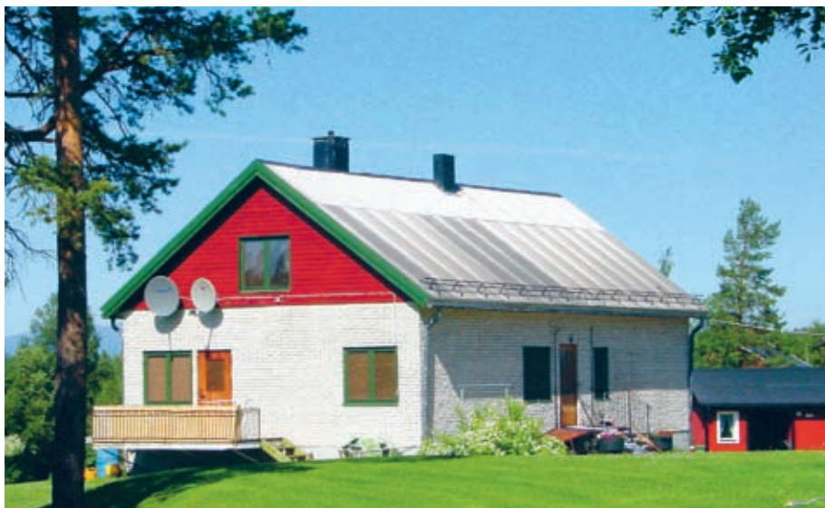
Villan med fasader av skarjeplogssten. Materialet var ett lokalt producerat mexitegel framställt som ett försök att förädla restprodukterna från gruvbrytningen.
