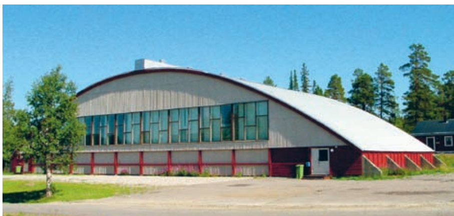
Sporthallens konstruktion består av tre bågformiga takstolar i limträ och monteringsfärdiga gavelväggar med ett stort fönsterparti.
