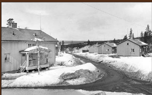
Peljevägen 1952, ett fyrfamiljshus från Laver på gatans vänstra sida, tvåfamiljshus på högra sidan.
