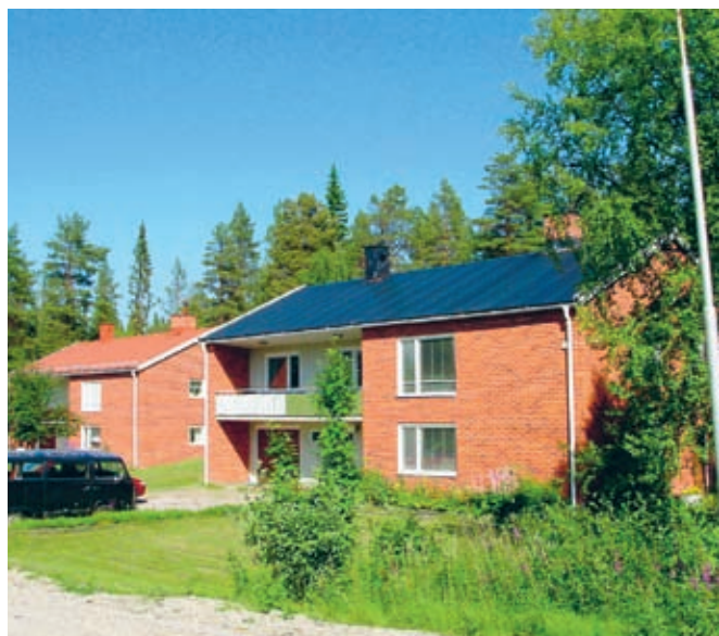
Tjänstemannabostäderna 2003, huset närmast i bild har några år tidigare fått ett svart plåttak.
