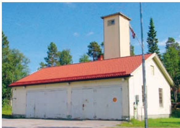
Trots att det var länge sedan brandstationen stängdes har byggnaden bevarat sin ursprungliga utformning med putsade betonghålstensväggar, småspröjsade enlufts-fönster och enkla stålportar. Slangtornet har trästomme och ribbpanelade väggar.
