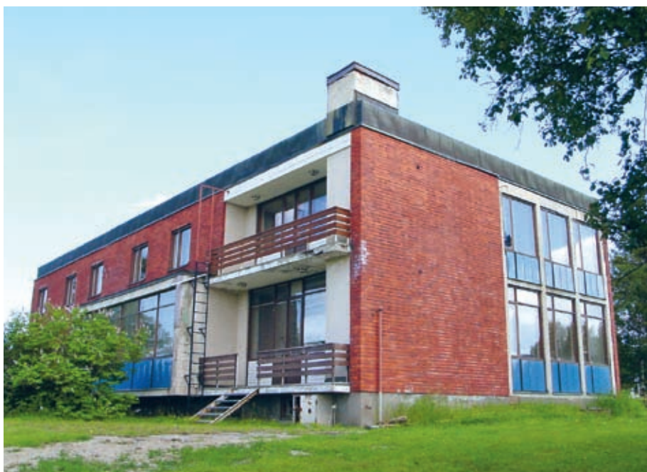
Bolagshotellet från nordväst 2003. Husets konstruktion består av bärande gavelväggar av betong med mineralullsisolering och fasadtegel, utfackningsväggar av lättbetongblock, isolering och fasadtegel. Bröstningarna under de stora fönstren är klädda med brännlackerade plåtpaneler.
