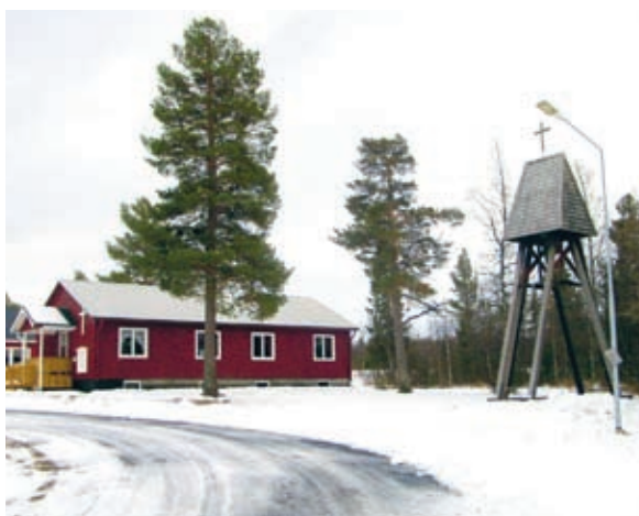
Kapellet är en enkel byggnad med fasader av rödfärgad locklistpanel och vita snickerier. Endast det vita korset vid ingången och klockstapeln markerar byggnadens kyrkliga status i det yttre.
