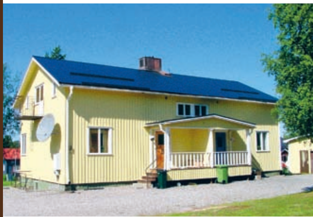
Nedre bilden: Ett välbevarat fyrfamiljshus, numera tvåfamiljshus på Nadokvägen 2003.
