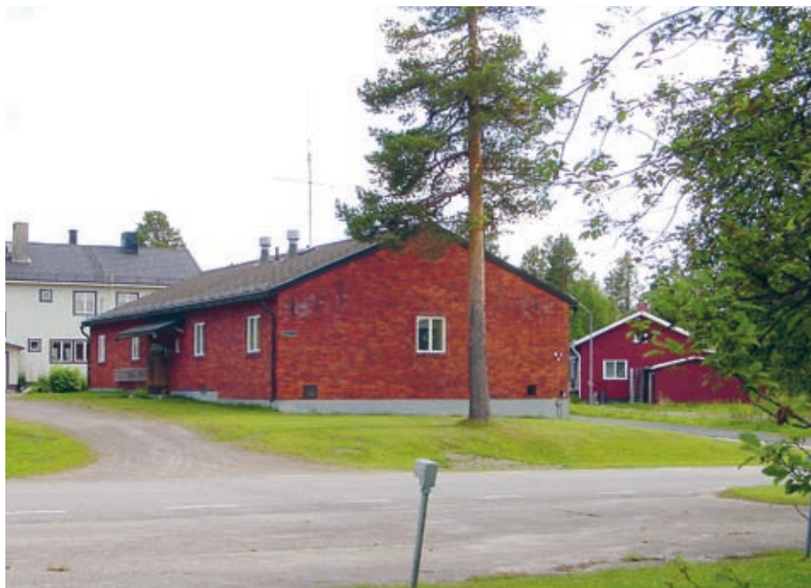
Annex II – byggt på samma plats som det första gruvhotellet - har samma typ av konstruktion som hotellet, med lättbetong, isolering och fasadtegel.
