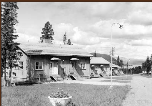
Twåfamiljshus på Nadokvägen. Äldre foto.
