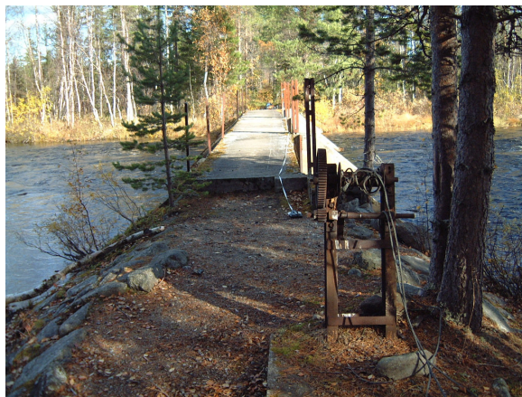
Tårrajauredammens vinsch som reglerade bjälksättarna.
