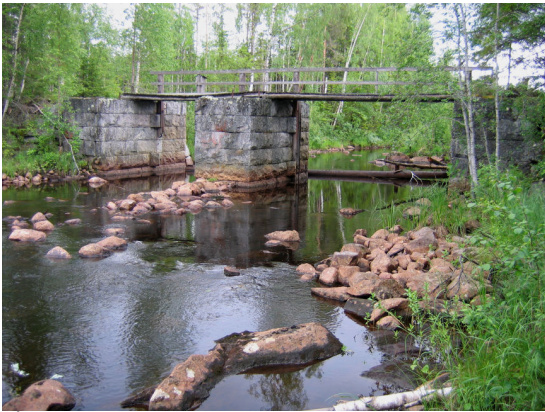
Åträskdammen i Rokån har utskov av kilad sten. Fungerar idag som överfart.
