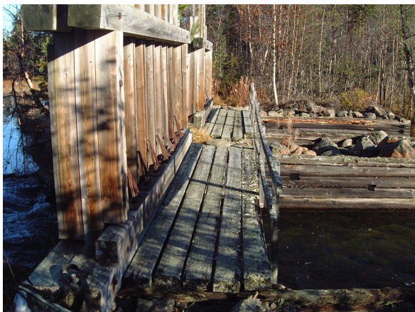
Nårvedammens välbevarade luckstolpar och timmerkistor.
