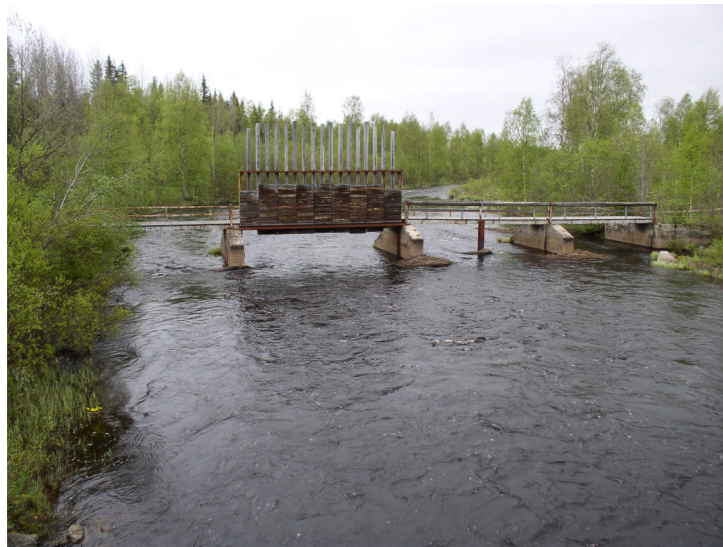
Armasjärvidammen är en av få bevarade dammar i Torneälven.
