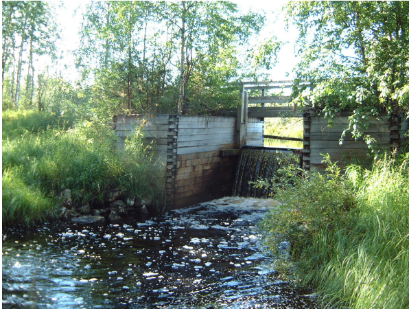
Pempelijokidammen är, med sitt timrade utskov och bjälksättar, en av två i sitt slag i länet.
