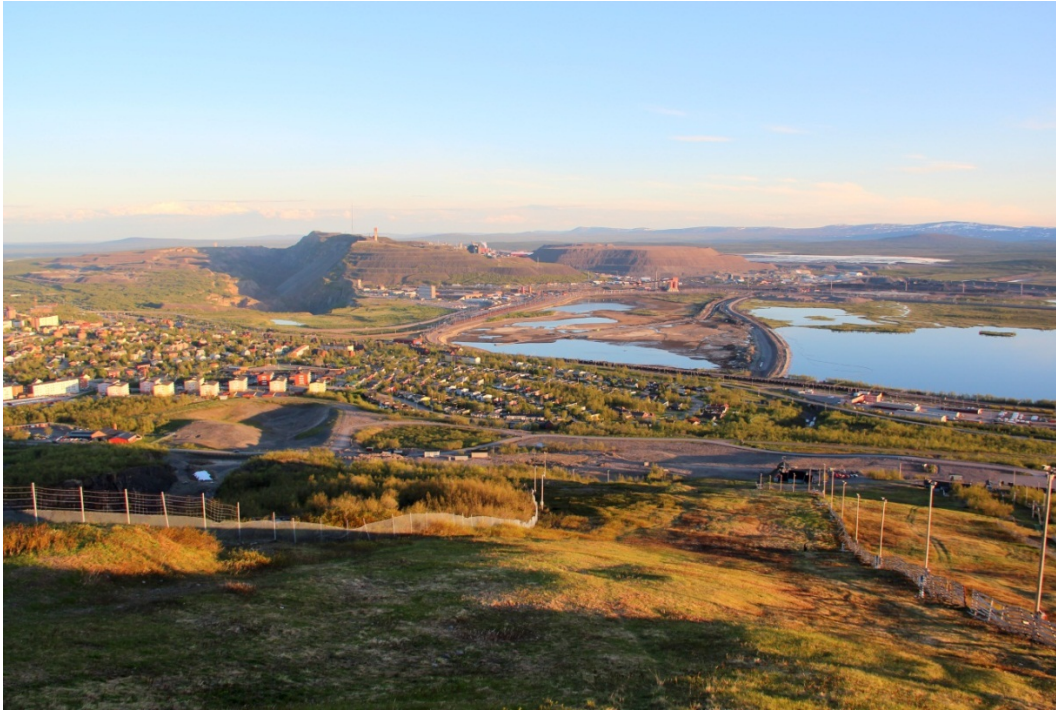
Figur 6. Tömning av del av Norra Luossajärvi i Kiruna på grund av gruvverksamhet. Sjön är belägen inom Torne älvs avrinningsområde.
