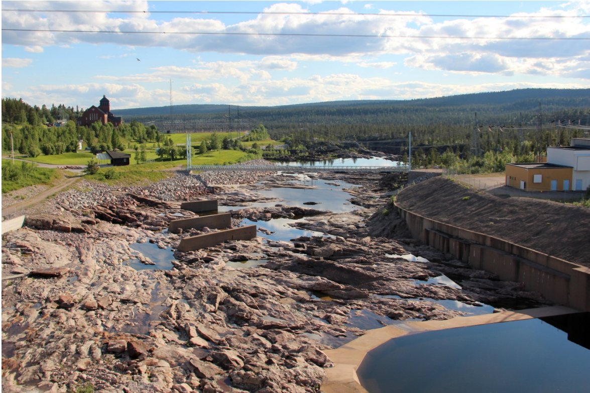
Figur 2. Lule älv vid Porjus kraftstation.
