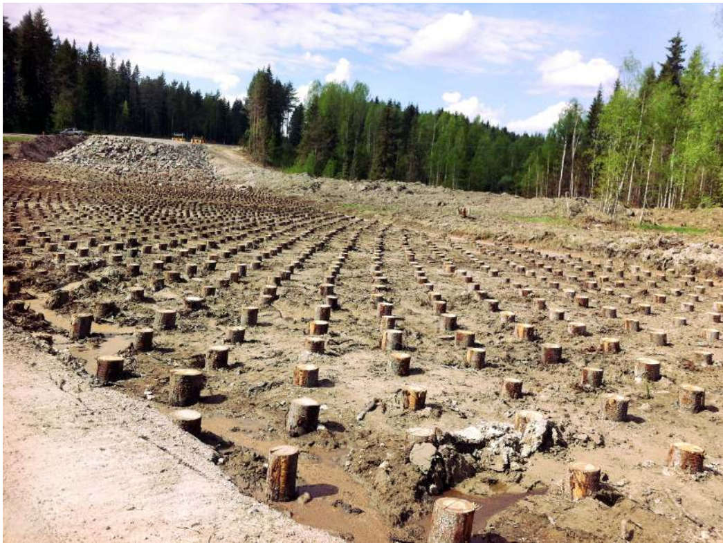
Figur 10. Exempel på direkt miljöåtgärd i form av att förebygga att faktiskt sur sulfatjord bildas: En instabil mark vid ett vägbygge består i detta fall av potentiellt sur sulfatjord som fått ligga kvar istället för att schaktas bort, samtidigt som stabilisering har skett med pålar. Hela träd användes som pålar, eftersom stål och betong riskerar att frätas sönder i det översta faktiskt sura skiktet. Den potentiellt sura skiktet hade i detta fall en mäktighet på upp till 16 meter. Bilden är tagen mellan Smedsbyn-Boden i Norrbotten år 2013, strax väster om Persöfjärden. Foto: Sara Elfvendahl.
