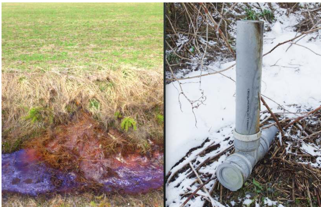
Figur 12. Enkel reglerbar dränering med vinklade stigarrör i utloppet av täckdiken (bild till höger). Vid höga flöden vinklas rören horisontellt så att dräneringen blir effektiv, medan rören fälls upp vid låga flöden. Syftet är att behålla vatten i täckdiketsröret och på sått minska risken för att täckdiket sätts igen med fällningar (vilket skett i bilden till vänster). Observera att denna metod inte fungerar för att minska urlakning av svavelsyra från tunga självsprickande jordar, men att den eventuellt skulle kunna fungera på de finkorniga jordar som inte självspricker (se vidare resonemang i texten). Foto: Jan Åberg
