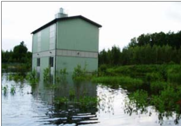
Figur 9 Översvämning vid vattenverk, Småland 2004. (Foto: Erik Winnfors)
