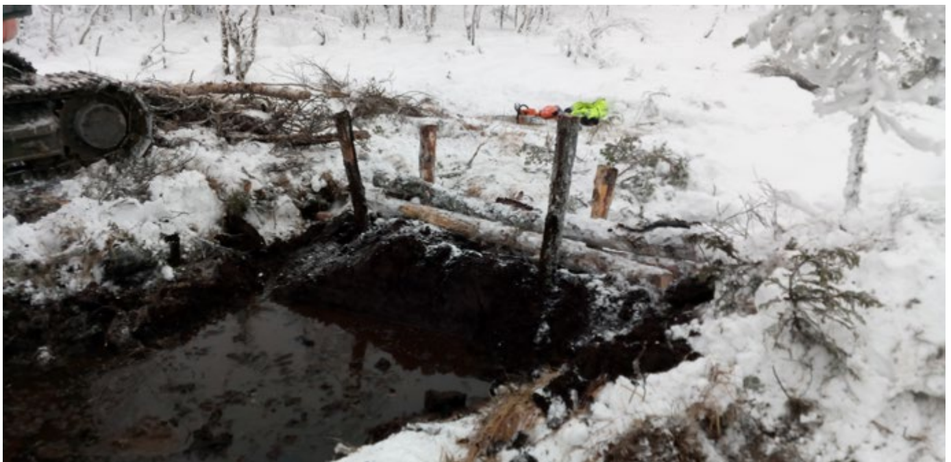
En dikesplugg byggd av liggande stockar och torv.
