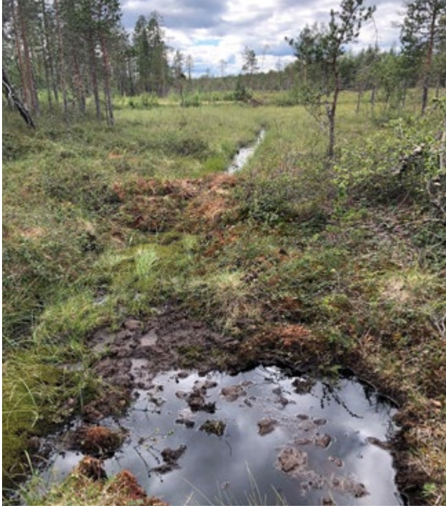
Dikesplugg där torv är lagt ovanpå för att tätta pluggen.
