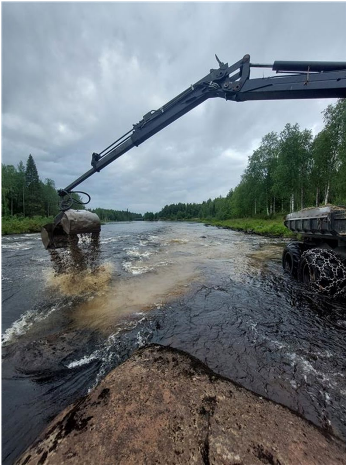
Figur 58. En skogstraktor lägger ut lekgrus i Viikaköngäs strömmande vattenpartier. Foto: Antero Mölläri, Forststyrelsen.
