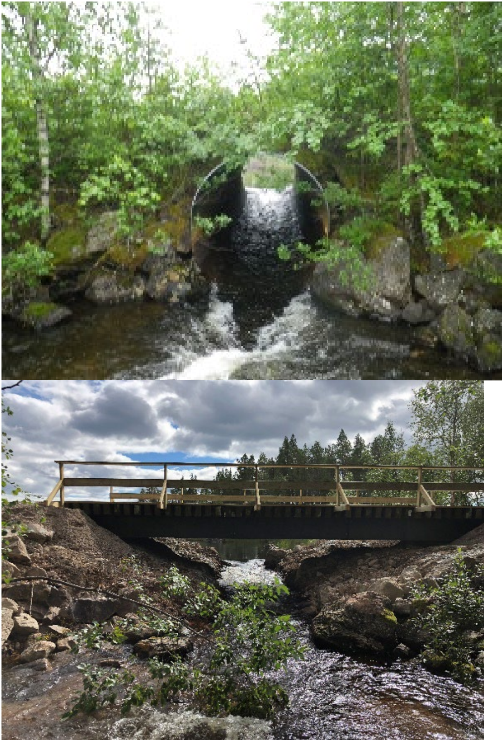
Figur 13. Foton tagna före respektive efter åtgärd, objekt 4. Den gamla vägtrumman hade smalnat av vattendragets naturliga bred betydligt. Efter åtgärd är nu vattendraget bredare. Foto: Länsstyrelsen Norrbotten.
