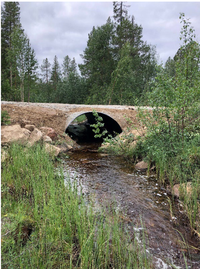
Figur 14. Foton tagna före respektive efter åtgärd, objekt 5. Den gamla vägtrumman var smal och bottenstrat saknades och inga viloplats för fisk fanns. Efter åtgärd har vattendraget blivit bredare. Inne i valvbron finns nu förekomst av bottenstrat, däribland större stenar. Foto: Länsstyrelsen Norrbotten.
