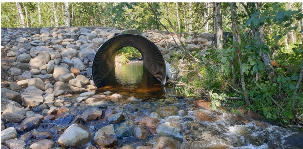
Figur 64. Fotot visar Sihtunajoki efter åtgärd. Stenar placerades ut nedströms för att skapa ett strömparti och med syfte att sakta ned vattenhastigheten. Foto: Timo Lettijeff, Lapplands NTM-central.
