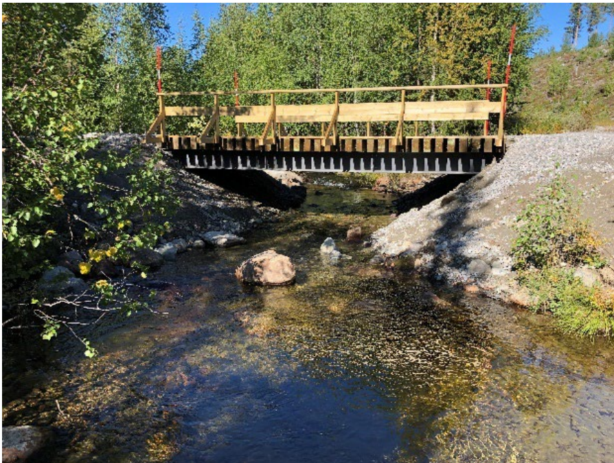
Figur 10. Foton tagna före respektive efter åtgärd, objekt 1. Två vägtrummor som är för högt placerade skapar ett för högt fall vid utloppet. Inne i vägtrumman saknas och bottenstrukt. De långa vägtrummorna har ersatts av en balkbro så att vattnet kan återfå sin naturliga bredd och nu finns också förekomst av bottenstrukt av varierande kornstorlekar. Foto: Länsstyrelsen Norrbotten.
