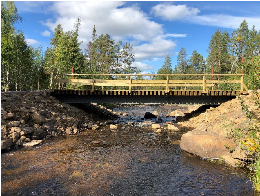
Figur 15. Foton tagna före respektive efter åtgärd, objekt 6. Den gamla vägtrumman var så smal att vattenhastigheten ökade betydligt. Efter åtgärd har vattenhastigheten minskat, vattendraget har återfått sin bredd och under bron finns nu bottensubstrat av olika storlekar. Foto: Länsstyrelsen Norrbotten.
