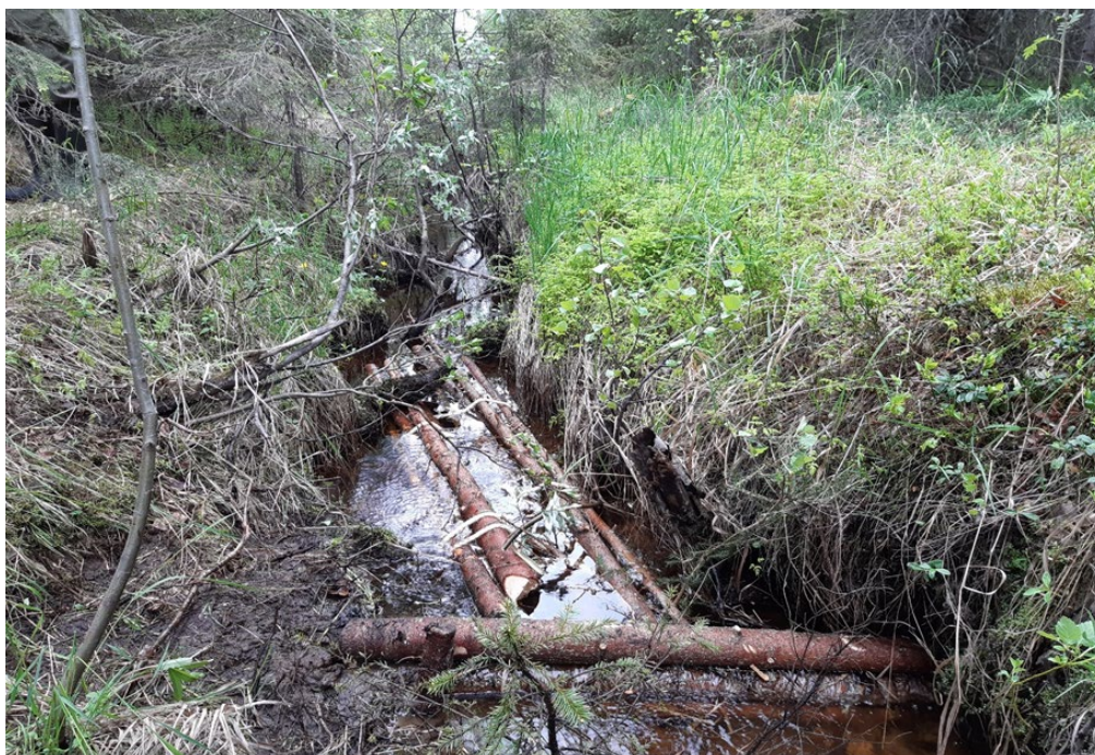
Figur 62. Virkesbuntar placerades alltid så djupt ned att de alltid skulle ligga mer eller mindre under vattenytan. Foto: Reeta-Maria Peteri, Lapplands NTM-central.
