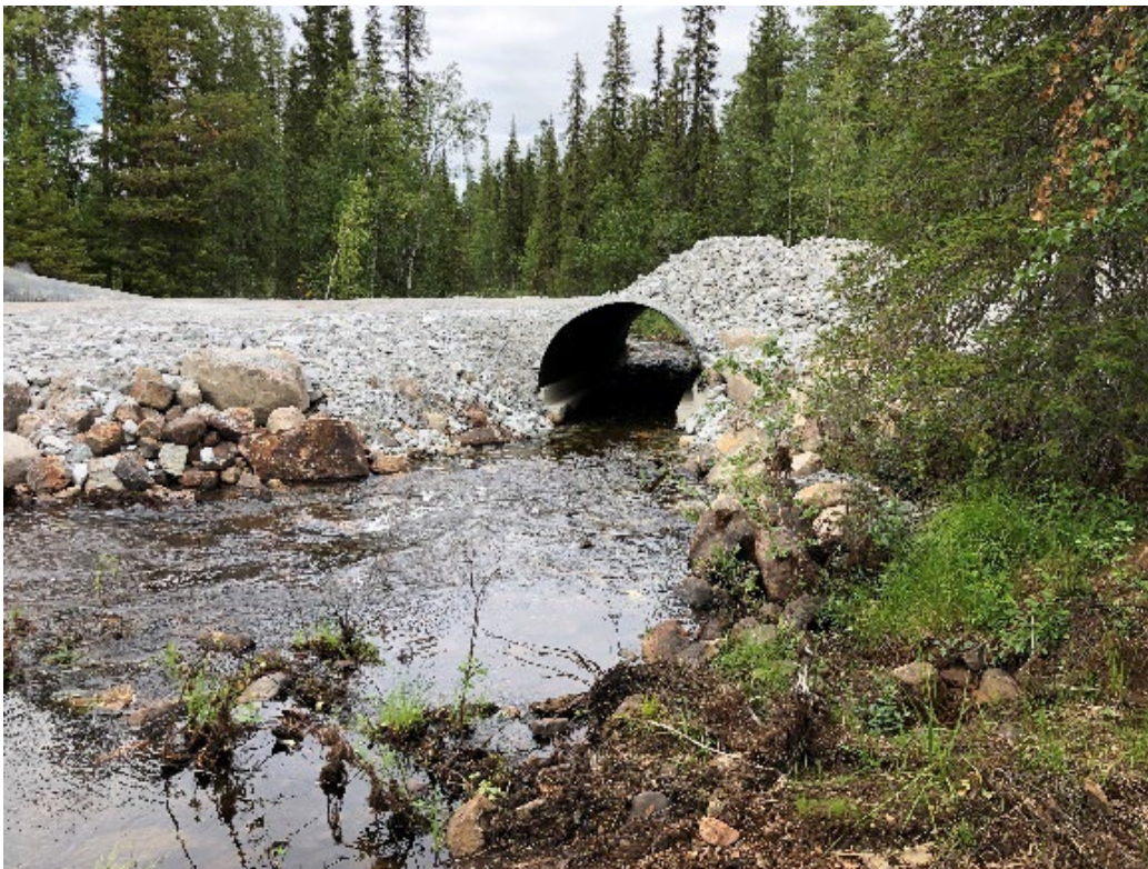
Figur 11. Foton tagna före respektive efter åtgärd, objekt 2. En sidokanal till Pärlälven har öppnats upp efter att den varit igenstängd vid inloppet. Det ökade vattenflödet krävde en bredare bro som är anpassade för höga vattenflöden och för att ta bort trösklar vid trummans inlopp. Foto: Länsstyrelsen Norrbotten.
