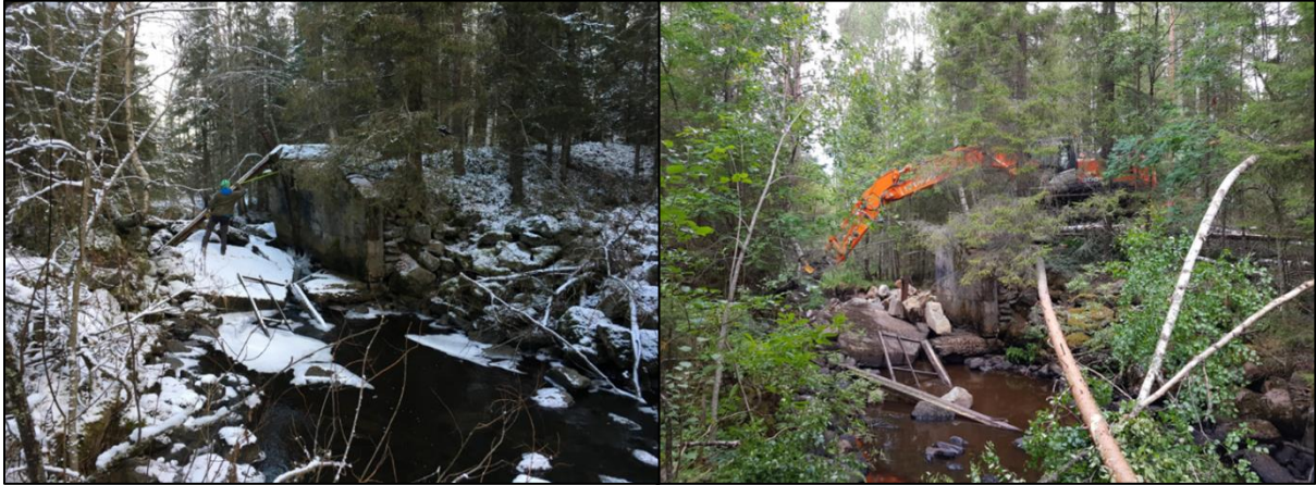
Kuva 4.6. Rosånin Baronseldammen ennen toimenpiteitä. Betoni ja metallirakenteet poistettiin virrasta ja molemmilta rannoilta.
