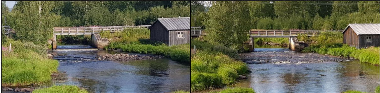
Kuva 4.16. Alån ja Alen mylly erittäin alhaisen veden aikana. Ennen toimenpidettä vasemmalla ja toimenpiteen jälkeen oikealla.
