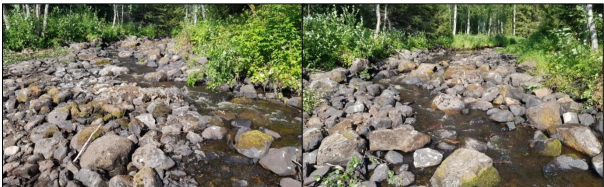
Kuva 4.10. Vasemmanpuolinen kuva esittää patoportaan keskiosaa toimenpiteiden jälkeen ja oikeanpuoleinen muokkausalueen yläosaa. Muokkauspäivänä veden virtaus oli erittäin pieni, noin 5 l/s.
