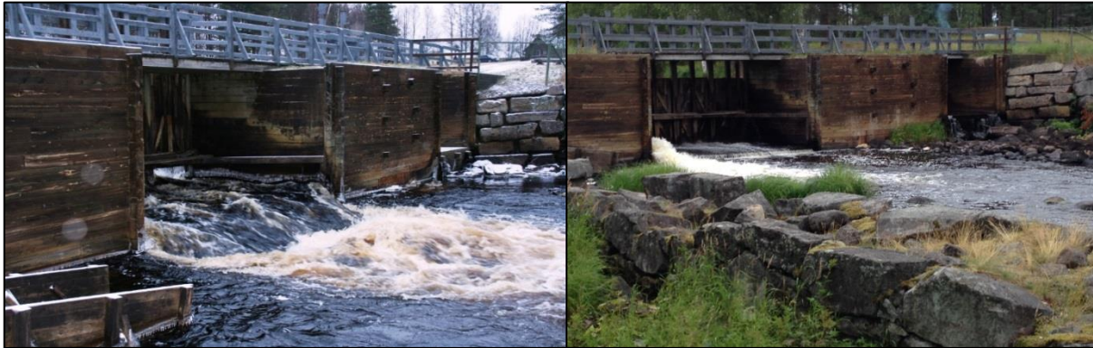
Kuva 4.20. Patorakennelma Selets brukin alueella Alånissa. Kuvassa vasemmalla luukut ovat auki ja kuvassa oikealla luukut ovat kiinni.
