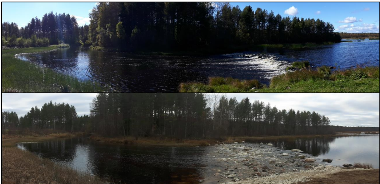
Kuva 4.3. . Alterälvenin Porsnäsdammen ennen ja jälkeen kunnostuksen 2016.
