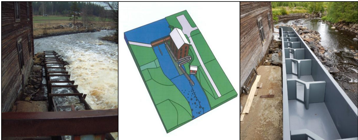
Kuva 4.4. Vanha kalatie on vasemmalla ja uusi oikealla, valmistettu vuonna 2018 kokonaan komposiitista.
