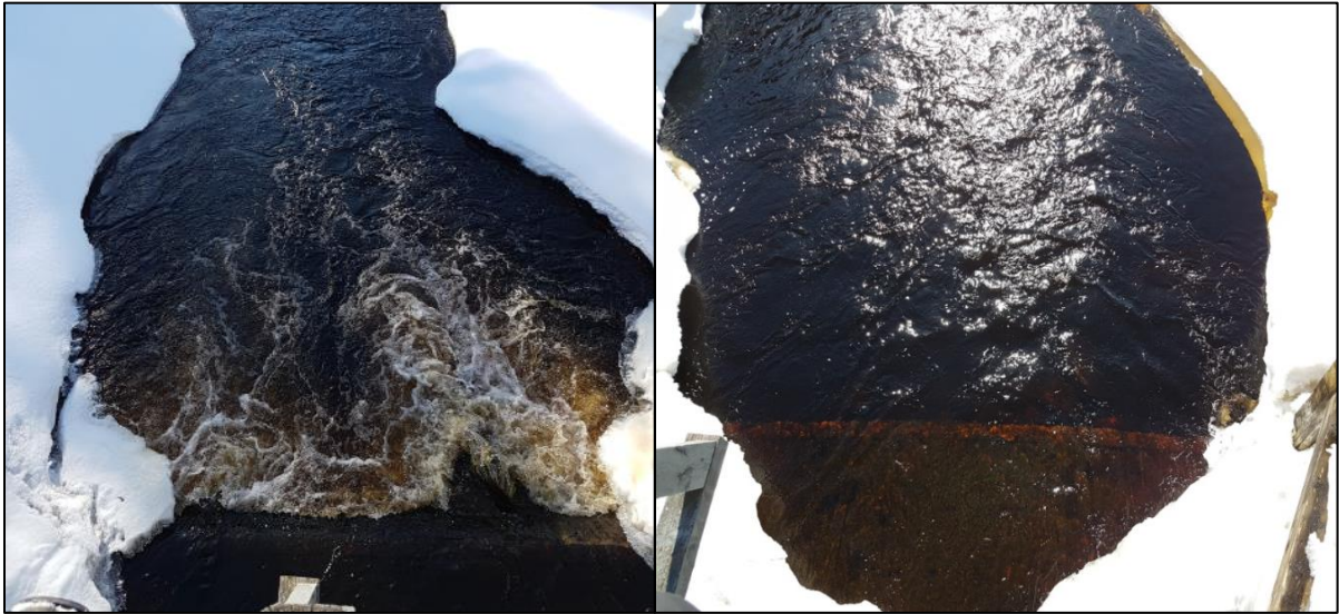
Kuva 4.24. Kuvassa vasemmalla tilanne ennen toimenpidettä ja oikealla toimenpiteen jälkeen Alånin Selets Brukin alueella. Toimenpiteen jälkeen vedenpinnan taso padon alapuolella nousi niin, että kaloille syntyi vapaa vaellustie (kuva oikealla).
