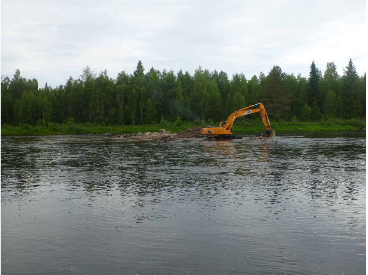
Kuva 5. Kiviaineksen seulontaa suisteen purun yhteydessä Maitokallionvirralla.
