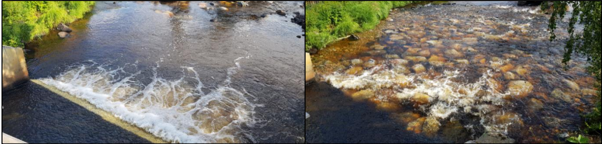
Kuva 4.18. Alen myllyn patokynnys Alånissa ennen toimenpidettä vasemmalla ja toimenpiteen jälkeen oikealla. Toimenpiteen toteuttamisen aikana vettä oli joessa hyvin vähän.
