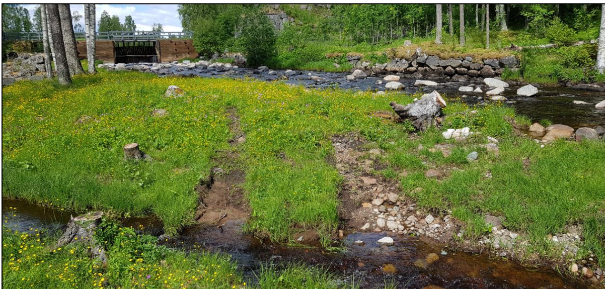
Kuva 4.25. Kaivinkoneen ja dumperin kulkureitti Selets Brukin alueella näkyy hyvin vähän maaperässä huhtikuussa 2018 toteutettujen toimenpiteiden jälkeen.
