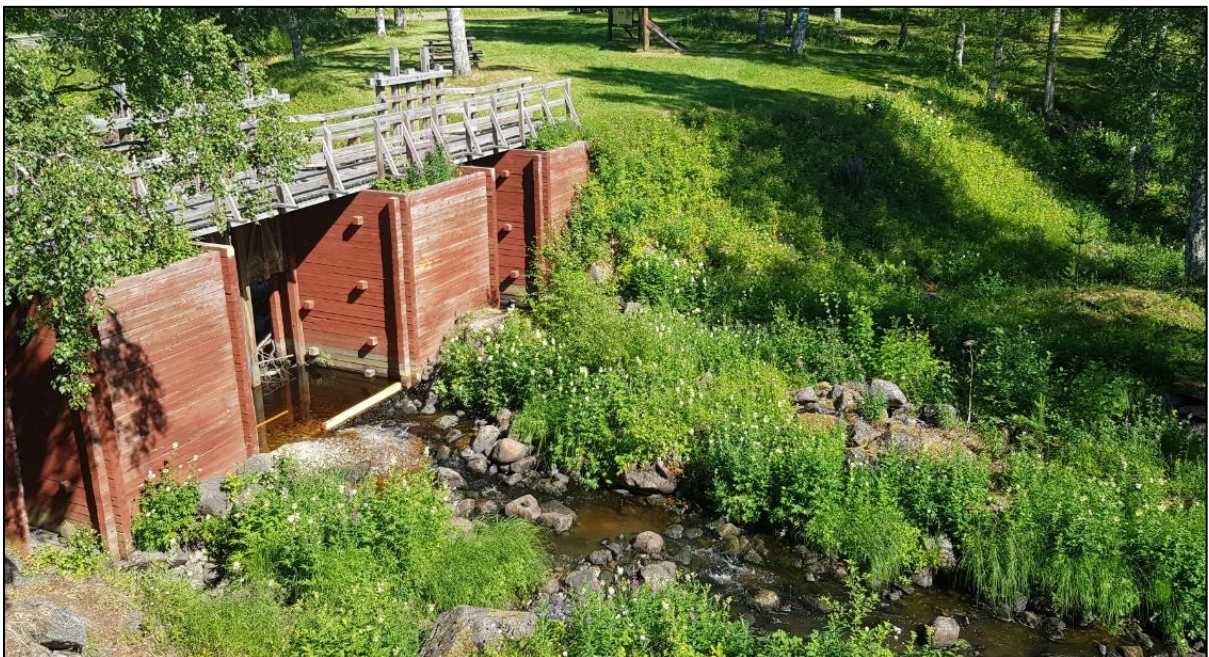
Kuva 4.13. Rosån-joen Rosforsin pato toimenpiteiden jälkeen. Erittäin pieni virtaus Rosånissa.
