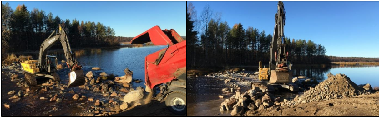
Kuva 4.2. Materiaalin kuljetus ja kivien levitys kaivinkoneella.
