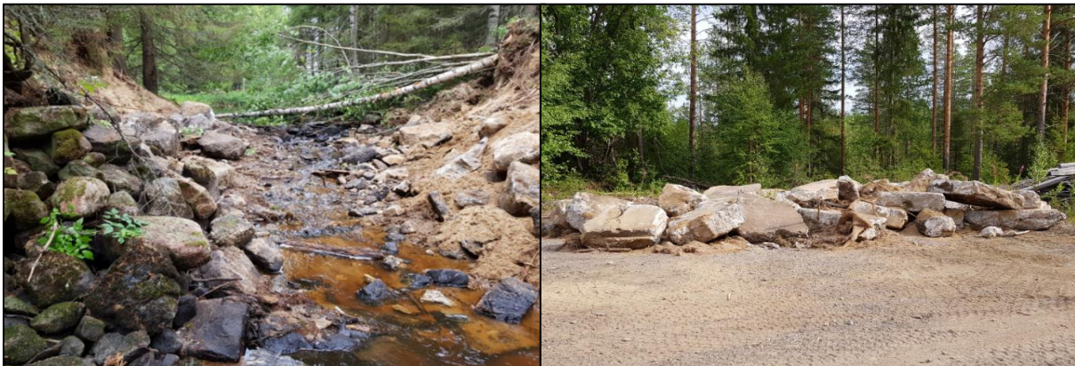
Kuva 4.7. Rosånin Baronseldammen toimenpiteiden jälkeen ja muokattu uoma kalojen vaellusta varten. Oikealla betonimateriaalia, joka kuljetettiin kaatopaikalle. Toimenpiteiden aikaan veden virtaus oli erittäin pieni (noin 3 litraa sekunnissa).
