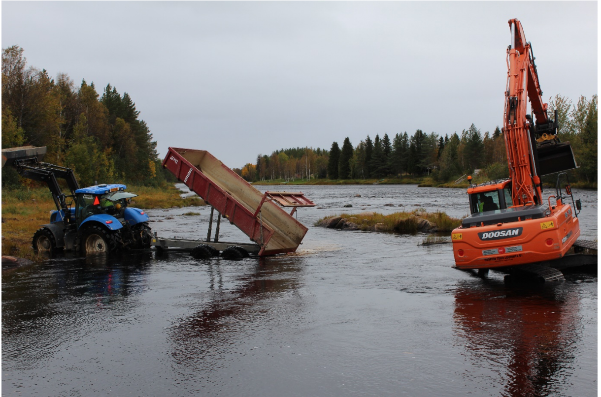
Kuva 3. Kutualueen kunnostusta Kalmakoskella 2016
