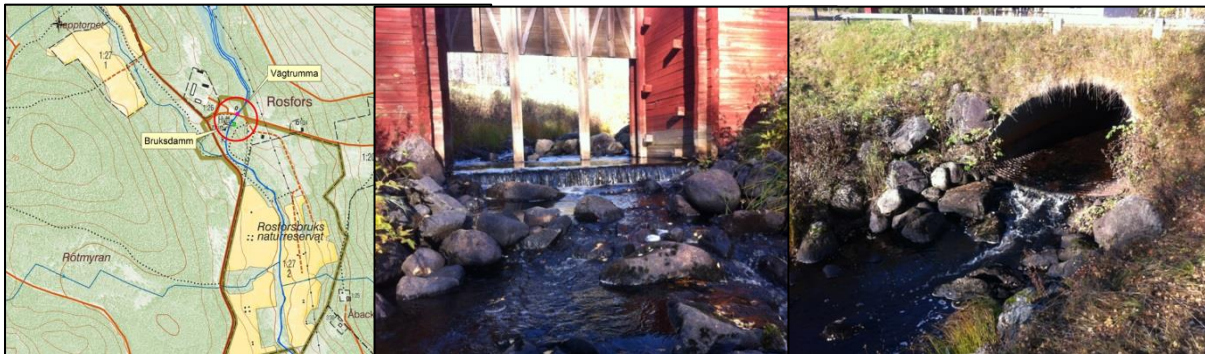
Kuva 4.11. Kartta Rosforsin ruukista ja ruukkipadosta sekä tierummusta, jotka muodostivat vaellusesteen Rosånin vesistössä matalalla vedellä.
