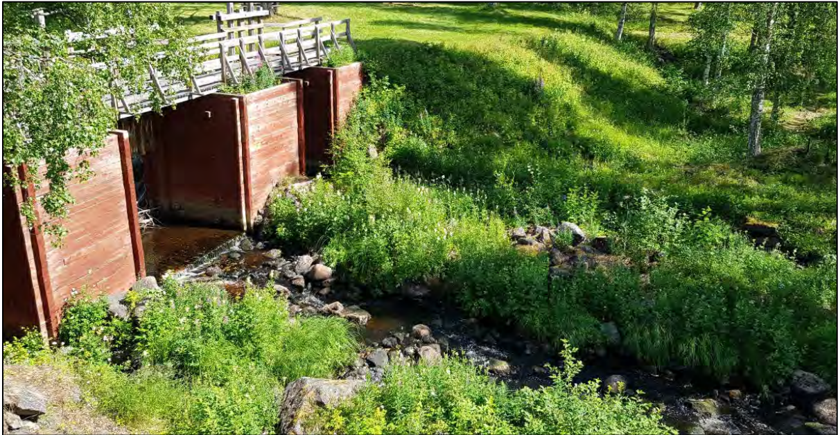
Figure 4.12. Dammen i Rosfors, Rosån innan åtgärd. Extremt låg vattenföring i Rosån.
