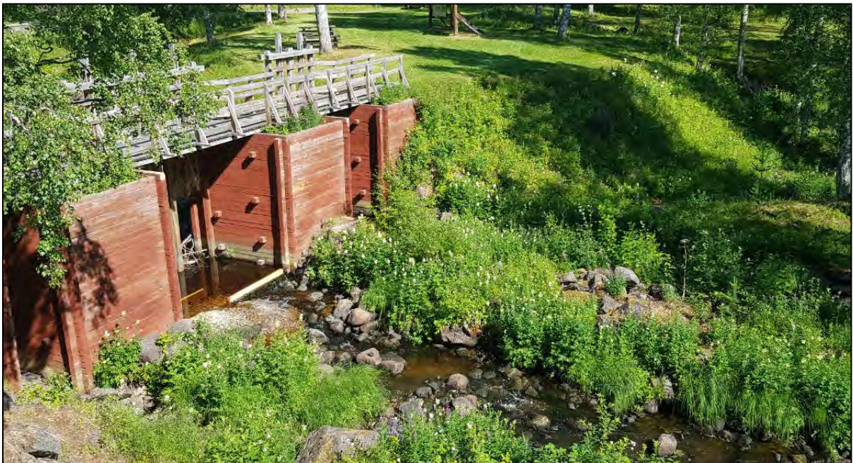
Figure 4.13. Dammen i Rosfors, Rosån efter åtgärd. Extremt låg vattenföring i Rosån.
