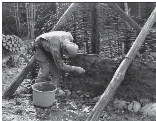
Fig. 3. Vår Forntidsby utanför Katrineholm byggdes av Föreningen Vråfolket på 1980- och 1990-talen intill stenåldersboplatsen vid Östra Vrå, som delundersöktes på 1930- och 1990-talen. På bilden lerklins den risflätade väggen på ett av husen. I föreningens regi har många skolklasser fått uppleva att leva stenåldersliv på platsen. Foto Saskia Enckell 1991, ATA. Återges med tillstånd av Föreningen Vråfolket, Forssjö.
