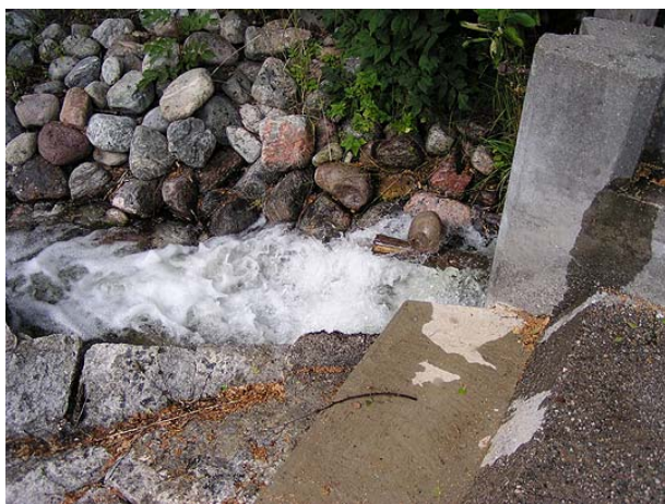
Figur. 31. Regleringsluckan i dammvallen öppnades på prov den 17 aug. 2004 i syfte att testa möjligheten att skapa en passage för akvatisk fauna i vattenområdet vid Sibro. Foto: Jakob Bergengren.
