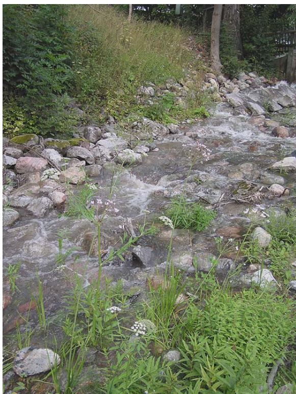
Figur 32. Möjlig ”ny bäckfåra – vandringssväg för akvatisk fauna” i den nordvästra delen av dammvallen mot Båven. Foto: Jakob Bergengren, 17 aug. 2004.
