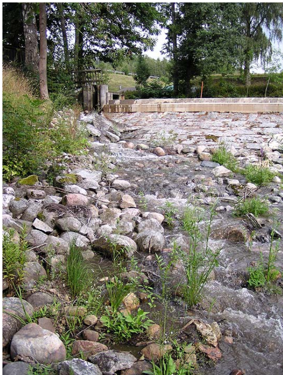
Figur 33. Försöket visade att det är möjligt att skapa en bäckfåra i området, som vandringssväg för fisk m m, mellan Båven och nedströms liggande vattendrag. Foto: Jakob Bergengren, 17 aug. 2004.
