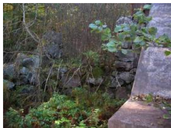
Figur 16. Detaljbild över fördämningen vid Ålberga bruk.
