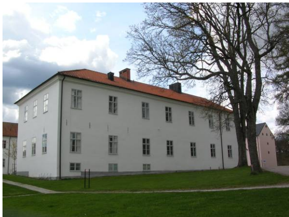
Figur 7. Fotografi på fd fabriks huset vid Gripsholmskemiska fabriker.
