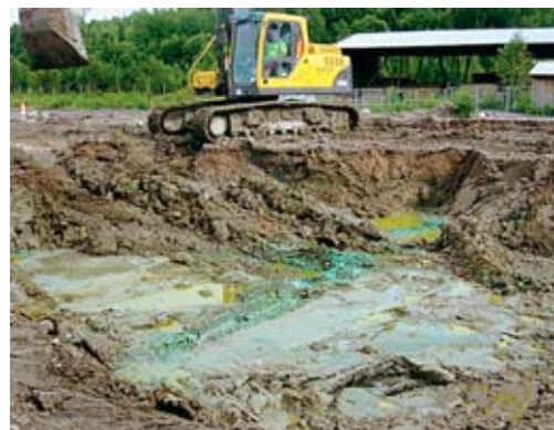
Sanering i sjösa. I marken finns höga halter av arsenik, koppar och krom.
