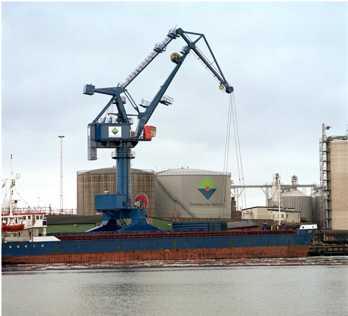
Bild 8. Ny kran i hamnen.
