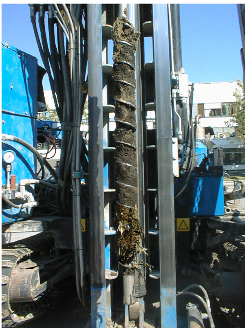
Bilaga 5. Hans Engström och Magnus Björkbäck, från Bjerking i Uppsala, skötte markborren samt provtagning av geologi- och miljöprover. Observera träresterna längst ner i skruvborren på den undre bilden. Trävirket kommer med ledning av lagrens kvalitet och djup från bryggor eller liknande konstruktioner i det medeltida hamnområdet. Foto: Björn Pettersson, Sörmlands museum.
