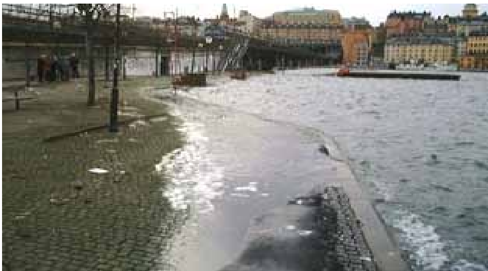
Kajen vid tunnelbanestationen i Gamla Stan, Stockholm, november 2000. Foto: Alf Axlid
