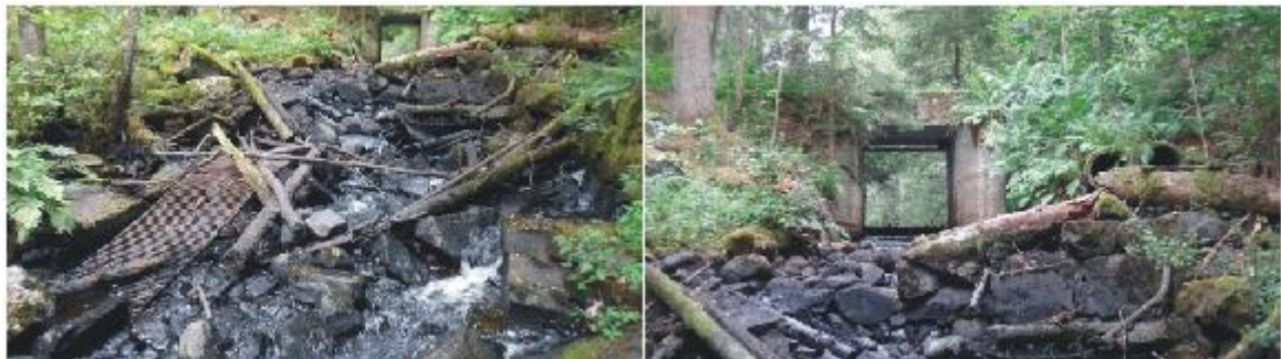
Figur 6. Sågfallet sett nedifrån. Den vänstra bilden visar att det inte bara är fördämningen under bron som utgör vandringshinder utan även äldre konstruktioner nedströms.
