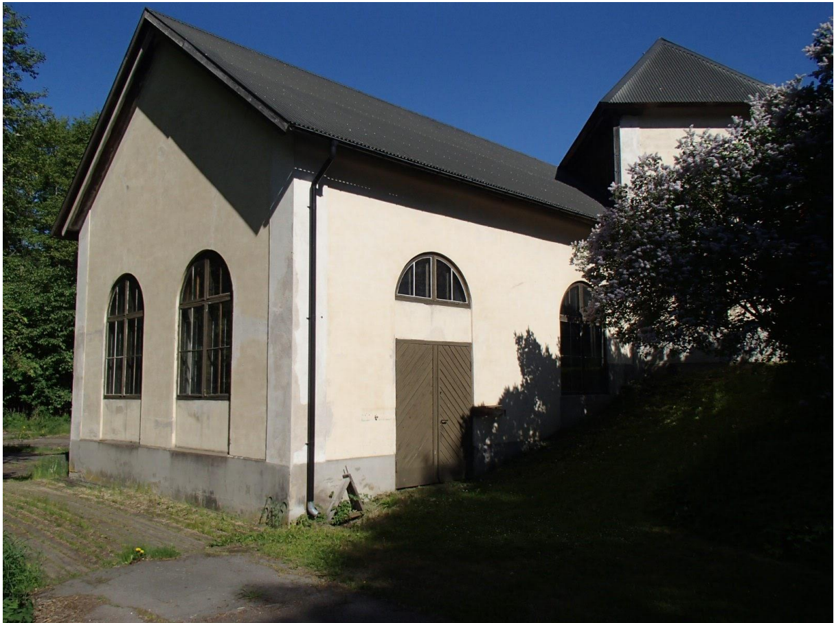
Ålberga Bruk nedre Kraftstation
