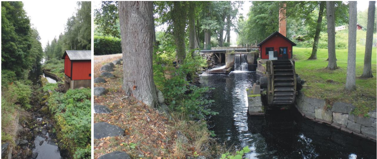
Figur 8. Till vänster nedåt vy från Virå övre kraftverksdamm med kraftstationen i den röda byggnaden. Höger foto visar Virå nedre kraftverk nedifrån.
