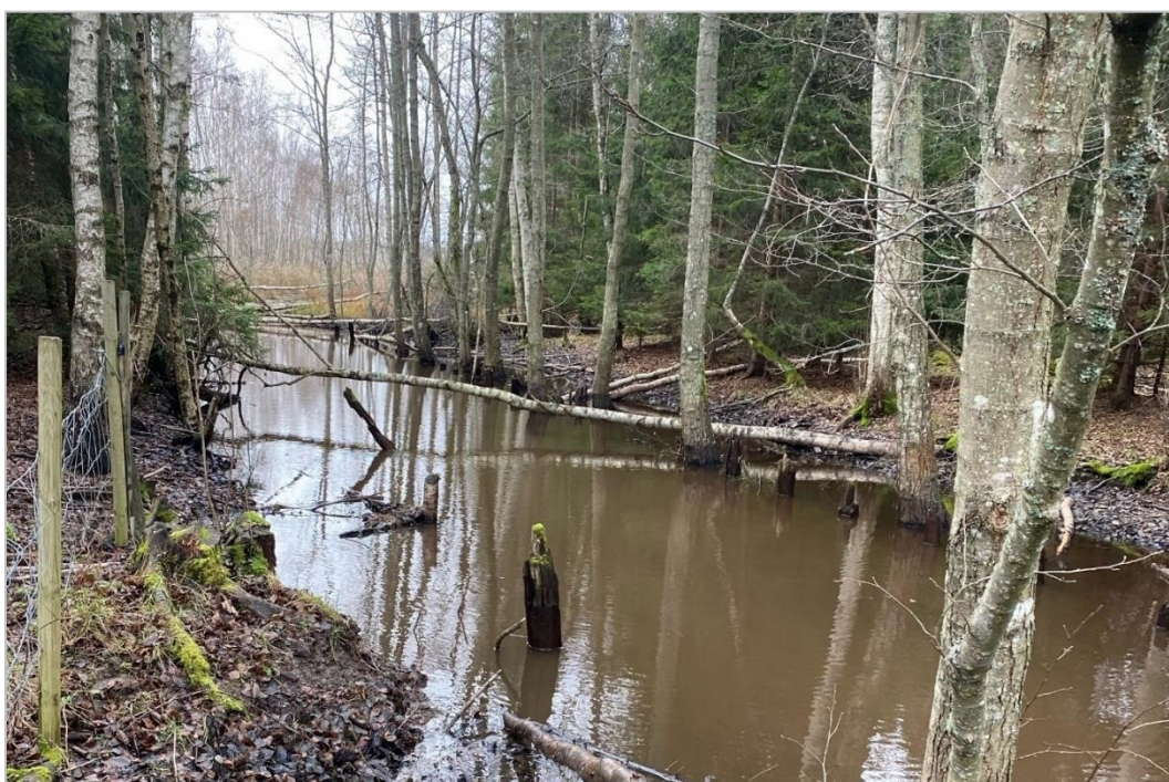
Figur 21. Befintligt utlopp vid Norra Kärrlången. I diket ses möjliga spår av tidigare åtgärder (pålar) för att stabilisera dikeskanter.
