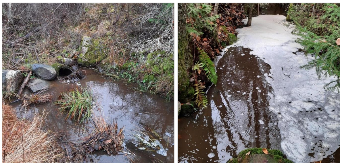
Figur 15. Befintlig kulvert vid Norra Kärrlångens utlopp. Till vänster visas kulvertens inlopp och till höger kulvertens utlopp och nedströms sektion. Foto: Structor, 2021-11-11.
