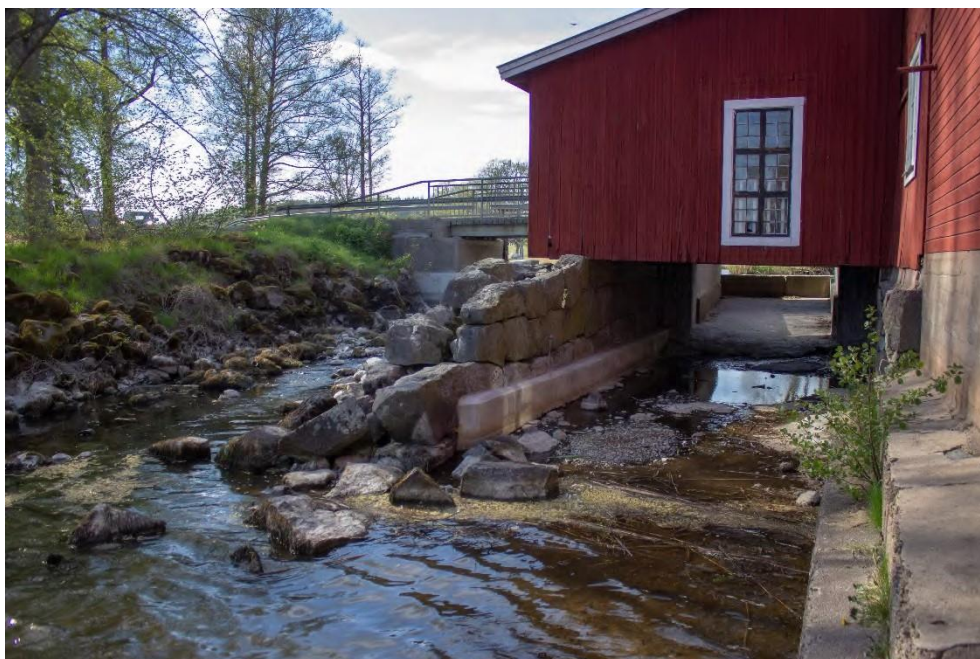
Figur 13. Bild på delar av Ekenäs kvarn och den gamla intagsrännan till kvarnen (till höger). I ovankant syns en gjuten betongkant. Denna fåra skulle kunna användas för att skapa en faunapassage. Foto: Rickard Gustafsson.
