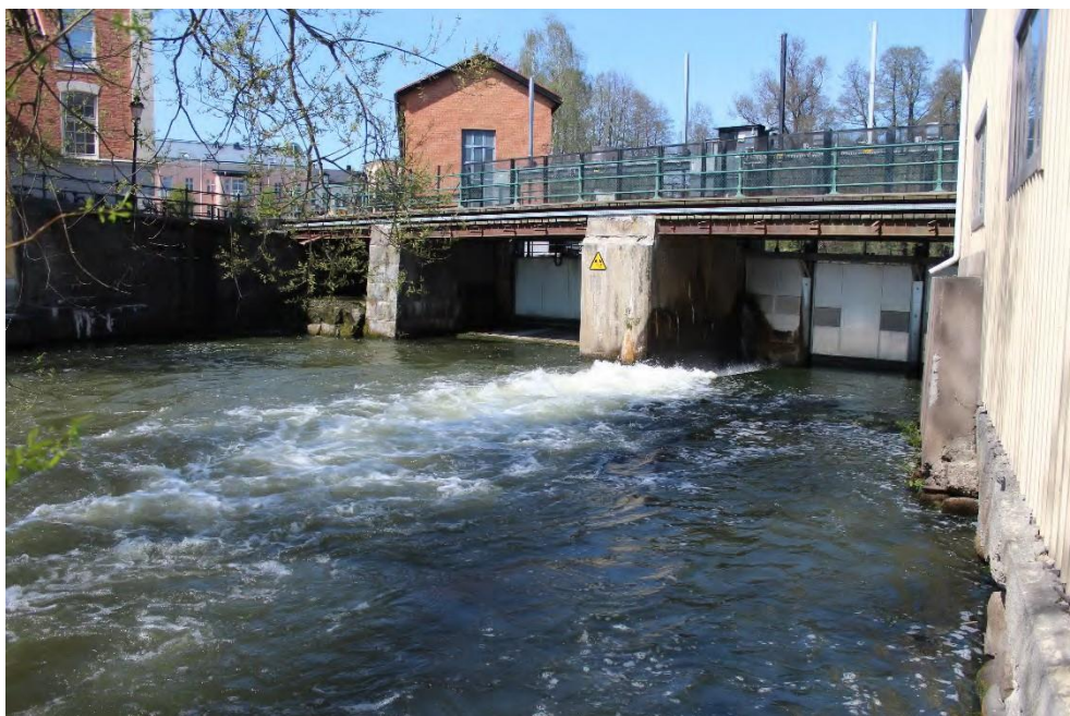
Figur 21. Bild på reglerfåran med automatluckor vid Fors kraftstation. Foto: Rickard Gustafsson.
