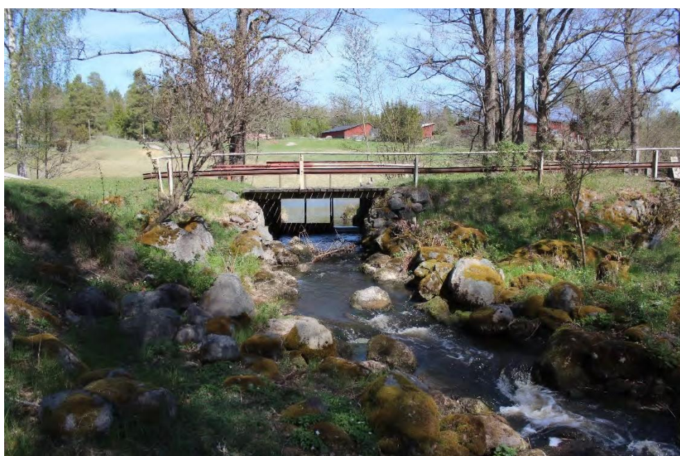
Figur 3. Hålldammen vid Stocktorp är delvis raserad. Foto: Rickard Gustafsson.
