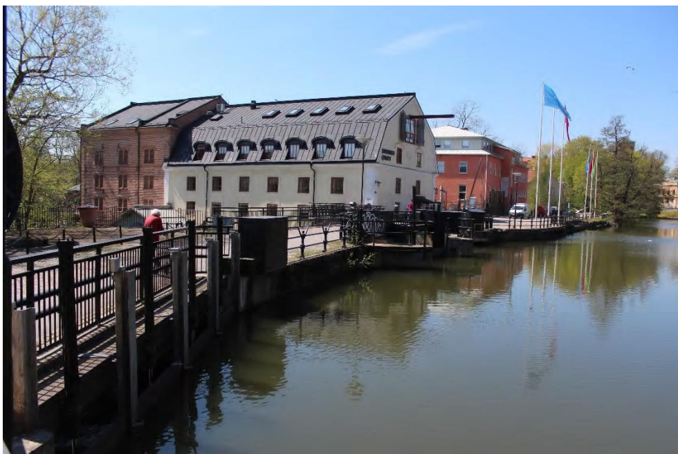
Figur 25. Storhuskvarn sedd uppströms ifrån. Foto: Rickard Gustafsson.
