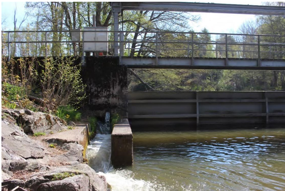
Figur 18. Den otillfredsställande fiskvägen vid Kristineholm syns centralt i bilden. Foto: Rickard Gustafsson.
