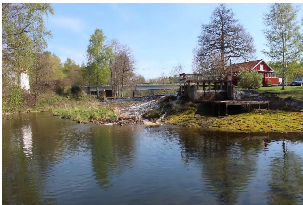
Figur 14. Sibro dämme utgör regleringen av Båven. på bilden syns dämmet sedd nedströms ifrån. Foto: Rickard Gustafsson.
