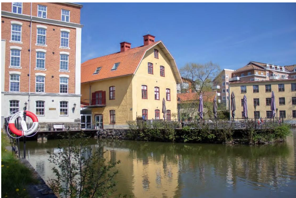
Figur 22. Bild på turbinfåran och byggnader i anslutning till kraftverket. Foto: Rickard Gustafsson.
