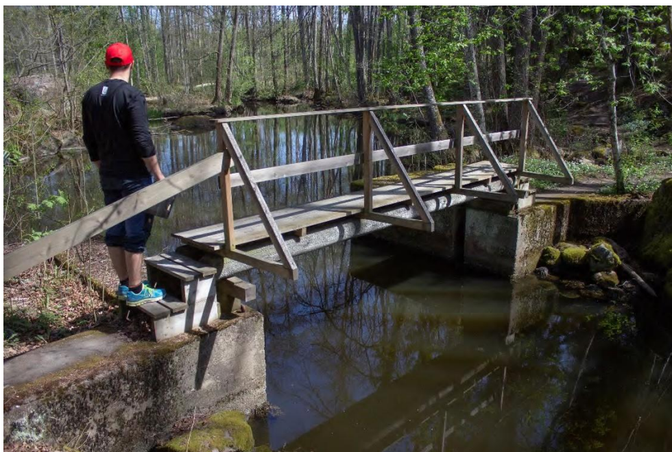
Figur 9. Valdemarens hålldamm tycks inte längre aktiv. Vid inventeringstillfället fanns inga sättar eller spår efter en aktiv damm. Bedömningen var att fisk kan passera konstruktionen obehindrat. Foto: Rickard Gustafsson.
