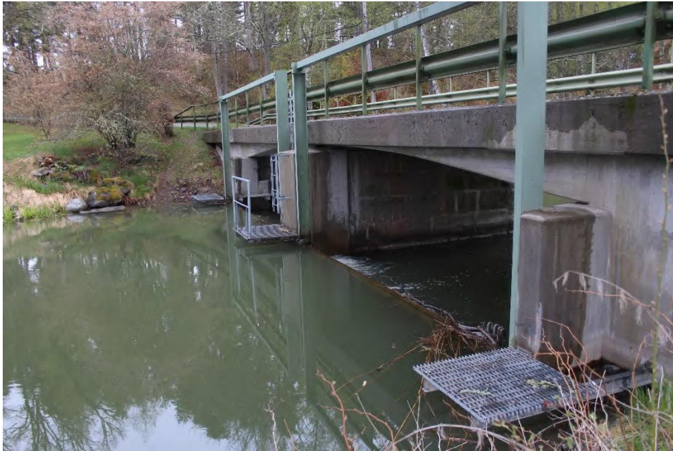
Figur 16. Regleringsdammen vid Vad utgör ett partiellt hinder för fisk. Endast starksimmande arter kan passera vid optimala flöden. Foto: Rickard Gustafsson.
