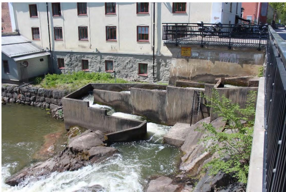
Figur 23. Fisktrappan vid Storhuskvarn är anpassad för starksimmande arter och placeringen felaktig för fisk som ska försöka hitta den. Foto: Rickard Gustafsson.
