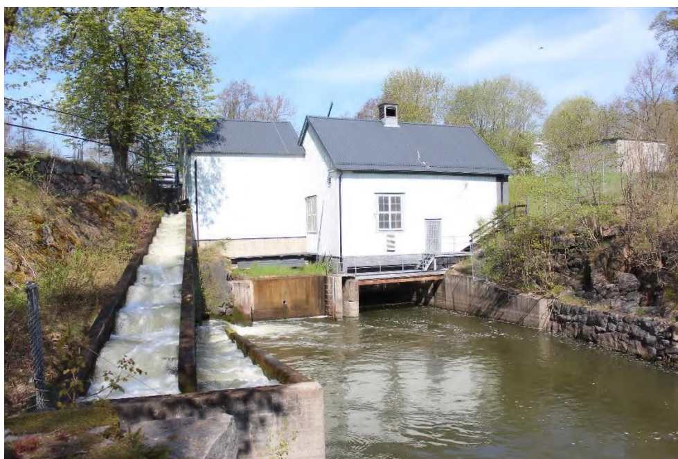
Figur 19. Harg kraftstation med tillhörande faunapassage i form av fisktrappa. Foto: Rickard Gustafsson.
