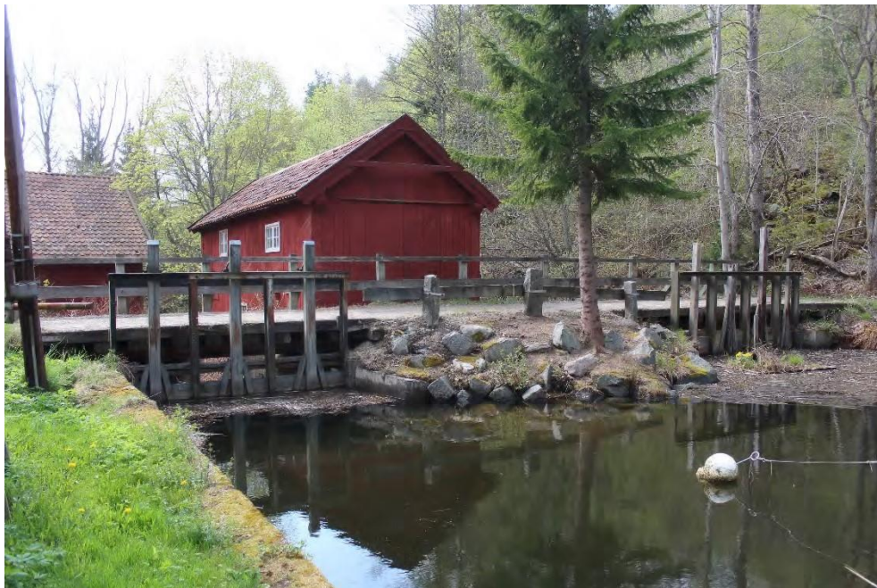
Figur 8. Nässelsta kvarn sedd uppströms ifrån. Genom utrivning av delar av dämnet och byggnation av en sjönacke för uppströmsliggande Kyrksjön skulle passage för fisk och andra vattenlevande organismer kunna skapas. Foto: Rickad Gustafsson.
