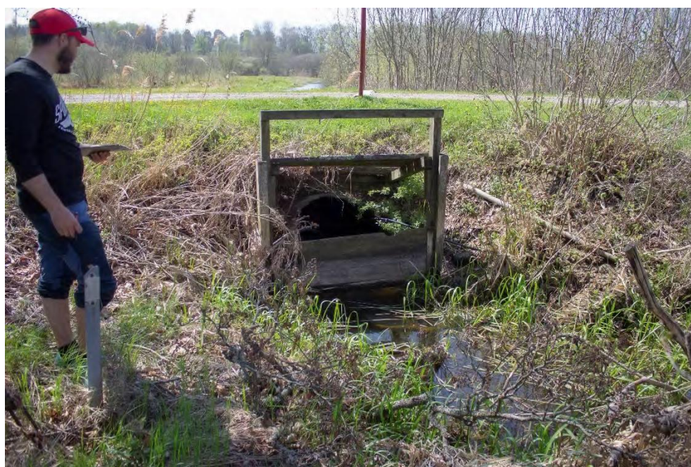
Figur 4. Vid utloppet från Lillsjön intill Långdunkers slott finns en gammal regleringsdamm som är mer eller mindre raserad. Foto: Rickard Gustafsson.
