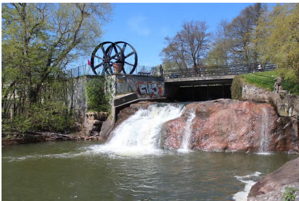
Figur 24. En av två breddfåror vid Storhuskvarn. Vattnet faller fritt över en stenhäll och utgör ett definitivt hinder för fisk. Foto: Rickard Gustafsson.
