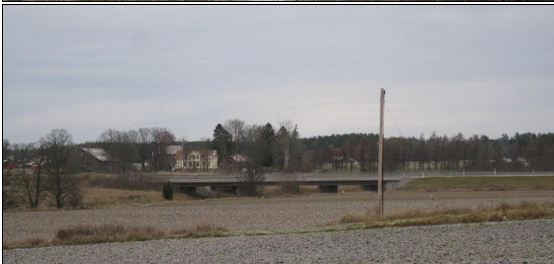
Övre bilden: bron mellan Lilla Stjärna och Fullerö bytomt (Uppsala 207:1). Undre bilden: dagens motorväg med Stora Stjärna i bakgrunden.
