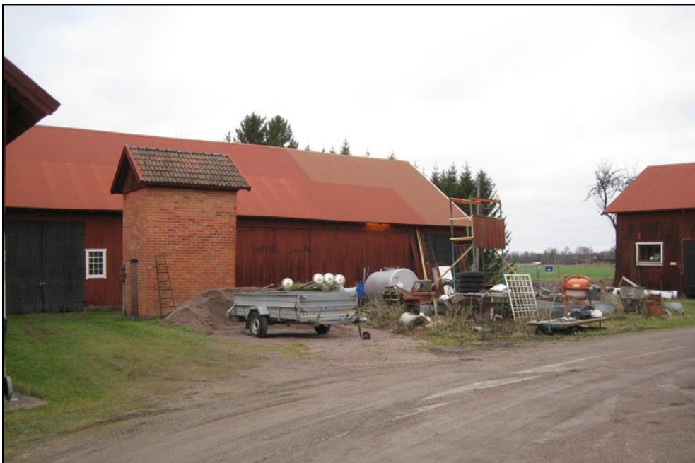
Ladugården med vattencisternen.
