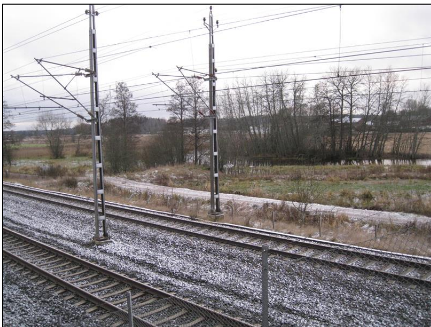
Mellan elstolparna syns rester efter den gamla vägen ( Lena 489 ).
