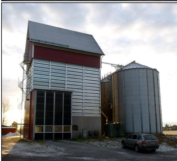
Husby, boningshus och silo.
