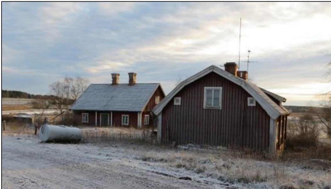
Ånges östra gård med mangårdsbyggnad uppförd på 1700-talet. Foto Ida Dicksson.
