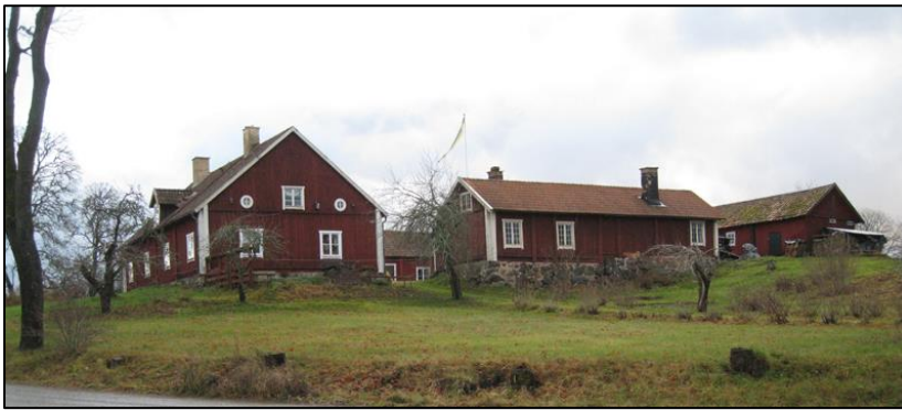
Kringbyggd gård med bl.a. värdshus och tvätt- och mangelhus.
