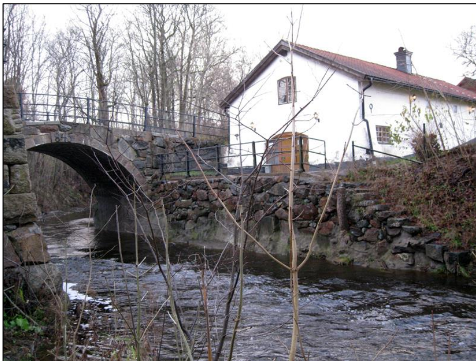
Dagens bagarstuga, bron från år 1845 och rester efter masugnens grund.
