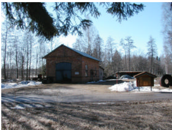
Fig. 2 Industribyggnad på fastigheterna Älvkarleö bruk 4:21 och 4:48.
