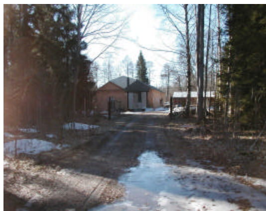
Fig. 3 Industribyggnad på fastigheten Älvkarleö bruk 4:23.
