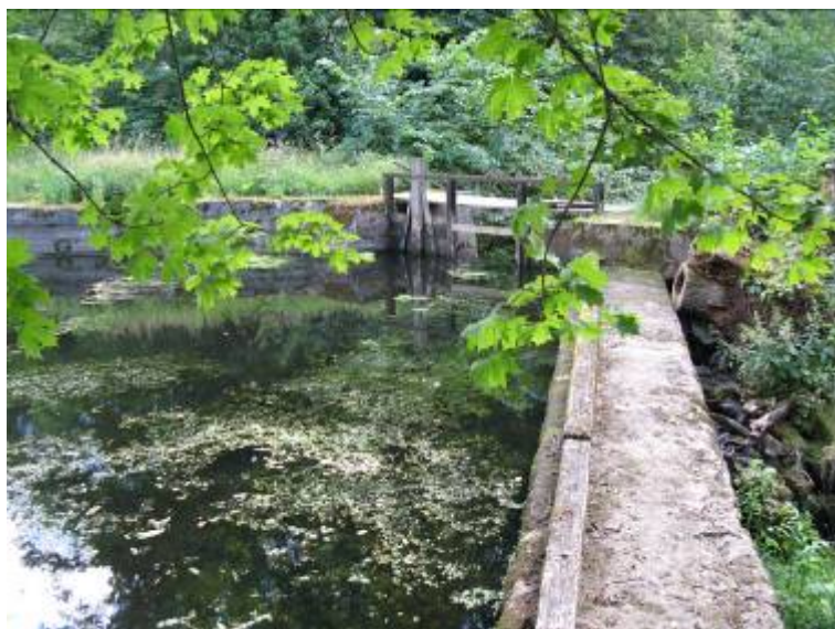
Bild 79: Uppströms tegelbruksdammen Foto: Linda Svensson
