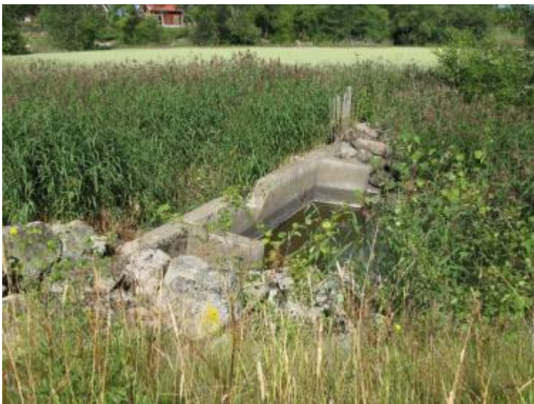
Bild 149: Betongdämme vid Årke Foto: Linda Svensson
