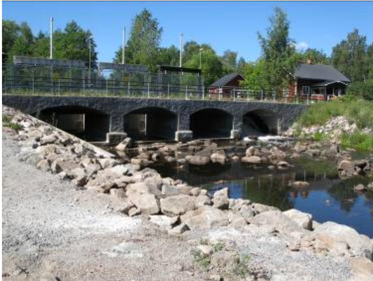
Bild 2: Östtuna kraftstation Foto: Linda Svensson
