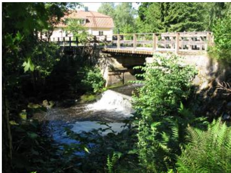
Bild 31: Bruksdammen uppströms Svanåparken Foto: Linda Svensson
