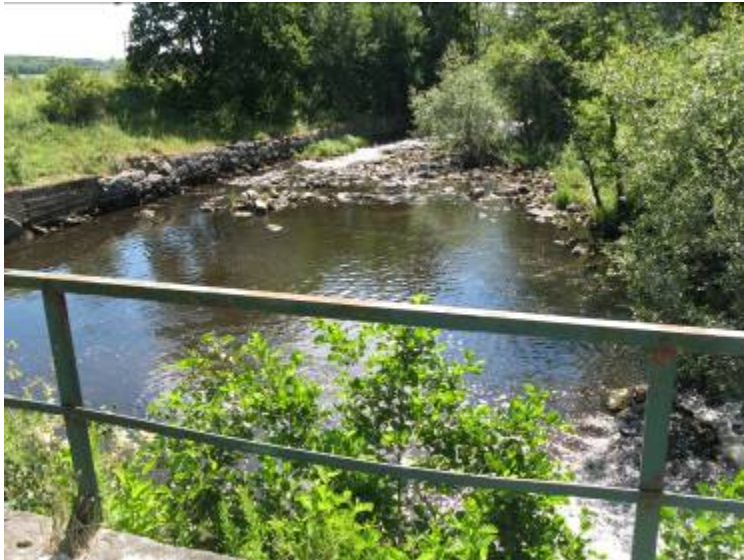
Bild 3: Nedströms Ekeby kraftstation Foto: Linda Svensson
