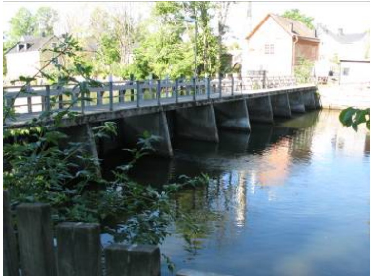
Bild 93: Dam uppströms stora kvarnfallet i Torshällaån
