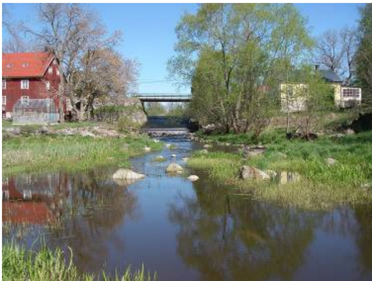
Bild 62: Dammen vid Nykvarn i Sagån Foto: Joel Berglund
