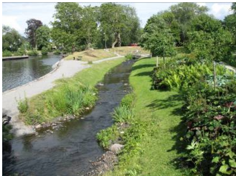
Bild 100: Befintlig fiskväg med undermålig funktion för stor fisk som asp. Foto: Linda Svensson
