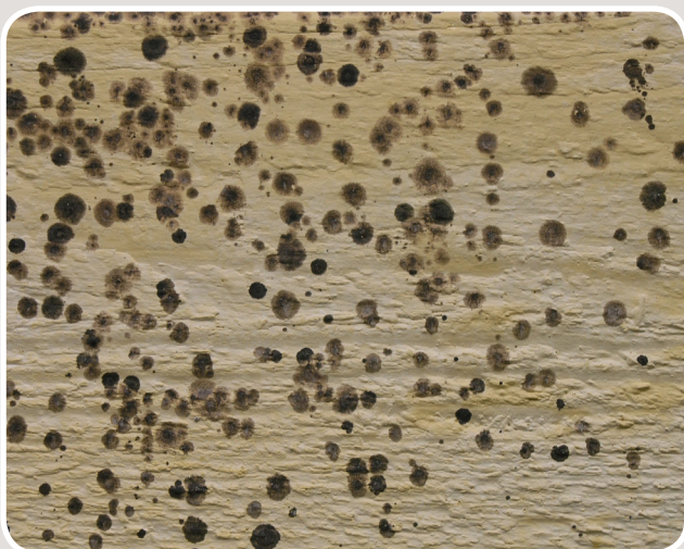
Svartmögel på fasad, Foto: MYCOTEAM
