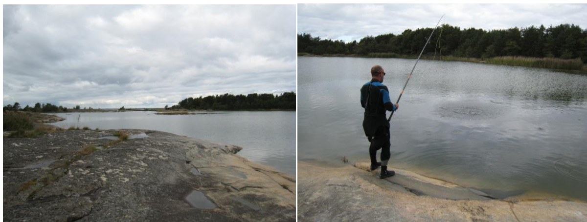
Bryggebåddalen längs södra stranden mot mynningen samt sprängning från land i vikens inre del. Genom att inte spränga från båt där det är möjligt kan skottpunkten vara mycket ostörd innan skottet.
