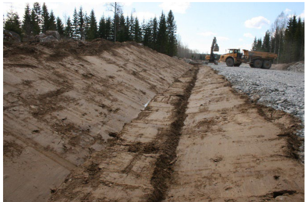
Figur 13 Foto: Erik Sjödin. Bilden visar hur man vid anläggandet av väg skapar en sandslänt invid vägen.
